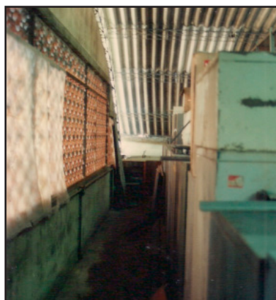
Figura 2 – Depósito 1 – janela com tijolos vazados
