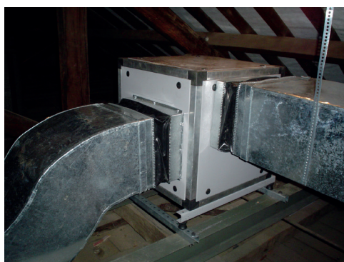
Figura 3- Instalação de ventilador de exaustão no sótão.
