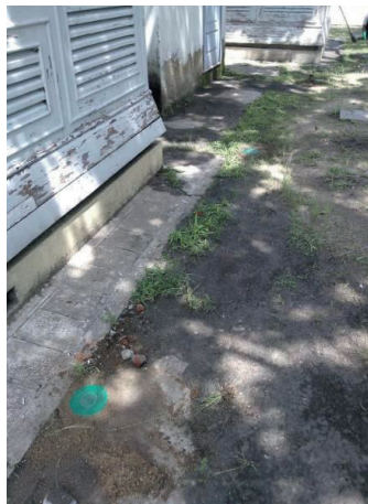
Figuras 18 e 19: Instalação do sistema de iscagem subterrânea de cupins no campus Museu de Astronomia e Ciências Afins
