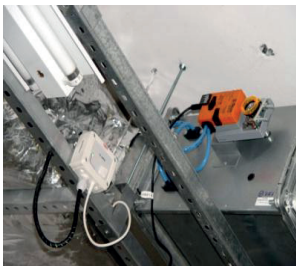
Figura 27 VAV: controle de fluxo do ar
