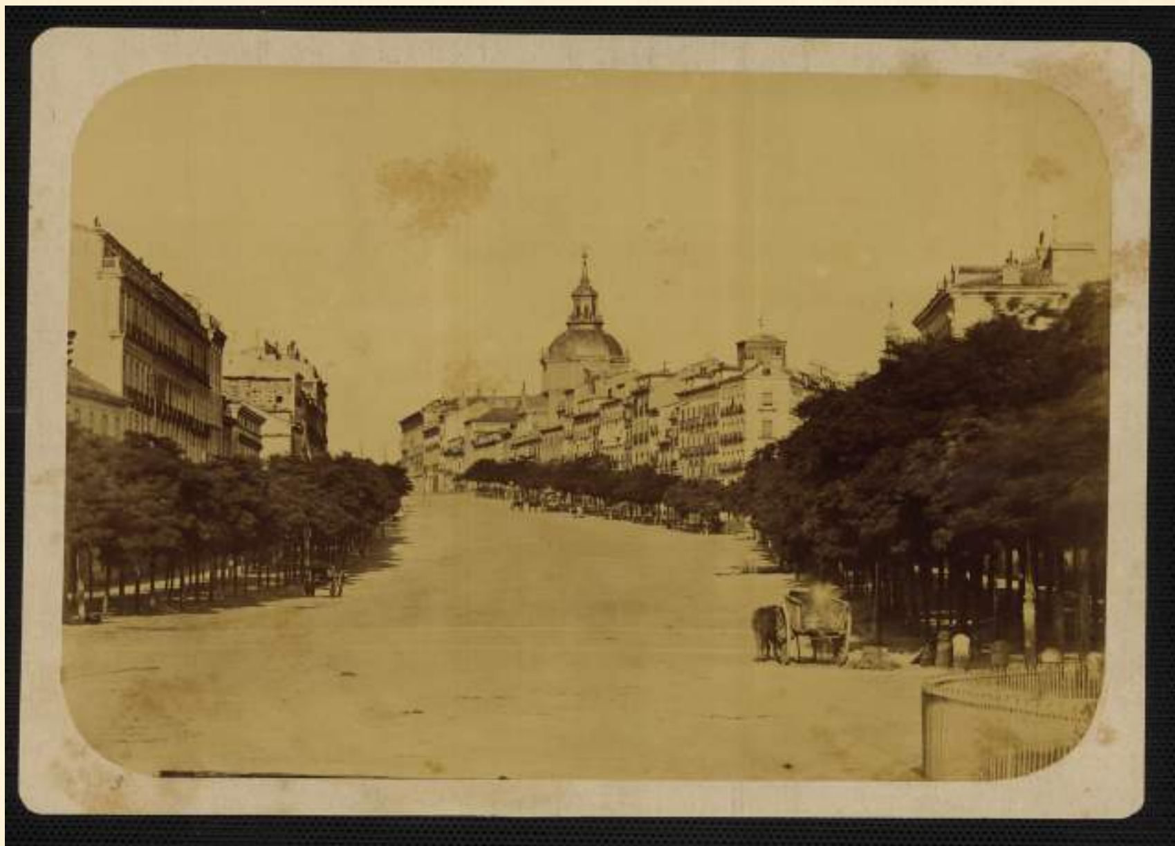
Foto 5. Rua de Alcalá em Madrid.
