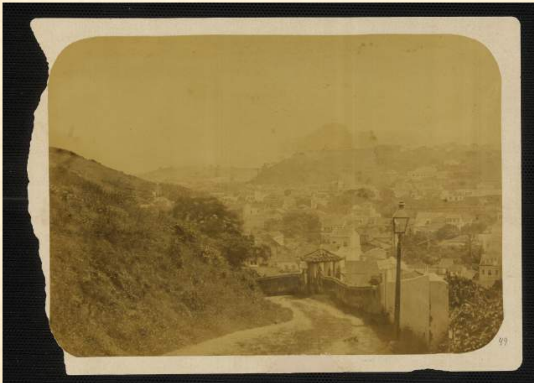
Foto 50. Sta. Thereza: vista do bairro do Catete.
