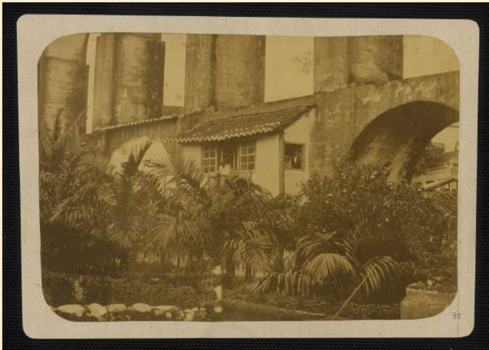
Foto 36. O aqueduto de Sta. Thereza.
