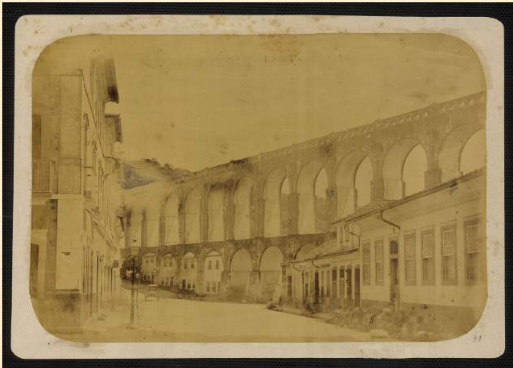
Foto 32. O aqueduto de Sta. Thereza.
