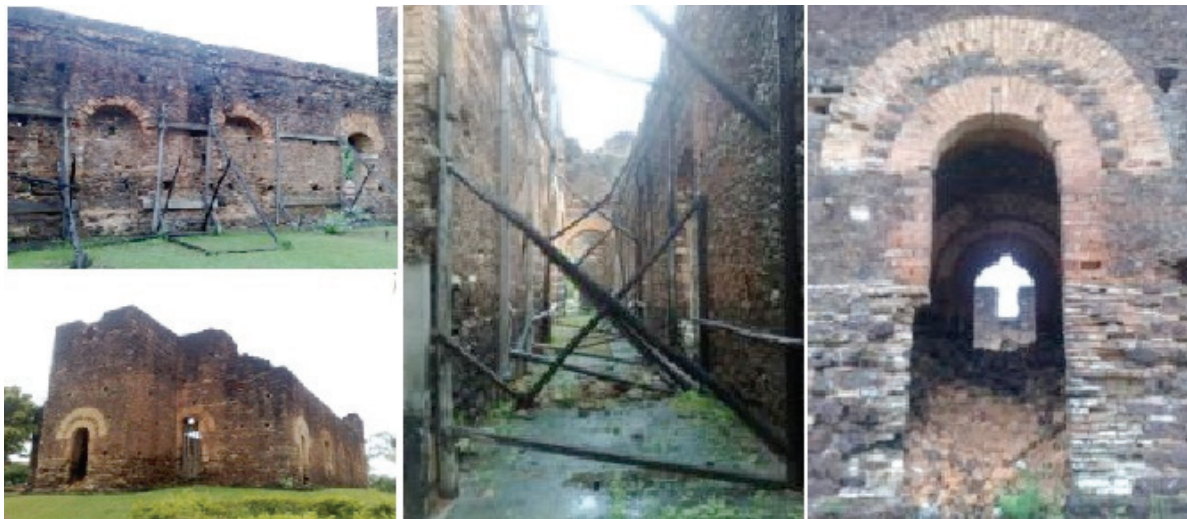
Figura 03 – Escoramento da estrutura e parte que já desabou. Foto: Priscila de Jesus (abril/maio de 2011).
