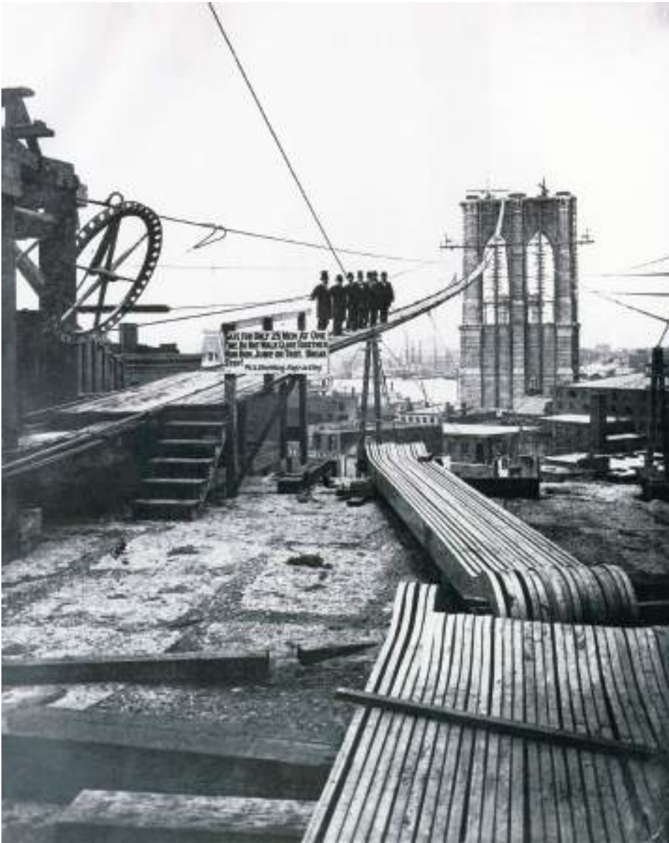
Ponte de Brooklin em construção (Nova York). Fotógrafo desconhecido, 1878.
