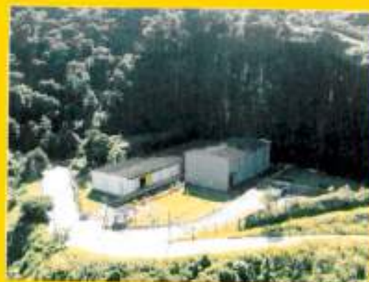
O rejeito radioativo é estocado em instalação de segurança, para impedir acidentes, vazamentos ou deterioração. A CNEN é a responsável pela guarda. Usina de Angra (RJ)
