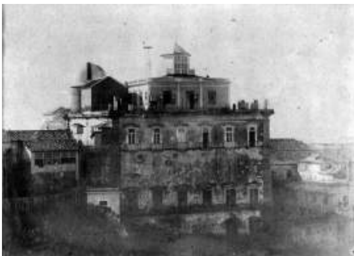
Observatório do Rio de Janeiro no Morro do Castelo, 1905. Foto: Marc Ferrez. (LC.F.0005).
