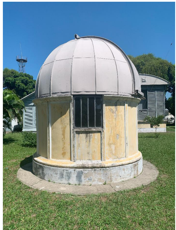
Figura 29 : Cúpula da Luneta equatorial do foteheliografo, no campus MAST/ON.
