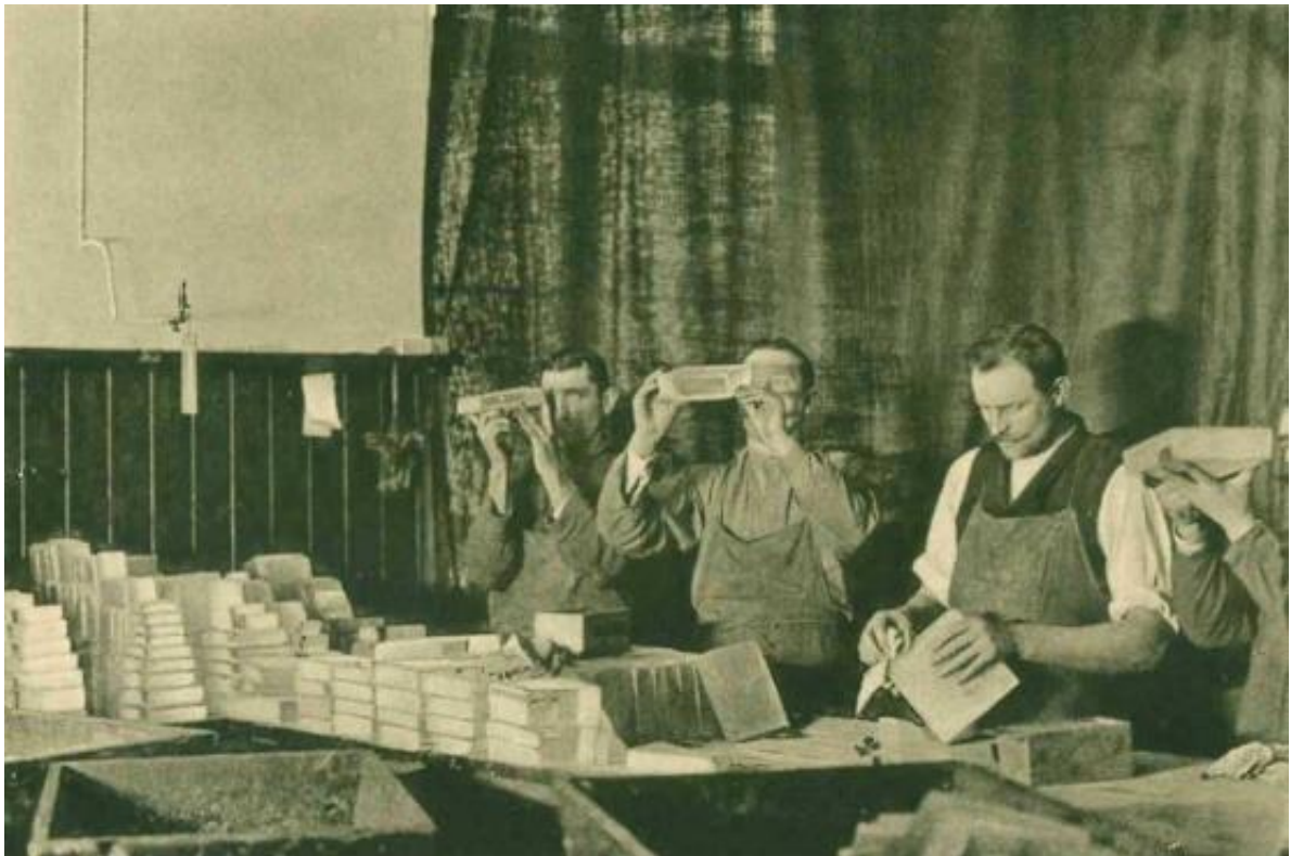
Figura 11 : Trabalhadores realizando inspeção e separação dos blocos de material vítreo, na Schott AG.
