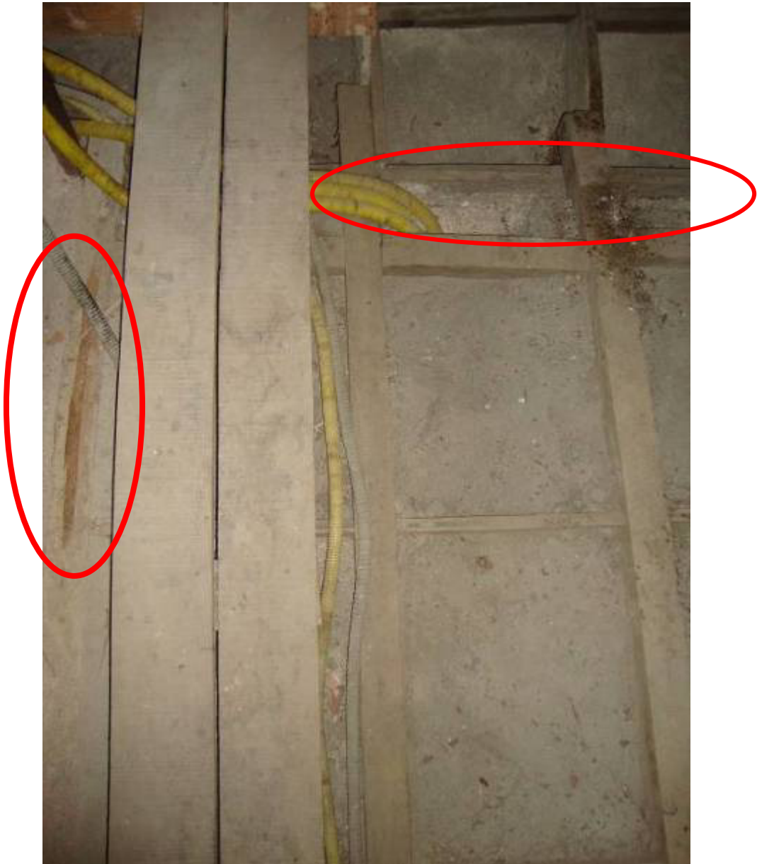
Figura 3 - Áreas em destaque por linha vermelha: resquícios de fezes de morcego e passarela de acesso no interior do telhado sobre o forro da sala 2. Fotografia: Ivo Almico, 03/05/2013.
