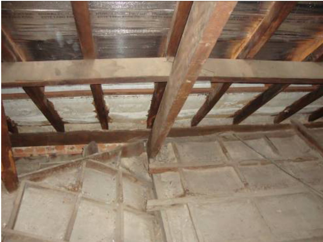
Figura 6 - Malha estrutural de madeira na área de interseção de forro com o telhado sobre a sala 2. À esquerda da fotografia, destaca-se parte do forro inclinado sobre a biblioteca. Fotografia: Ivo Almico, 03/05/2013.
