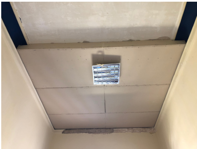
Figura 15 - Vista para lado da janela área afetada no teto da sala 2, onde se vê lacuna na sanca. Fotografia: Ivo Almico, 14/08/2018.
