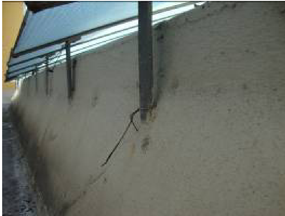
Figura 24 - Detalhe da fixação da chapa metálica na gola de alvenaria. Fotografia: Arquivo do SEPTC/COMUS.
