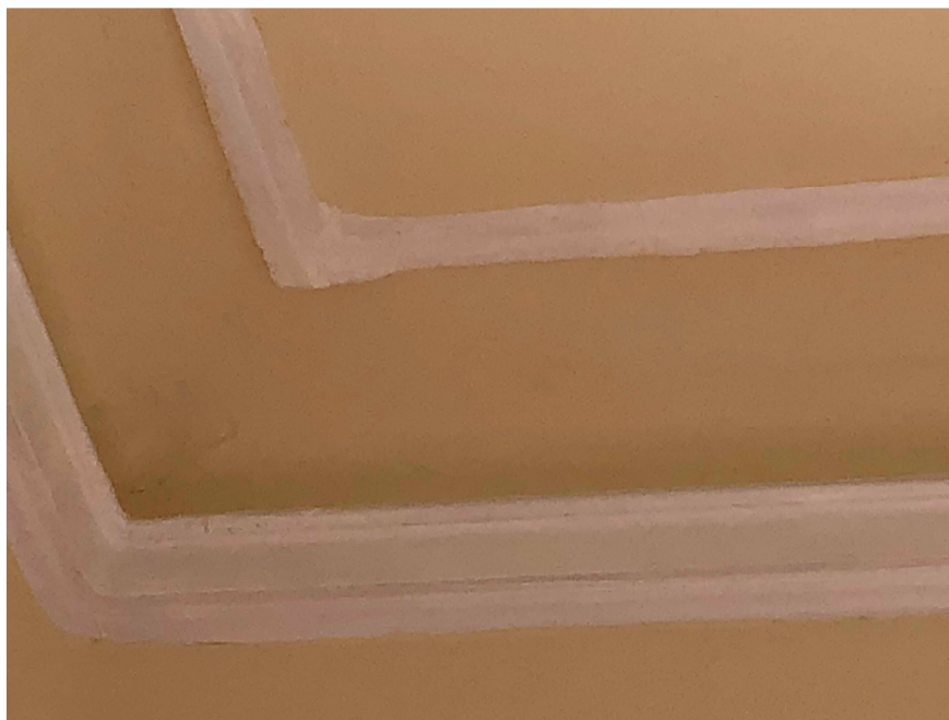
Figura 16 - Detalhe no teto da sala 3 - frisos do teto com lacunas em alguns trechos Fotografia: Ivo Almico, 14/08/2018.
