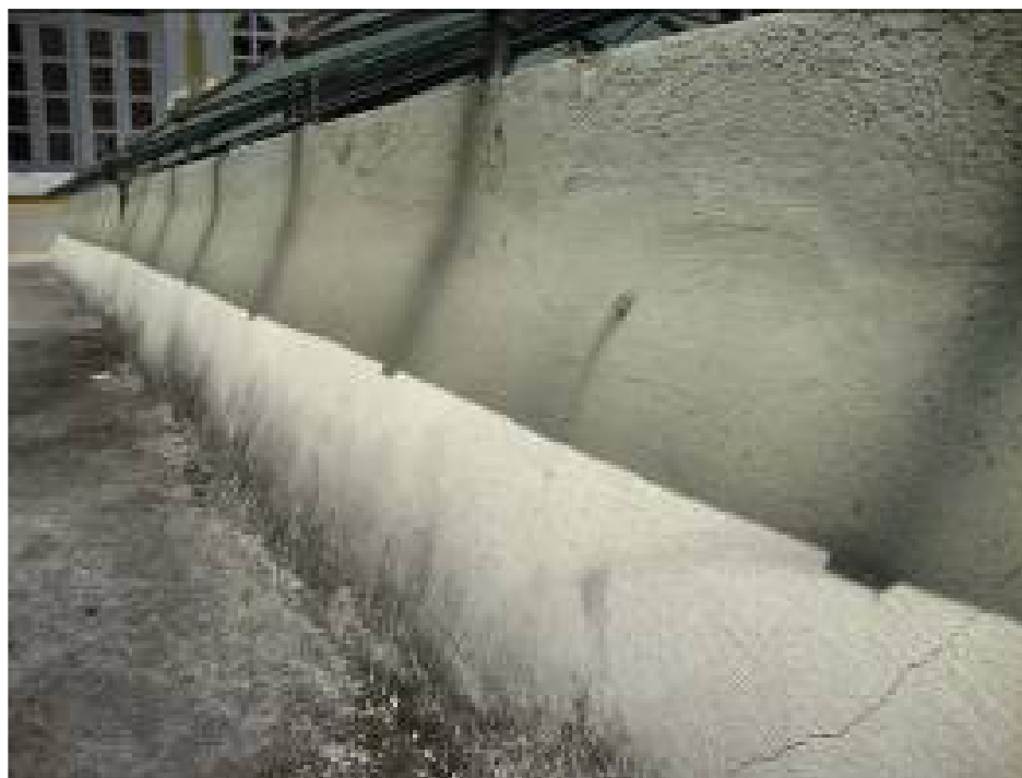
Figura 19 - Base de alvenaria para o apoio da estrutura. Fotografia: Arquivo do SEPTC/COMUS.
