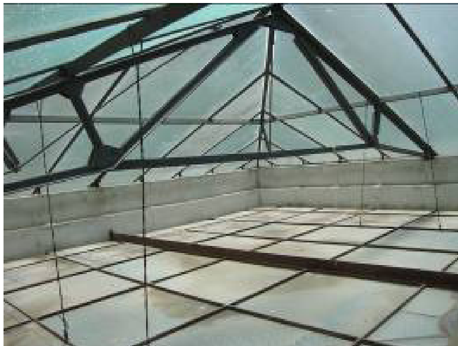
Figura 21 - Vista interna da clarabóia mostrando a tesoura da estrutura metálica. Fotografia: Arquivo do SEPTC/COMUS.
