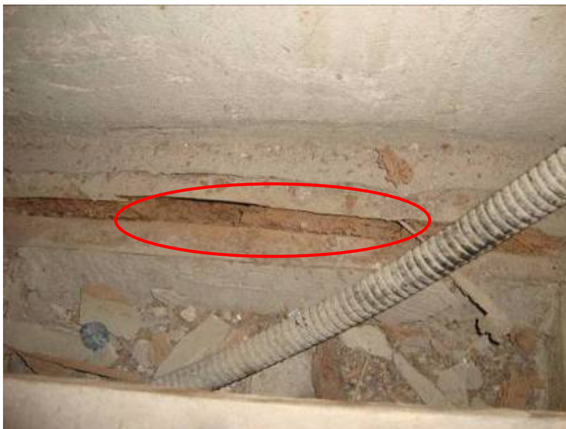
Figura 2 - Resquício do ataque de xilófagos. Fotografia: Ivo Almico, 03/05/2013.
