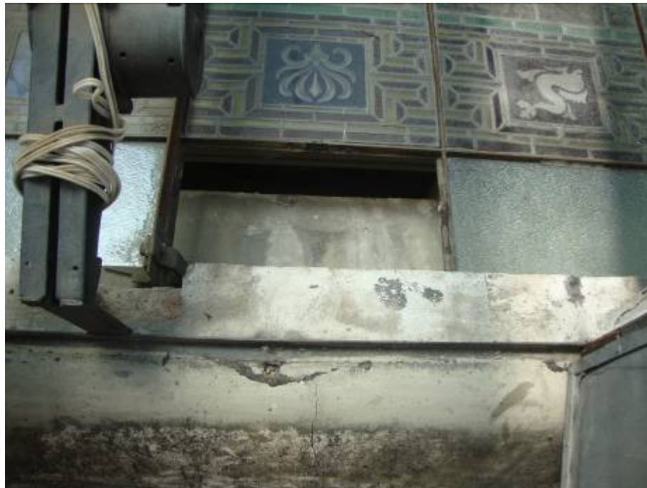
Figura 26 - Lacuna: peça de vidro ausente. Fotografia: Arquivo do SEPTC/COMUS.
