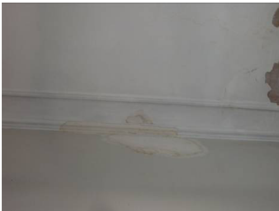
Figura 161 - Detalhe no teto da sala 3 - manchas de umidade descendente. Fotografia: Ivo Almico, 03/05/2013.
