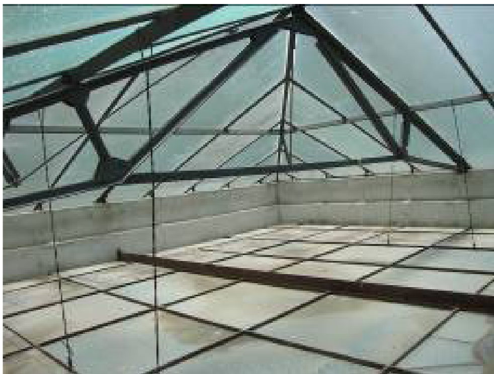
Figura 26: Vista interna da clarabóia mostrando a tesoura da estrutura metálica. Fotografia: Arquivo do SPT/CMU
