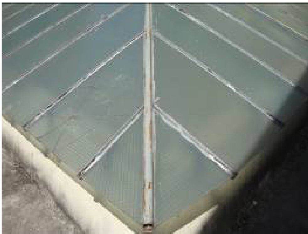
Figura 27: Peça de vidro quebrada. Fotografia: Arquivo do SPT/CMU
