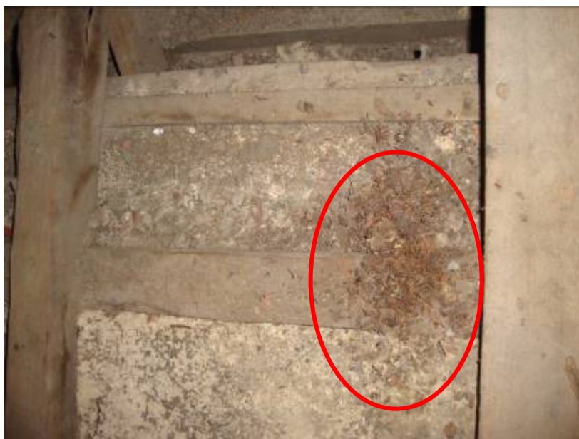
Figura 92 - Resquícios de fezes de morcego. Fotografia: Ivo Almico, 13/65/2013.
