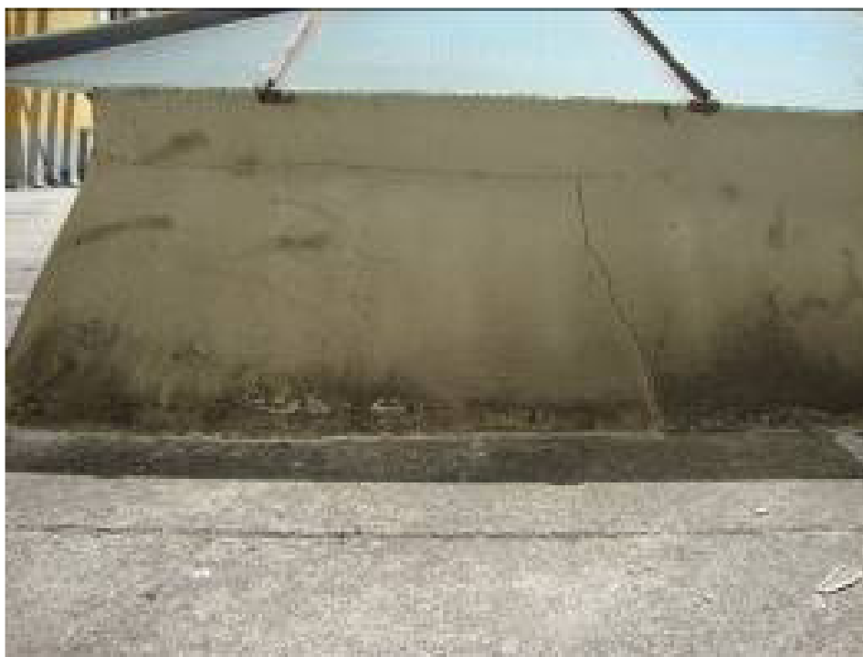
Figura 33: Fissuras na argamassa. Fotografia: Arquivo do SPT/CMU
