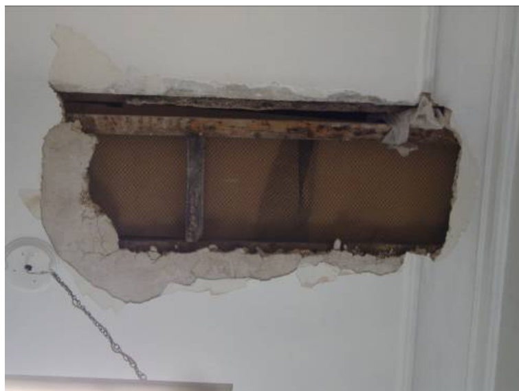
Figura 19 - Detalhe de lacuna no forro da sala 3 - é possível observar o madeiramento estrutural e a tela Deployée de composição da argamassa do forro. Fotografia: Ivo Almico, 03/05/2013.
