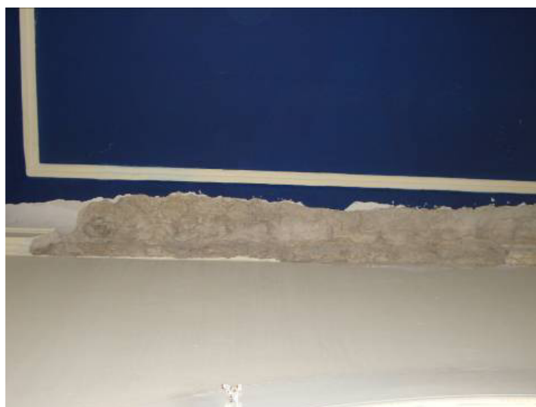
Figura 136 - Área deteriorada - lacuna na sanca por desprendimento de material original, possivelmente ocasionado por umidade descendente originada anteriormente às obras de restauração da cobertura do
