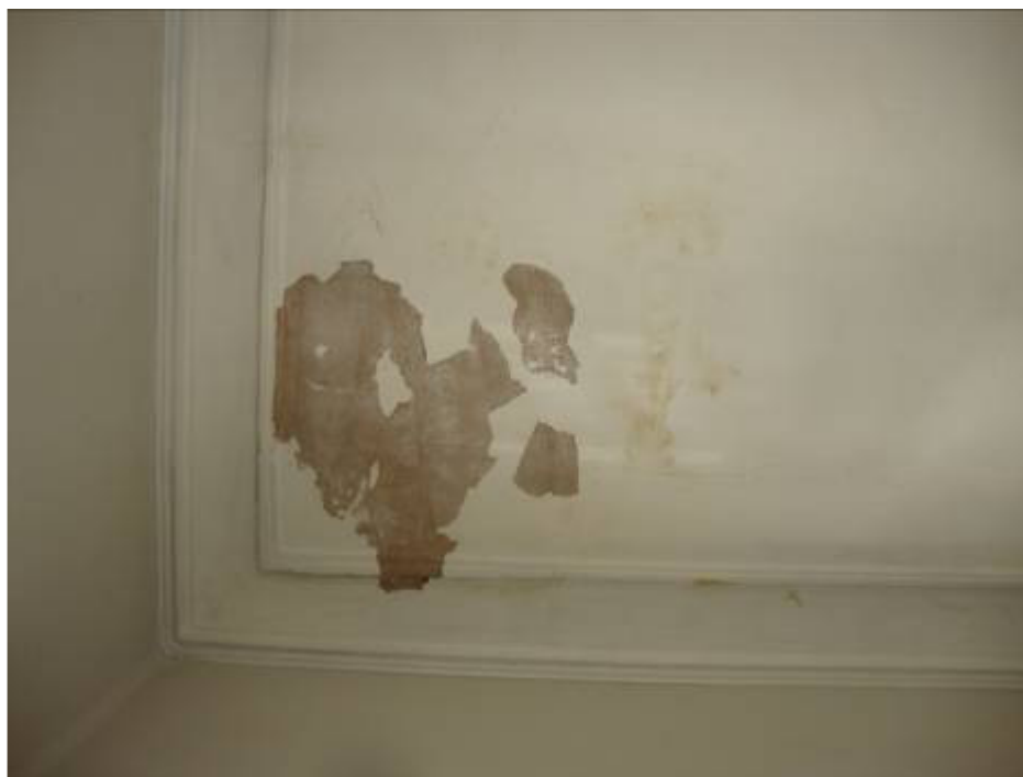
Figura 150 - Detalhe no teto da sala 3 - descolamento pictórico e manchas de umidade descendente. Fotografia: Ivo Almico, 03/05/2013.
