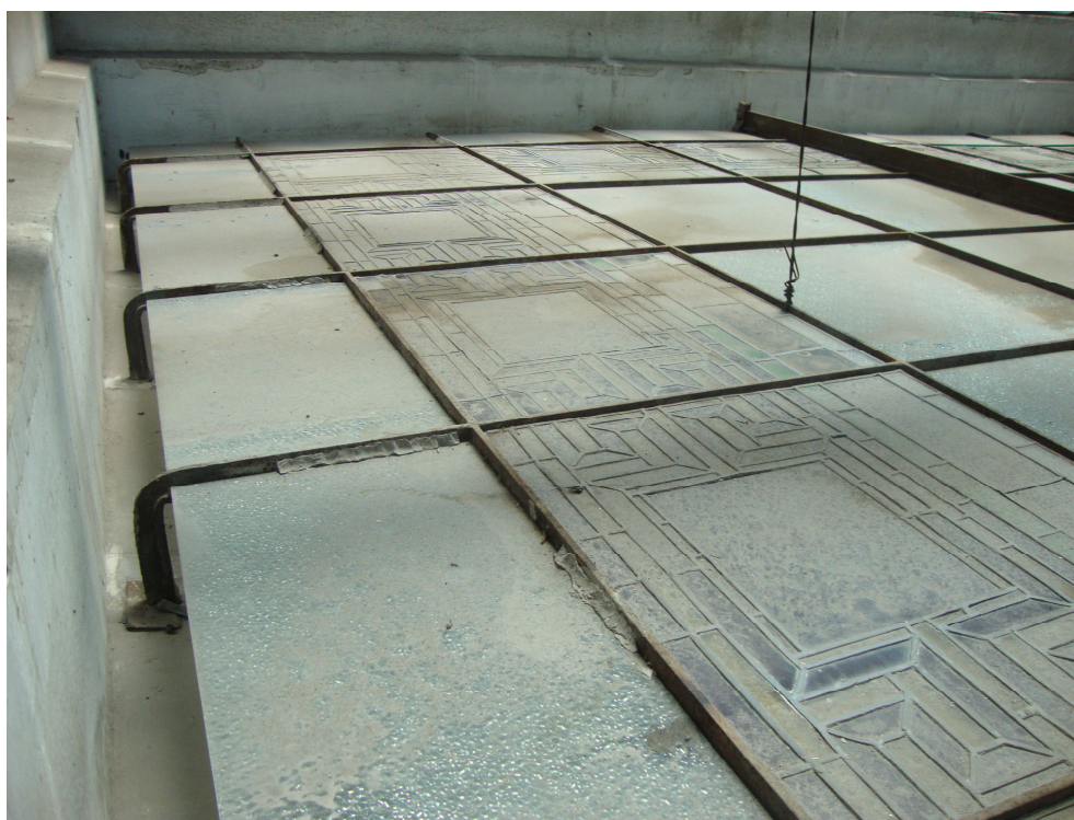
Figura 32: Conservação: acúmulo de sujidades sobre o vitral. Fotografia: Arquivo do SPT/CMU
