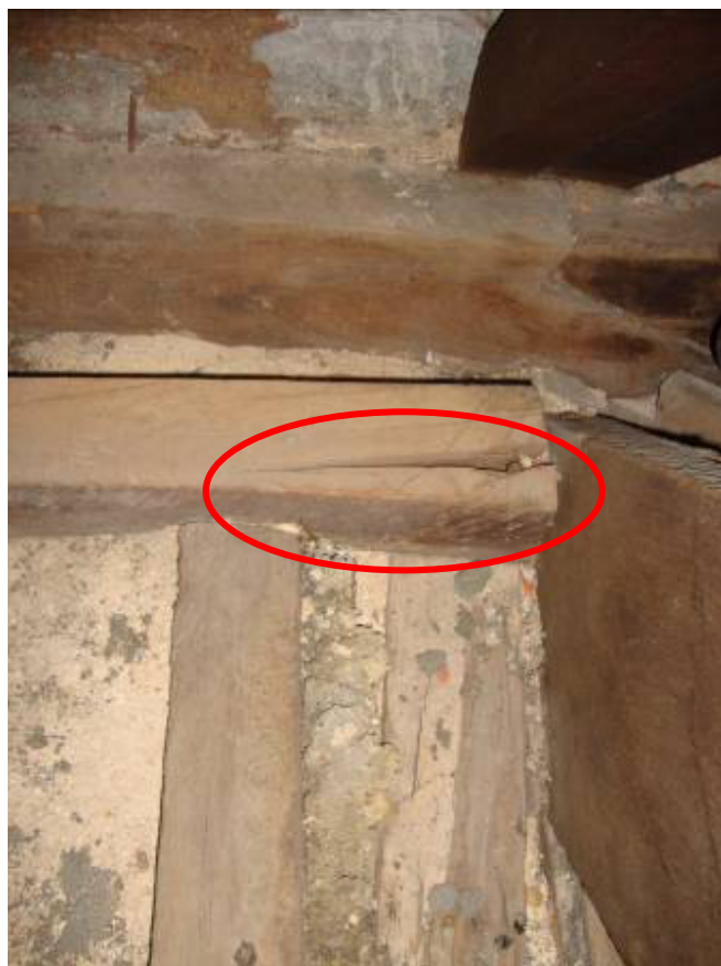
Figura 103 - Trinca aparente em peça de madeira da estrutura. Fotografia: Ivo Almico, 13/06/2013.
