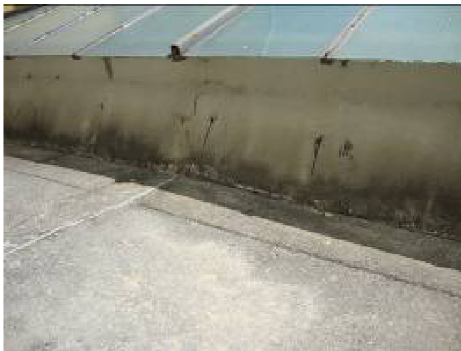
Figura 30: Fissura entre a gola de alvenaria e a laje do terraço de cobertura do edifício. Fotografia: Arquivo do SPT/CMU
