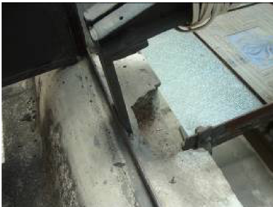
Figura 34: Lacuna da alvenaria no ponto de fixação da estrutura metálica. Fotografia: Arquivo do SPT/CMU
