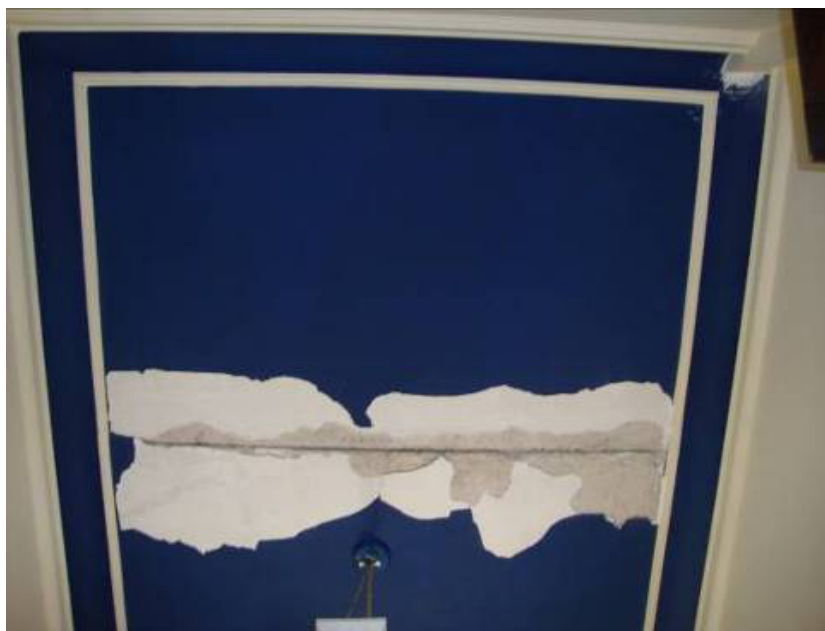
Figura 125 - Área deteriorada do forro da sala 2 - fratura transversal, desprendimento e flexão na área de encontro do forro com a laje do piso superior. Fotografia: Ivo Almico, 03/05/2013.
