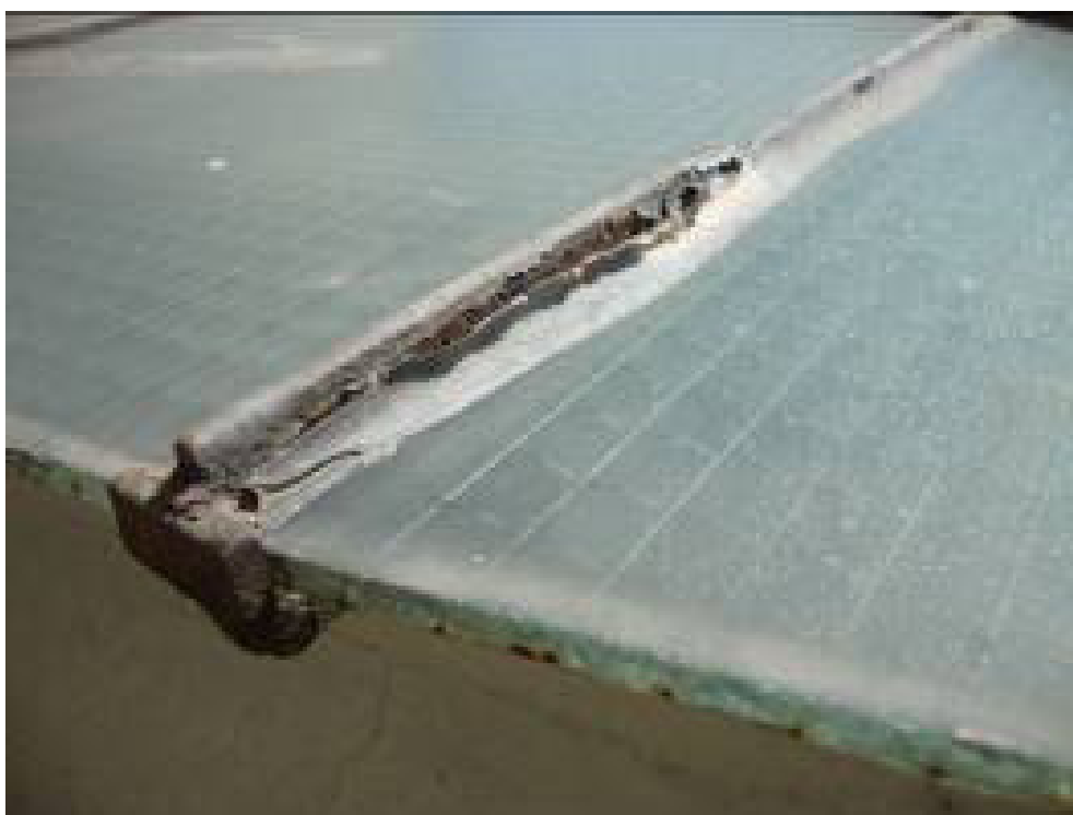
Figura 28: Detalhe do encontro do perfil metálico e a folha de vidro aramado com desprendimento do material. Fotografia: Arquivo do SPT/CMU
