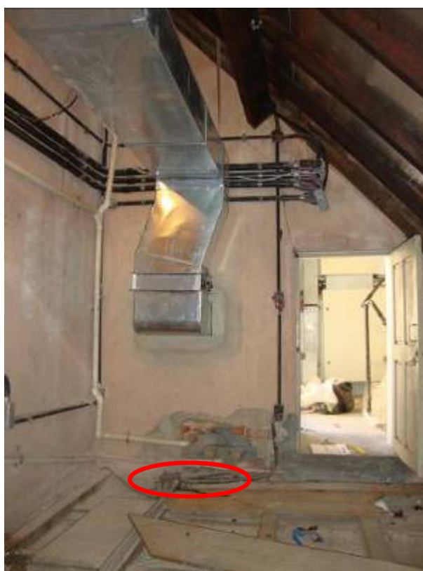
Figura 8 - Vista do interior do desvão sobre a sala 3 - em destaque a área deteriorada por insetos xilófagos. A porta de acesso tem passagem pela escada para a visita de manutenção. Fotografia: Ivo Almico, 03/05/2013.
