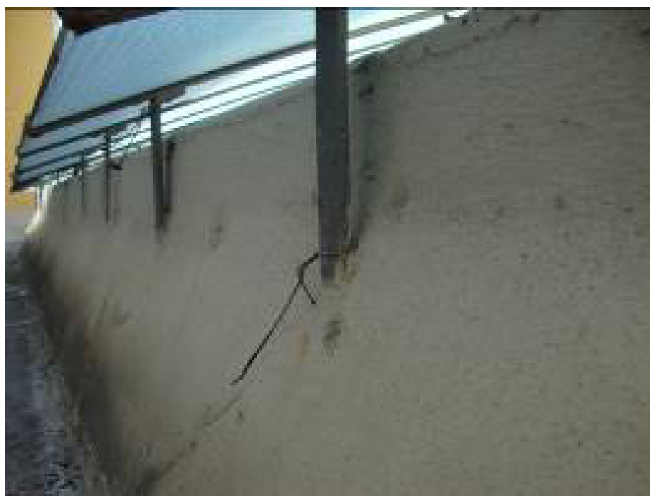
Figura 29: Detalhe da fixação da chapa metálica na gola de alvenaria. Fotografia: Arquivo do SPT/CMU
