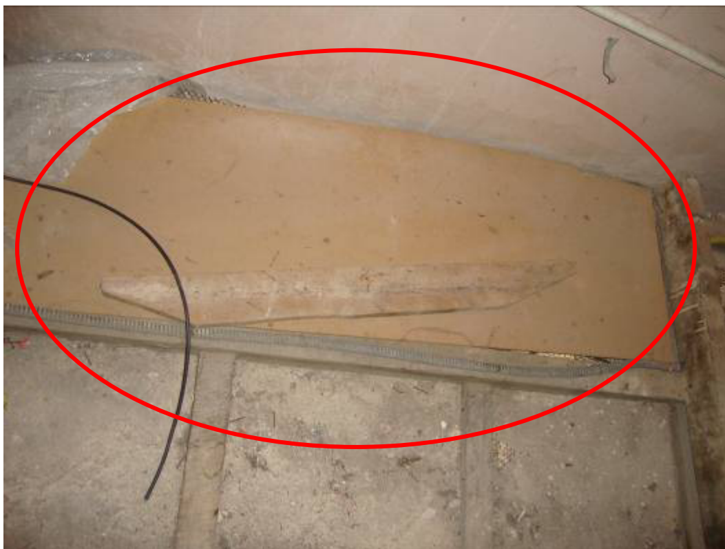
Figura 114 - Área com grande lacuna (coberta por placa de MDF) no forro da sala 3 - parte do forro sofreu desprendimento devido às deteriorações da tela Deployée e de parte da estrutura de madeira. Fotografia: Ivo Almico, 03/05/2013.
