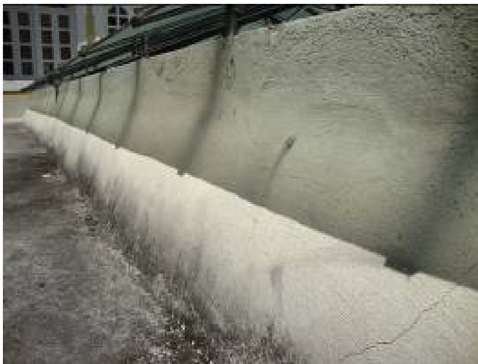
Figura 184: Base de alvenaria para o apoio da estrutura. Fotografia: Arquivo do SPT/CMU
