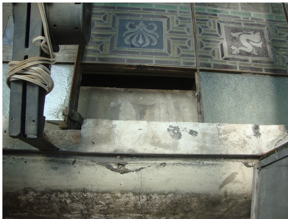
Figura 31: Lacuna: peça de vidro ausente. Fotografia: Arquivo do SPT/CMU
