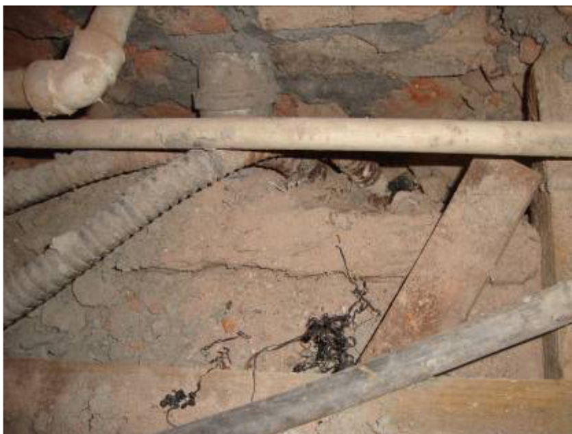
Figura 9 - Detalhe mostrando área deteriorada por insetos xilófagos, além de instalações elétricas e hidráulicas antigas. Fotografia: Ivo Almico, 03/05/2013.
