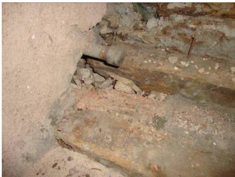
Figura 81 - Argamassa e partes da madeira de estrutura deterioradas e tubulação antiga aparente. Fotografia: Ivo Almico, 13/06/2013.
