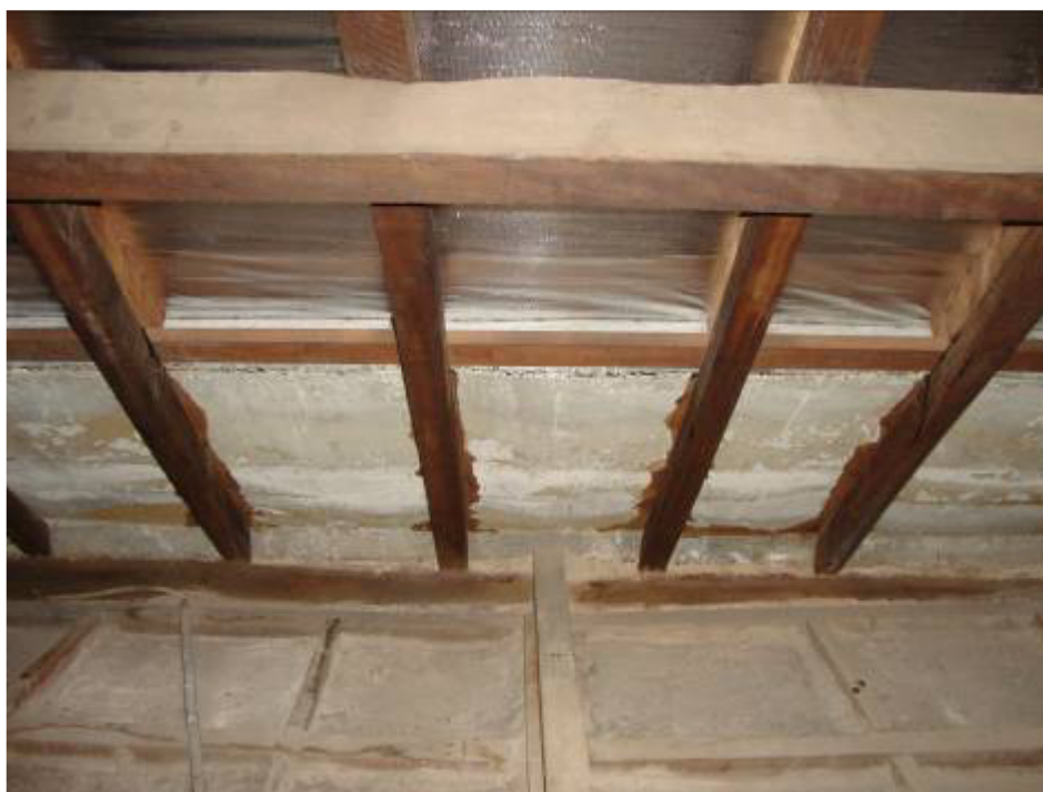
Figura 5 - Área do desvão sobre a sala 2 - a estrutura de madeira possui interseções de apoio com a estrutura do telhado. Fotografia: Ivo Almico, 03/05/2013.
