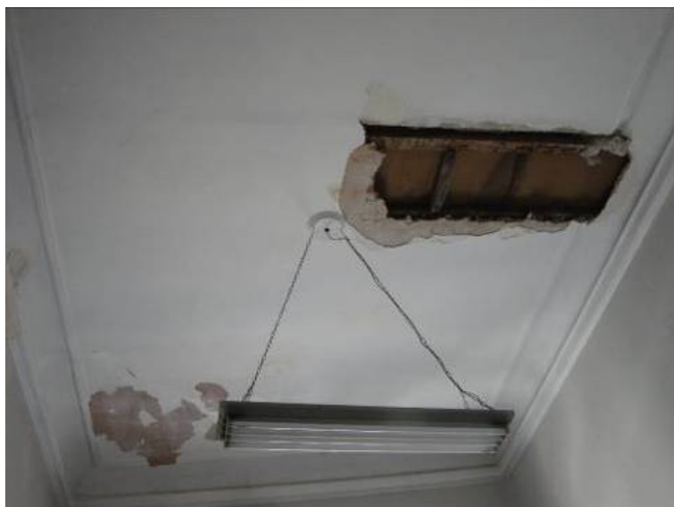
Figura 18 - Vista geral de áreas afetadas no teto da sala 3. Desprendimento de parte pictóricas e lacuna do material de composição do forro. Fotografia: Ivo Almico, 03/05/2013.
