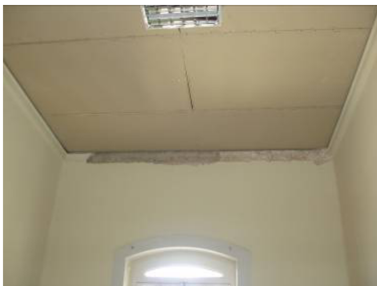
Figura 172 - Forro provisório. Fotografia: Roberto Arrais, 22/02/2017.
