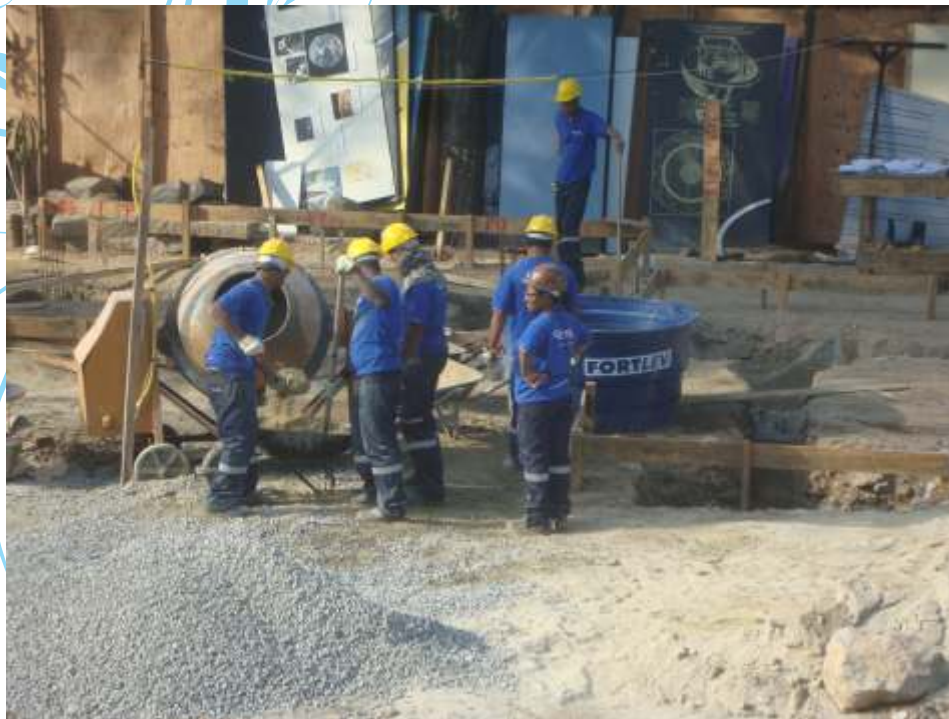
Etapa de escavação dos furos e concretagem das sapatas do Centro de Visitantes (agosto de 2015)
