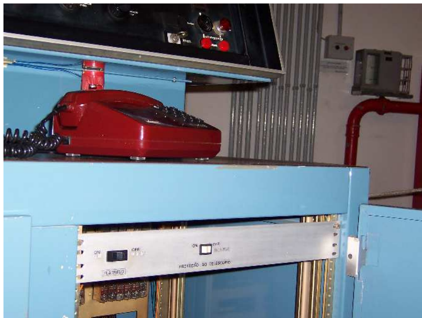
Figura 3.13 Localização do interruptor das lâmpadas de flat-field de cúpula.
