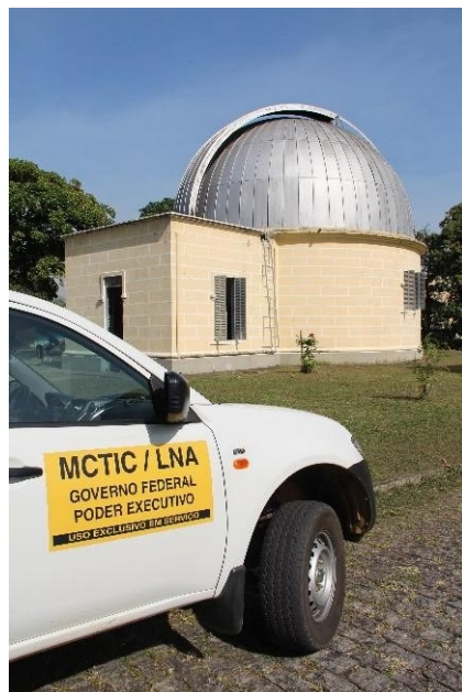
A cúpula da luneta de 46cm recebeu a visita dos técnicos do OPD
