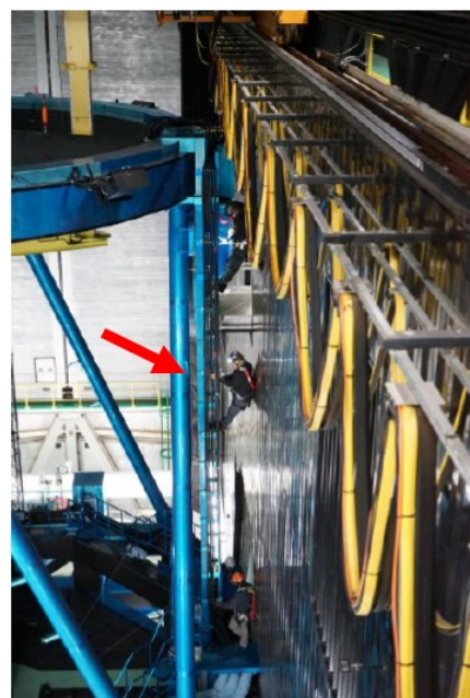
2ª. etapa: fixando cabo na lateral do telescópio
