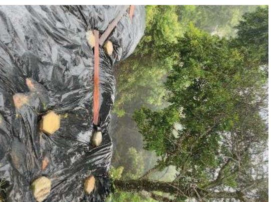
Figura 4: Solução preventiva com utilização de lona plástica.
