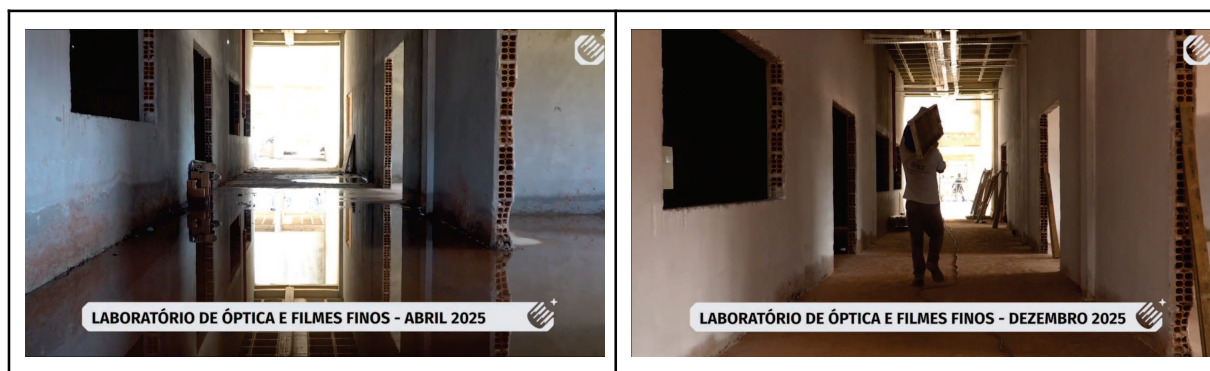
Figura 1 - Registro fotográfico do andamento da construção civil da IMDCT-LNA até o final de 2025
