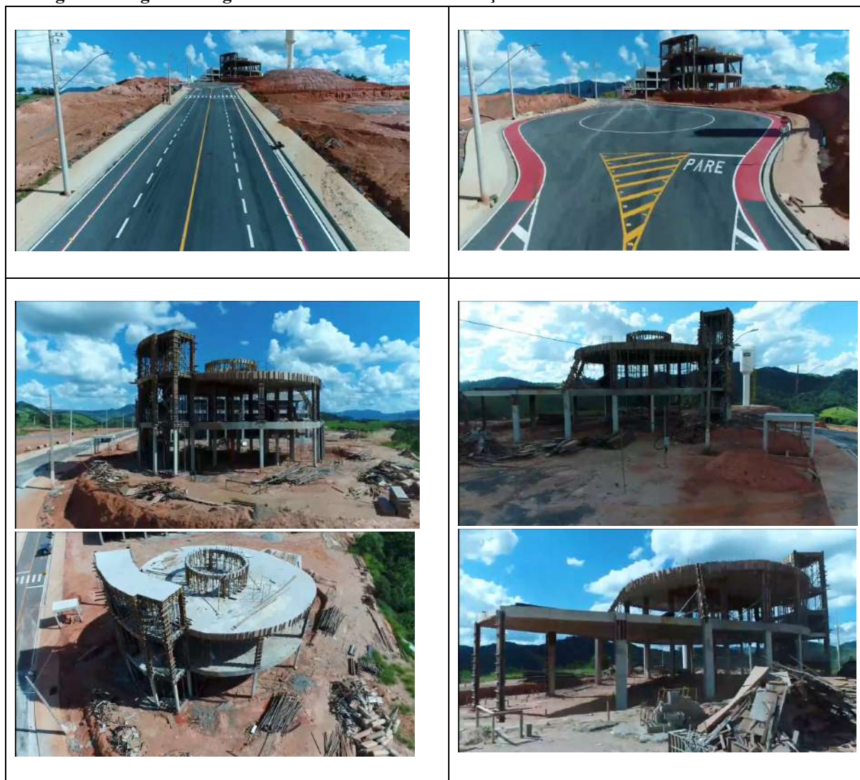
Figura 2: Registro fotográfico do andamento da construção civil da IMDCT-LNA até o final de 2024
