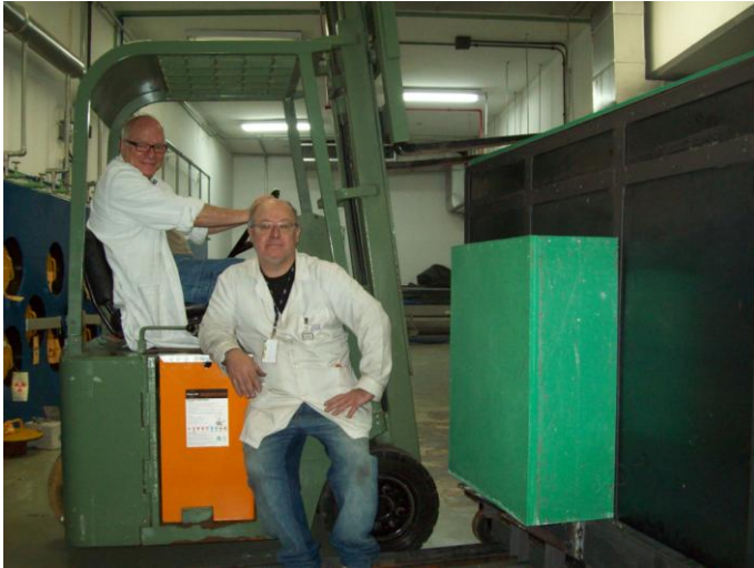
Figura 61. Finalização da instalação do novo tubo colimador com o posicionamento do beam catcher , o último estágio que compõe o equipamento de imageamento com nêutrons do IPEN.
