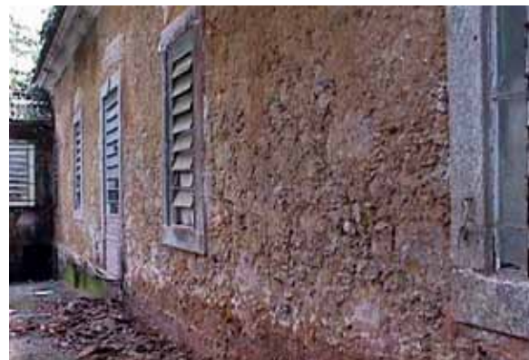
vista da fachada dos fundos mostrando as esquadrias novas que substituíram os basculantes
