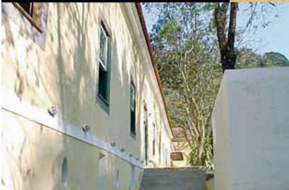
vista da fachada dos fundos mostrando as esquadrias novas que substituíram os basculantes
