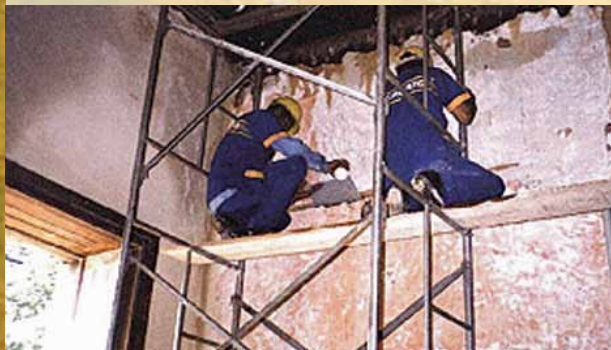
recuperação da parede de pau a pique
