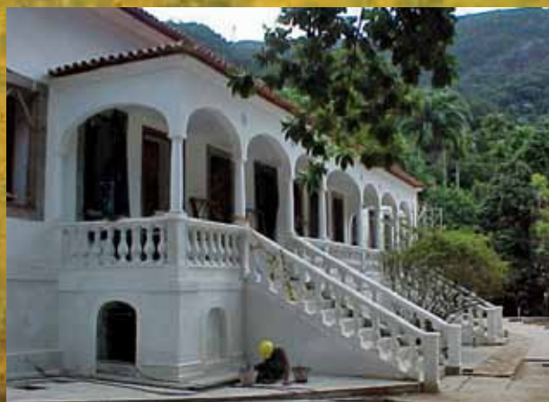
vista das fachadas com revestimento externo, após a aplicação da argamassa de cal, areia e dolomita
