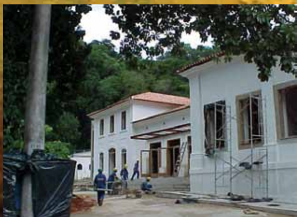
vista das fachadas com revestimento externo, após a aplicação da argamassa de cal, areia e dolomita
