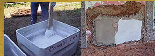
preparo e aplicação da argamassa de cal
