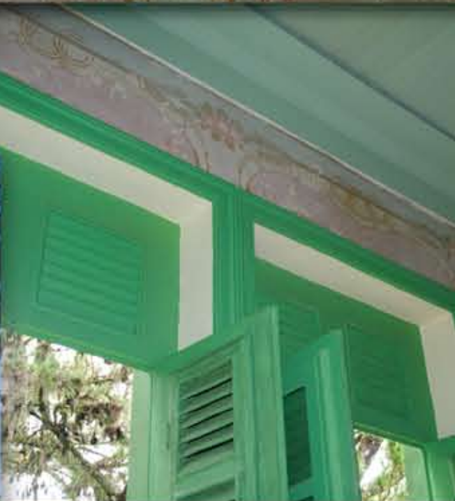
Detalhe da pintura interna, conservada durante as reformas
