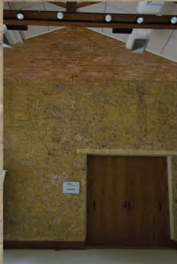
Entrada do auditório
