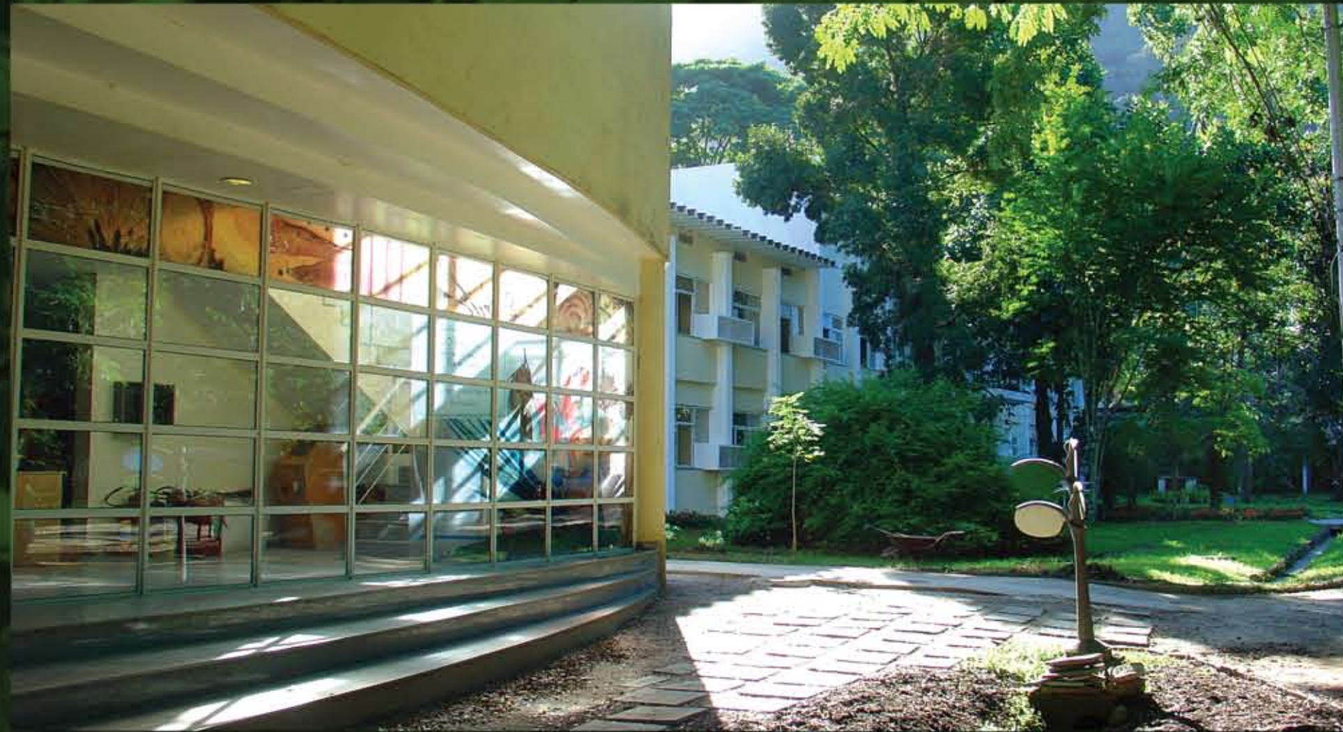
O prédio do Herbário em primeiro plano e ao fundo o recém reformado prédio onde trabalha a equipe de pesquisa
