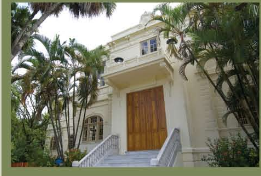
Fachada do Museu do Meio Ambiente após a reforma
