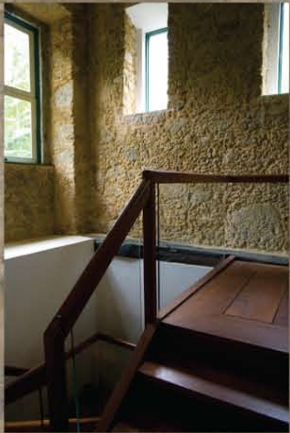
Escada de acesso para a cafeteria
