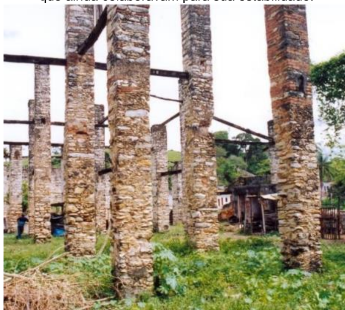
Figura 49 – Pilares de pedra do interior do Trapiche Santo Antônio com as peças de madeira apodrecidas que ainda colaboravam para sua estabilidade.
