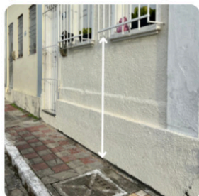
Figura 64: Gradil de janela que compromete a altura livre na calçada
