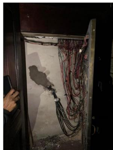
Foto 32: Quadro de luz com instalações elétricas inadequadas e fora de norma, nos fundos da Igreja da Ordem Terceira de Nossa Senhora do Carmo
