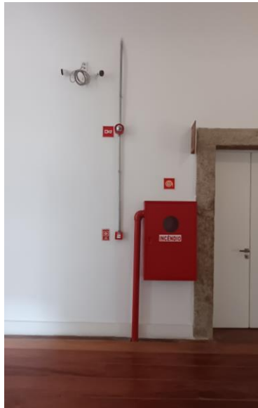
Foto 35 - Câmera de monitoramento, alarme de incêndio e hidrante na circulação do segundo pavimento
