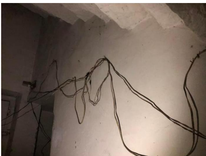
Foto 31 - Gambiarras, instalações elétricas inadequadas e fora de norma nos fundos da Igreja da Ordem Terceira de Nossa Senhora do Carmo
