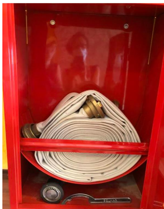
Foto 20 - Caixa de hidrante devidamente equipada com mangueira, esguicho e chave storz, situada no salão principal (térreo) da edificação
