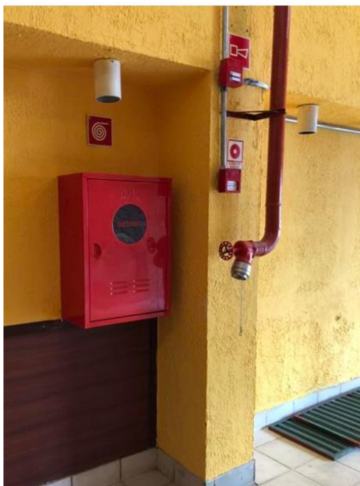
Foto 19 - Caixa e tubulação de hidrante e acionador manual de alarme de incêndio, situados no salão principal (térreo) da edificação
