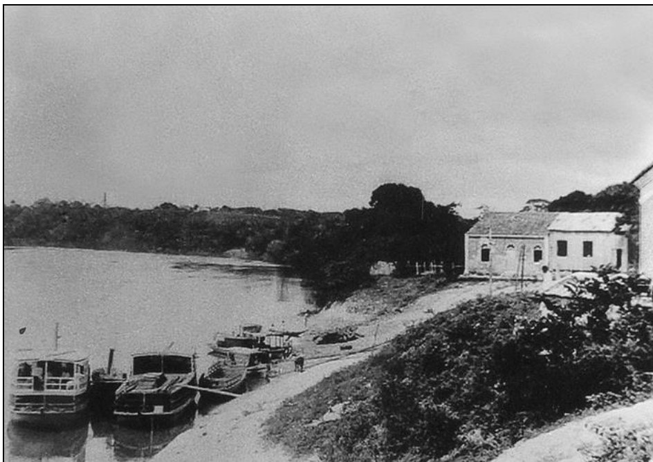
Figura 5 - Ângulo superior do Porto de Cimento, década de 40. Fonte desconhecida. Acervo do Iphan/RR.
