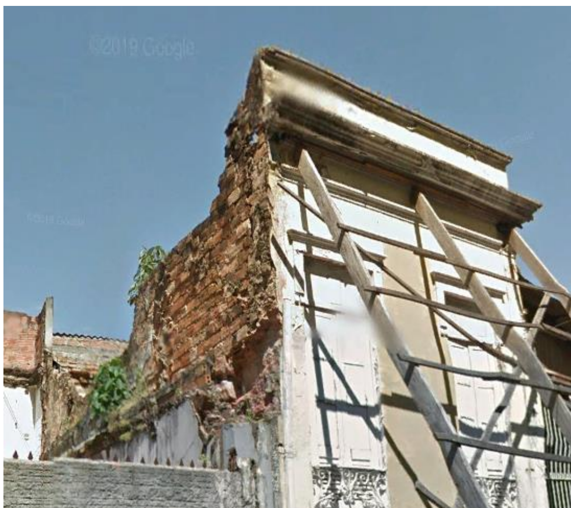
Figura 39: Sistema estrutural da casa em ruína de tijolos. Foto capturada em 2012
