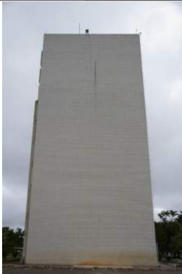
Fachada Sul do Bloco A. Imagem: Alba Bispo, mar/2020. Brasilia_AB_mar20_ESPM_BlocoA (24)
