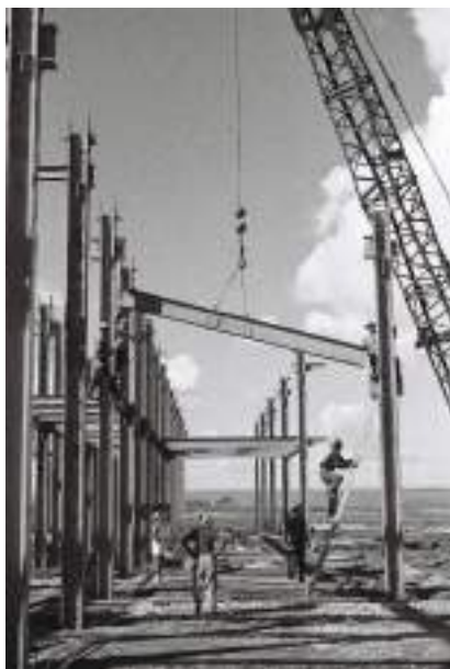
Figura 01: Montagem das estruturas de aço dos edifícios ministeriais, dirigido pela empresa norte-americana Raymond Concret Pile Company of the Americas. Autoria: não identificada. Data: 1959. Fonte: Arquivo Público do Distrito Federal – ArPDF. NOV-D-4-4-B-5 (730)
