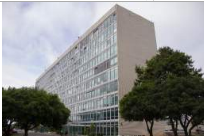
Fachada Leste do Bloco A. Imagem: Alba Bispo, mar/2020. [Brasilia_AB_mar20_ESPM_BlocoA (26)]
