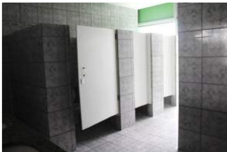
Figura 491. Banheiro social masculino da ala sul.
