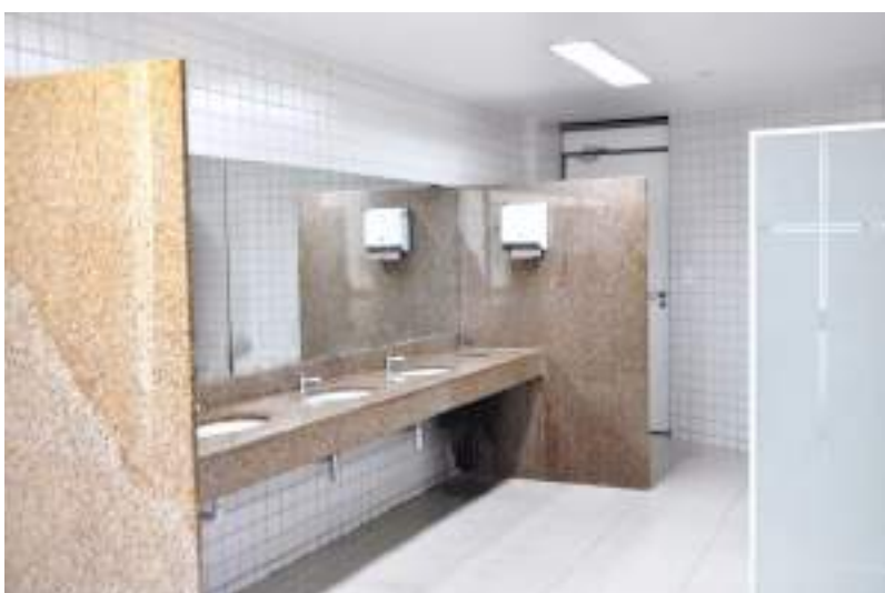
Figura 706. Vista geral do banheiro masculino para funcionário, no Anexo A.
