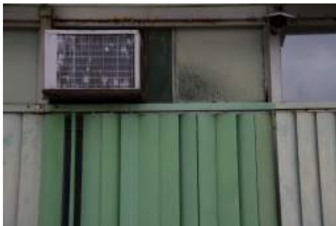
Figura 77. Substituição pontual de um trecho dos brises no térreo da Fachada Oeste do Edifício Sede; notar diversidade cromática de películas. Imagem: Alba Bispo, mar/2020.
