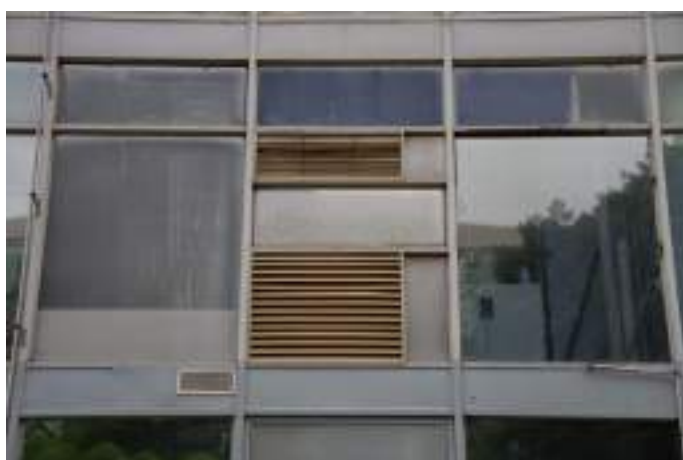
Figura 143. Adição de veneziana em substituição ao vidro na Fachada Leste do Edifício Sede. Imagem: Alba Bispo, mar/2020.
