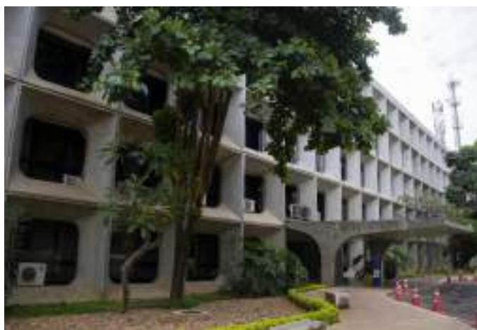
Figura 186. Adição de unidades aparentes de ar-condicionado na Fachada Leste do Edifício Anexo o. Imagem: Alba Bispo, mar/2020.
