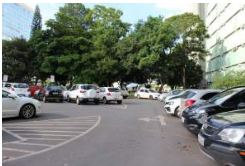
Figura 557. Área de estacionamento junto à fachada oeste do bloco F.
