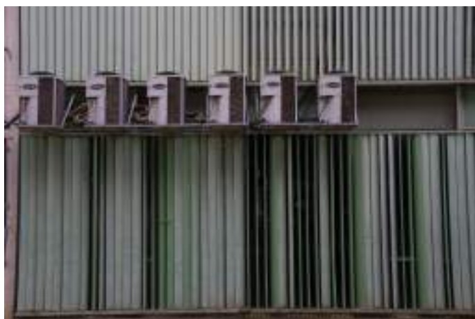
Figura 126. Concentração de unidades de ar-condicionado aparentes na Fachada Oeste, na área do Auditório, no térreo do Edifício Sede. Imagem: Alba Bispo, mar/2020.
