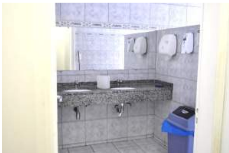
Figura 479. Banheiro feminino na ala norte.
