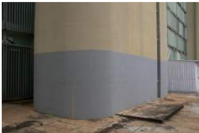
Figura 80. Pintura divergente do projeto original no volume de escadas de emergência, com duas tonalidades. Imagem: Alba Bispo, mar/2020.
