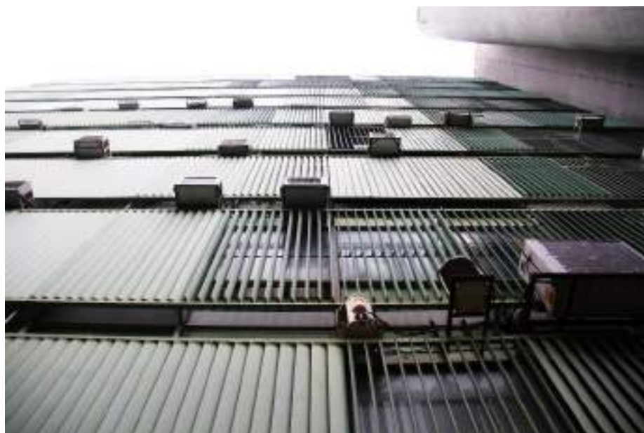
Figura 202. Obra de substituição de suportes para ar-condicionado que estavam enferrujados por novos suportes no Edifício Sede. Imagem: Alba Bispo, mar/2020.
