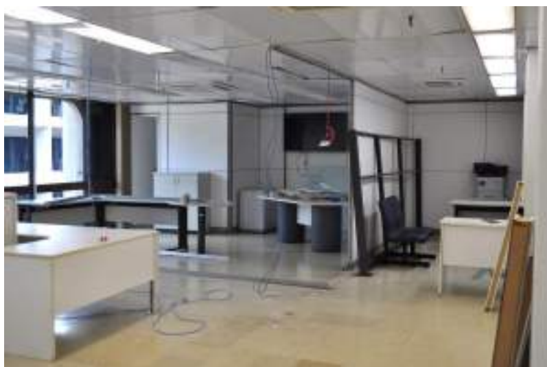
Figura 710. Vista geral de sala na ala sul do anexo A.
