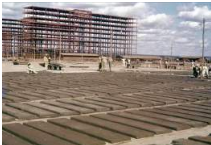
Figura 04: Produção de blocos de concreto usados para a construção dos edifícios ministeriais. Autoria: não identificada. Data: 1959. Fonte: Arquivo Público do Distrito 'Federal – ArPDF. NOV-D-4-4-B-5' (405)
