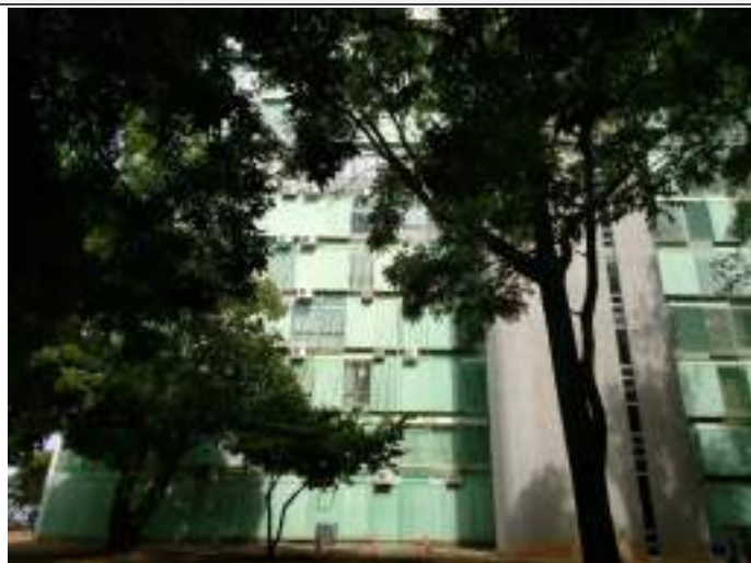
Presença de árvores de grande porte muito próximas à Fachada Oeste. Imagem: Alba Bispo, out/2019. [Brasília_AB_mar20_ESPM_BlocoE (24)]
