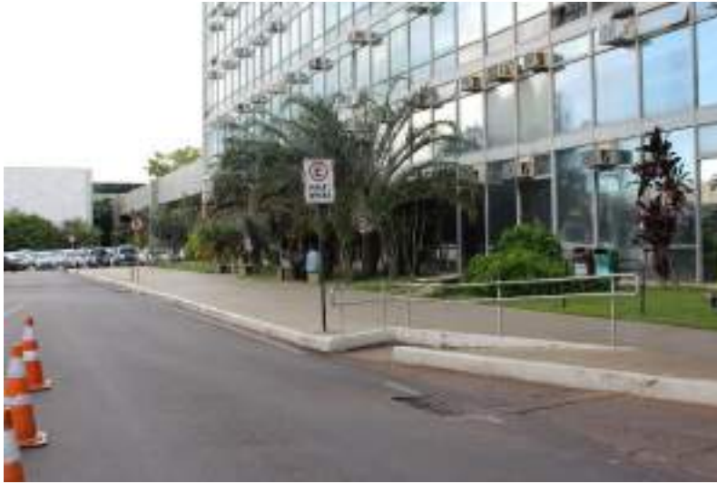
Figura 567. Detalhe do passeio e canteiro ajardinado junto à fachada leste, em sua porção próxima à fachada sul.
