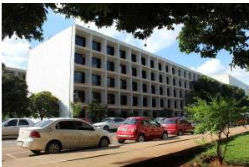
Figura 595. Fachadas leste e sul do anexo A, do bloco F.
