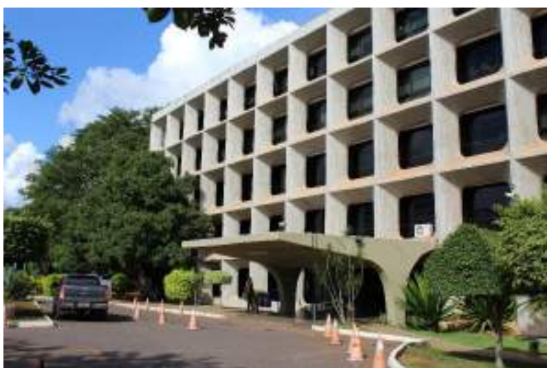
Figura 603. Detalhe da marquise sobre o acesso do anexo B.
