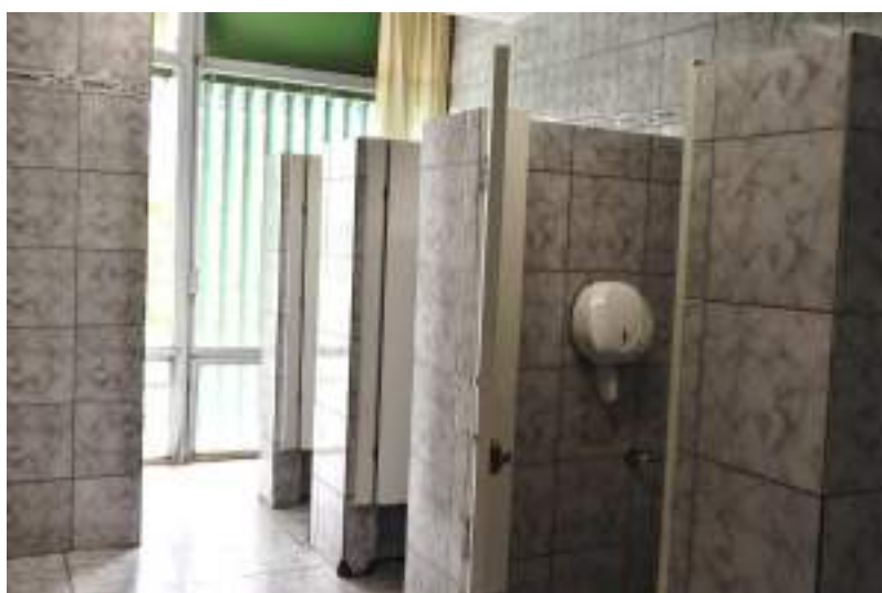
Figura 471. Banheiro feminino na ala norte.
