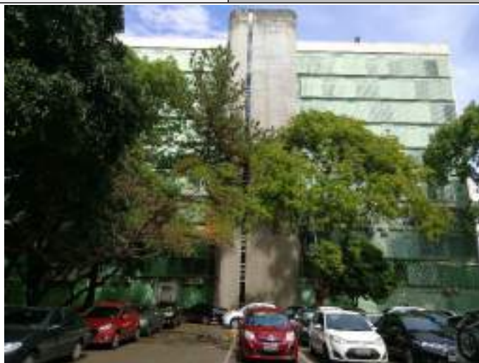
Presença de árvores de grande porte muito próximas à Fachada Oeste. Imagem: Alba Bispo, out/2019. [Brasília_AB_mar20_ESPM_BlocoE (25)]
