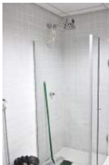
Figura 700. Banheiro privativo da ala norte do anexo A (nº 47 do croqui).
