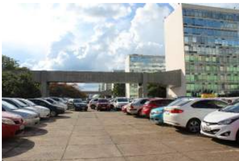
Figura 556. Área de estacionamento junto à fachada sul do bloco F.
