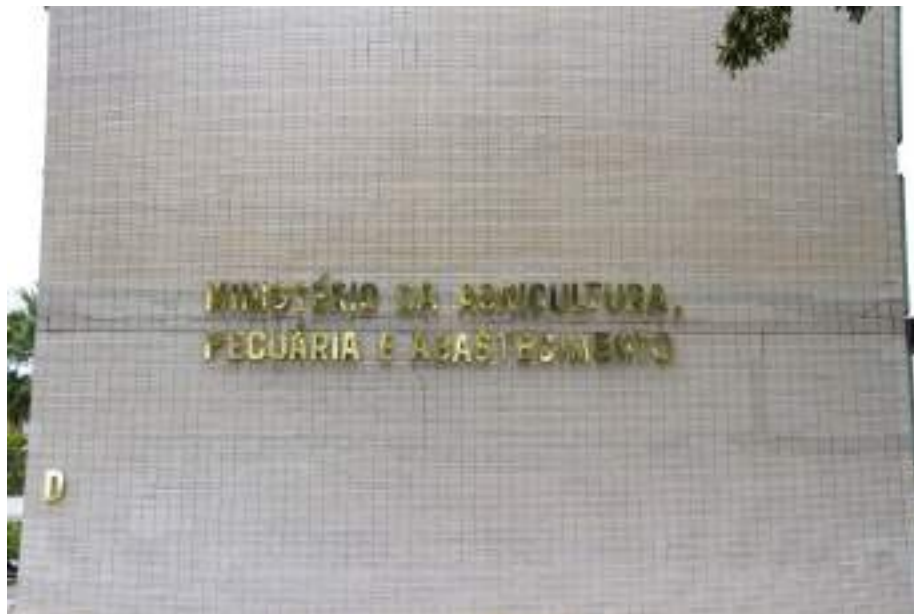
Figura 140. Deformações estruturais, trincas e rachaduras na laje da sobreloja, com destacamento do revestimento cerâmico na Fachada Norte do Edifício Sede. Imagem: Alba Bispo, mar/2020.
