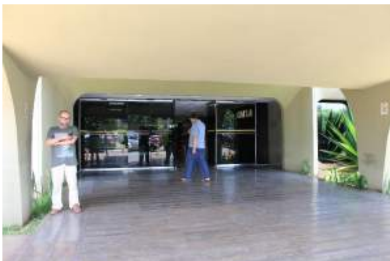
Figura 759. Acesso externo ao anexo B, dado pela fachada oeste do prédio anexo.
