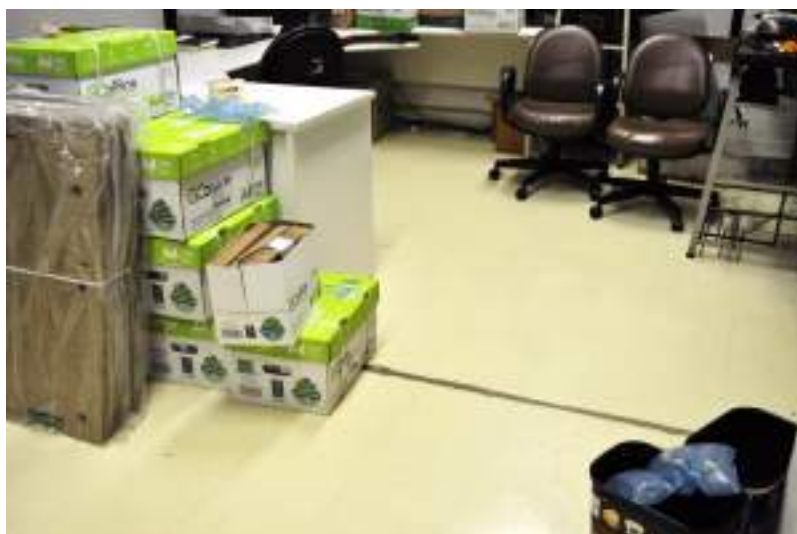
Figura 681. Detalhe do piso vinílico bege de uma das salas da ala sul, voltada para a fachada oeste (nº 33 do croqui).
