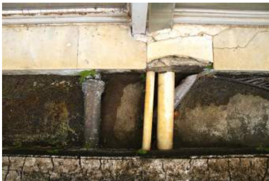
Figura 145. Intervenção com adição de vala junto à Fachada Leste do Edifício Sede; notar substituição de tubulação hidráulica galvanizada para PVC; umidade localizada. Imagem: Alba Bispo, mar/2020.
