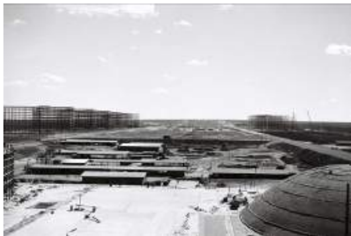
Figura 11: Fotografia da Esplanada dos Ministérios no período em que apenas as estruturas de aço encontravam-se erguidas, produzida a partir do Congresso Nacional. Autoria: não identificada. Data: 1959. Fonte: Arquivo Público do Distrito 'Federal – ArPDF. NOV-D-4-4-B-2' (320)
