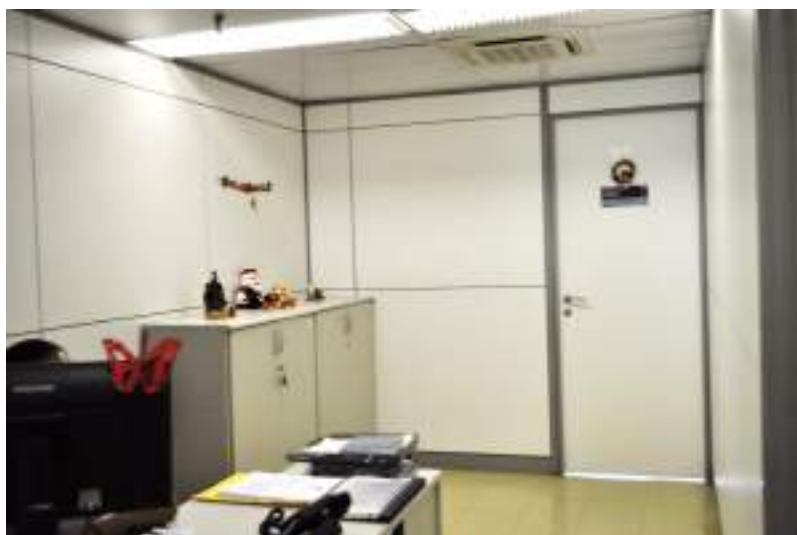
Figura 699. Utilização de divisórias em fórmica (laminado melamínico) para configuração das salas.
