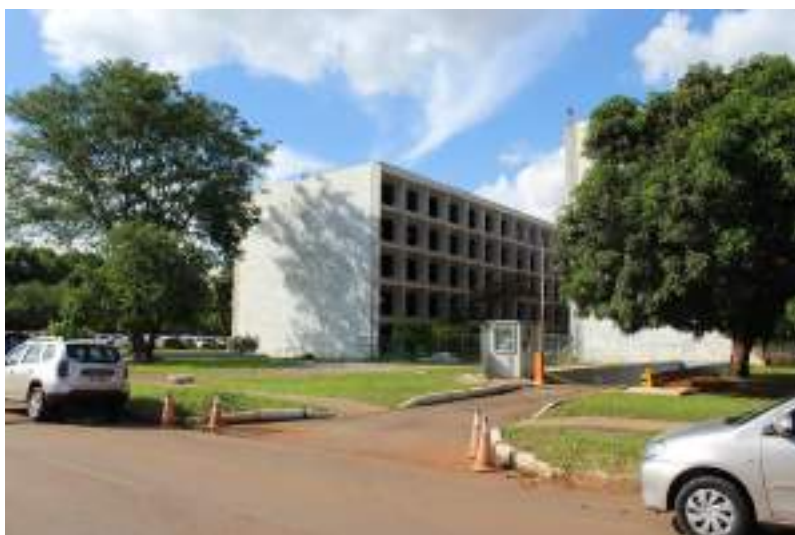
Figura 610. Vista das entradas para garagem e canteiros ajardinados próximo à fachada sul do prédio anexo.
