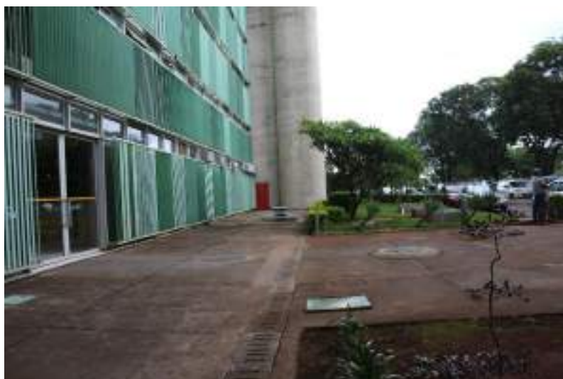
Figura 355. Detalhe do passeio junto à fachada oeste.
