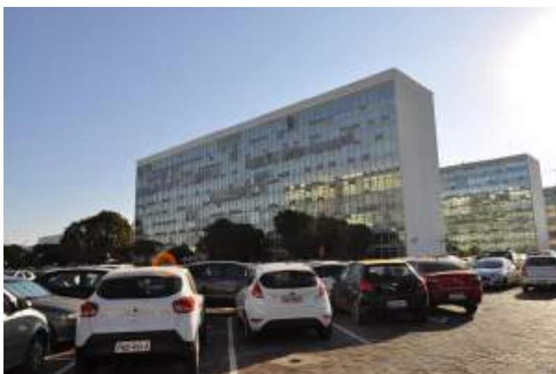
Figura 61. Vistas de fachadas leste de blocos ministeriais, na ala norte. Imagem: Camila Morais, set/2019.
