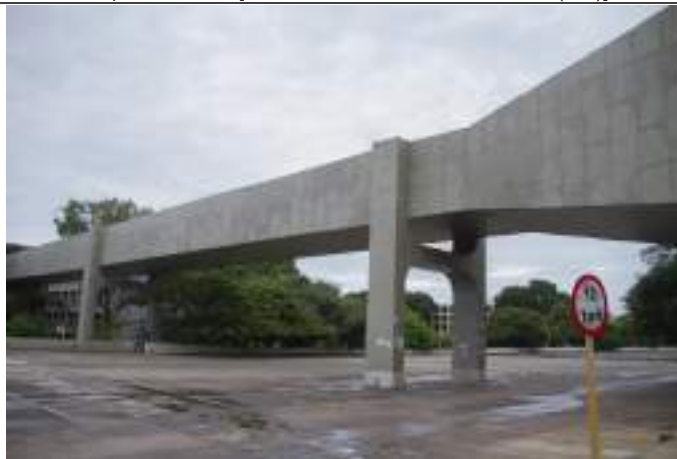
Passarela de conexão entre Edifício Sede e Edifício Anexo. Imagem: Alba Bispo, mar/2020. [Brasilia_AB_mar20_ESPM_BlocoF (115)]
