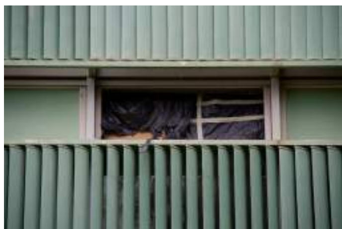
Figura 34. Substituição de esquadria em função de adição de unidades de ar-condicionado aparentes na Fachada Oeste do Edifício Sede. Imagem: Alba Bispo, mar/2020.
