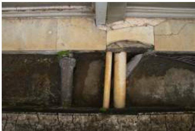
Figura 71. Intervenção com adição de vala junto à Fachada Leste do Edifício Sede; notar substituição de tubulação hidráulica galvanizada para PVC; umidade localizada. Imagem: Alba Bispo, mar/2020.
