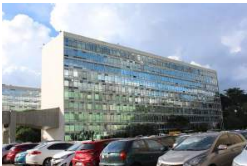
Figura 572. Fachada leste do bloco F.
