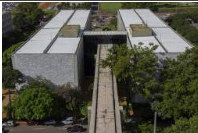
Cobertura do Edifício Anexo com volumetria em formato "H". Imagem: Alba Bispo, mar/2020. [Brasilia_AB_mar20_ESPM_BlocoF (114)]
