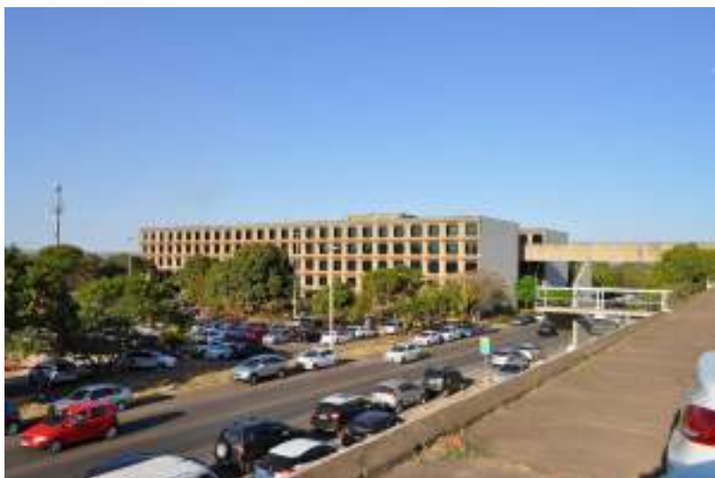
Figura 68. Vista de um dos prédios anexos na ala norte, com a via N2 logo abaixo. Imagem: Camila Moraes, set/2019.
