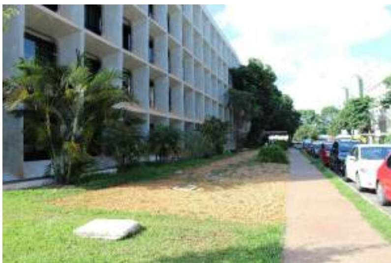
Figura 609. Vista do passeio e canteiros ajardinados próximo à fachada leste do prédio anexo.
