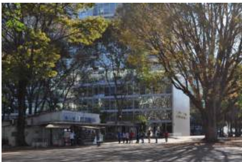
Figura 39. Existência de edificações de prestação de serviços de apoio, como lotérica, lanchonete etc entre os prédios. Nessa imagem entre os blocos ministeriais B e C da ala sul. Imagem: Camila Morais, set/2019.
