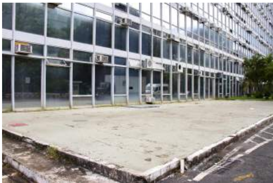
Figura 143. Pavimentação da área ajardinada junto à Fachada Leste do Edifício Sede, no trecho correspondente a uma agência bancária que funcionava no térreo. Imagem: Alba Bispo, mar/2020.
