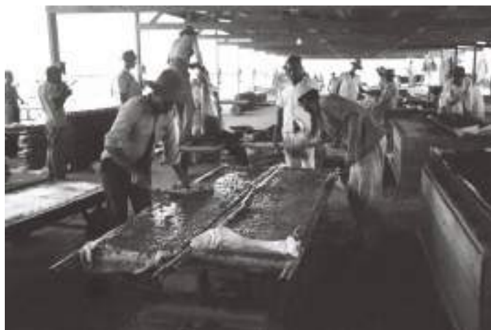
Figura 03: Produção de blocos de concreto usados para a construção dos edifícios ministeriais. Autoria: não identificada. Data: 1959. Fonte: Arquivo Público do Distrito 'Federal – ArPDF. NOV-D-4-4-B-5 (715)
