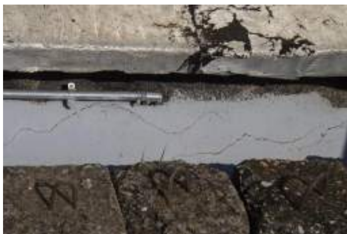
Figura 151. Reparos na área da extremidade da platibanda entre as Fachadas Norte e Oeste do Edifício Sede onde há incidências de fissuras e trincas. Imagem: Alba Bispo, mar/2020.
