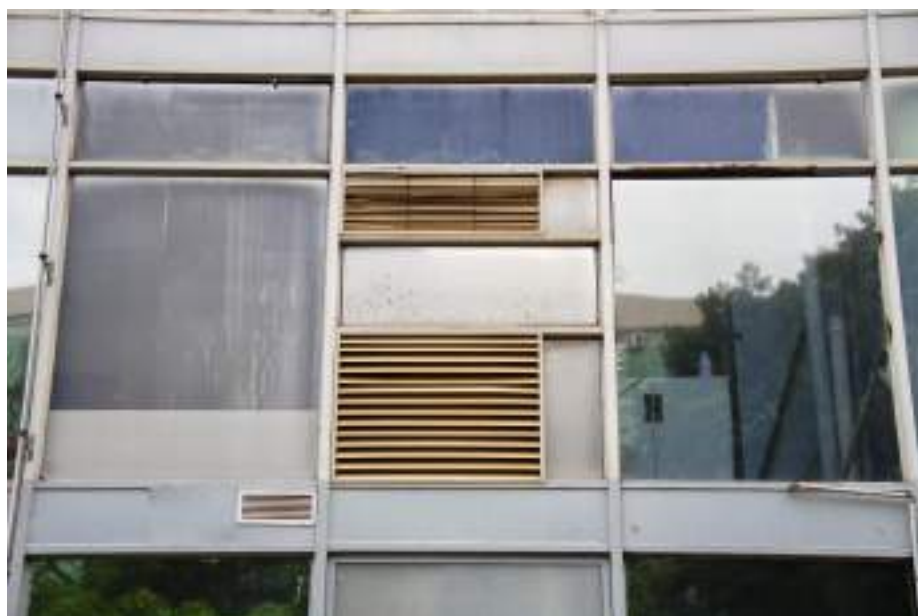
Figura 217. Adição de veneziana em substituição ao vidro na Fachada Leste do Edifício Sede. Imagem: Alba Bispo, mar/2020.
