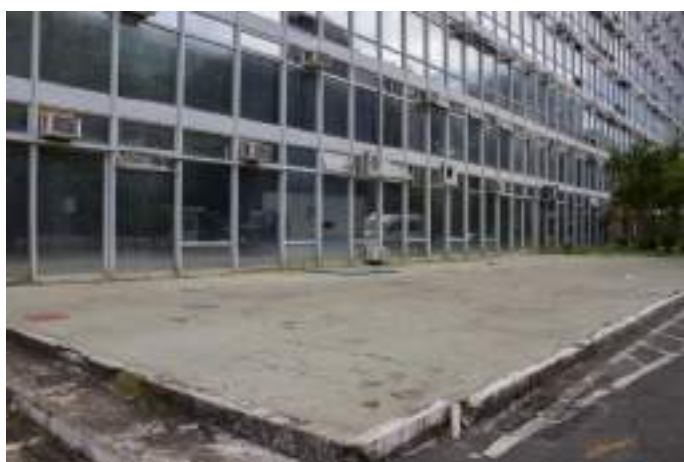
Figura 69. Pavimentação da área ajardinada junto à Fachada Leste do Edifício Sede, no trecho correspondente a uma agência bancária que funcionava no térreo. Imagem: Alba Bispo, mar/2020.
