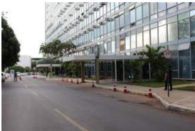
Figura 564. Passeio e canteiros ajardinados junto à fachada leste do bloco F.
