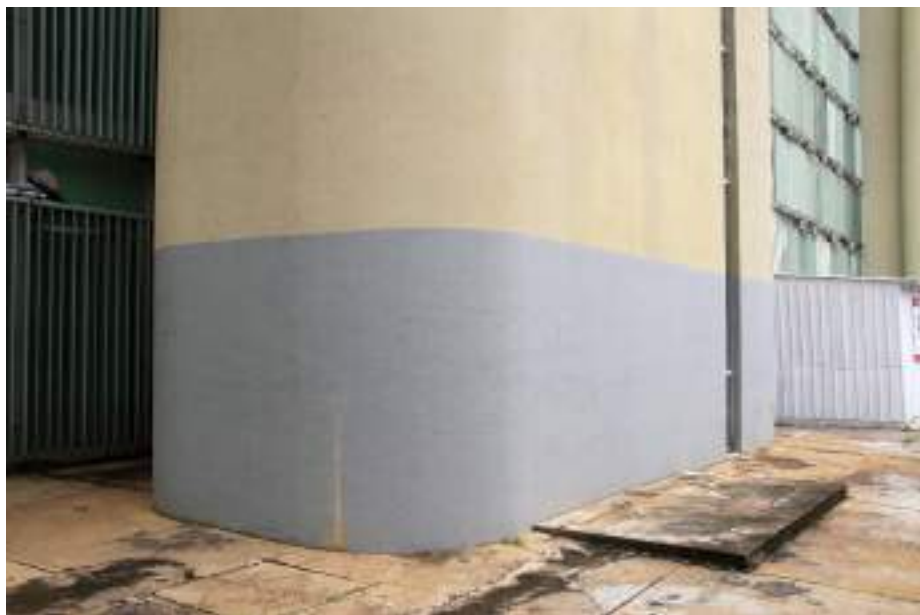
Figura 154. Pintura divergente do projeto original no volume de escadas de emergência, com duas tonalidades. Imagem: Alba Bispo, mar/2020.
