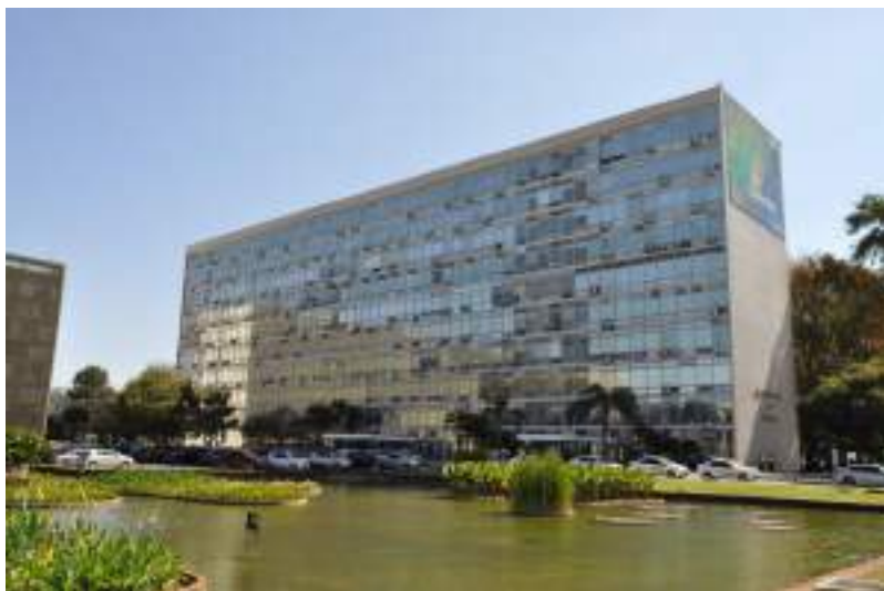
Figura 35. Vista da fachada leste do bloco ministerial G, a partir do Itamaraty, na ala sul. Imagem: Camila Morais, set/2019.
