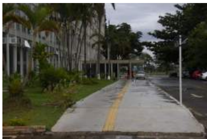
Figura 115. Pavimentação da área ajardinada junto à Fachada Leste do Edifício Sede. Imagem: Alba Bispo, mar/2020.
