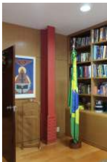
Figura 526. Detalhe dos perfis estruturais na Sala do Secretário de Cultura ao lado de serigrafias de Rubem Valentim. A reforma realizada entre 2004 e 2006 recuperou também as marcações de cada pilar, identificados pela Novacap.
