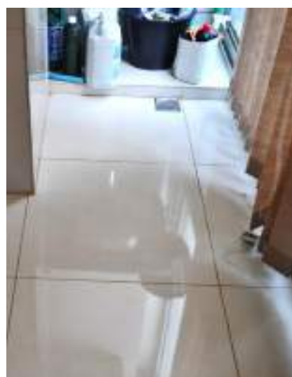
Figura 654. Vista geral da copa de apoio ao auditório (nº 33 no croqui).
