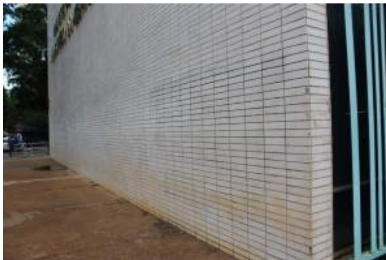
Figura 365. Detalhe do revestimento cerâmico da fachada norte do bloco B.
