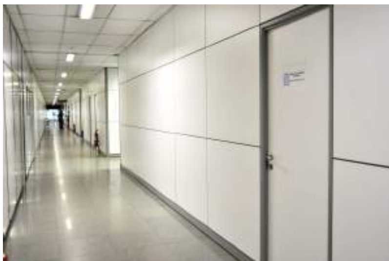
Figura 673. Vista geral do corredor de circulação na ala sul.
