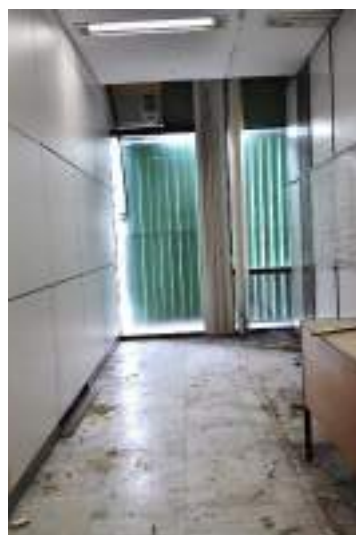
Figura 638. Vista geral da sala administrativa voltada para a fachada oeste (nº 17 no croqui).
