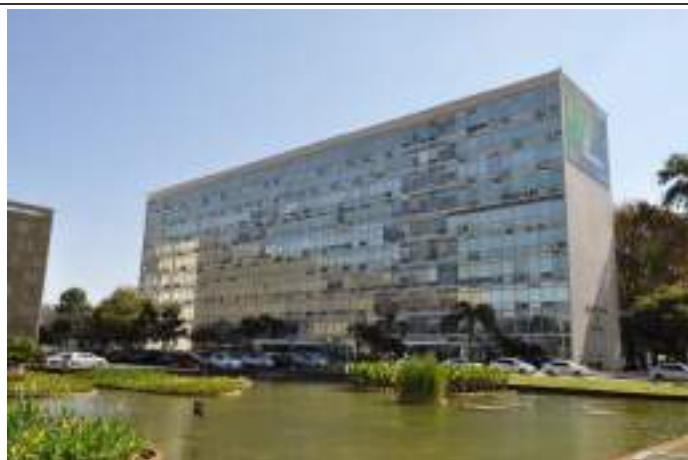
Vista da fachada leste do bloco ministerial G (Setor A), a partir do Itamaraty, na ala sul. Imagem: Camila Morais, set/2019.
