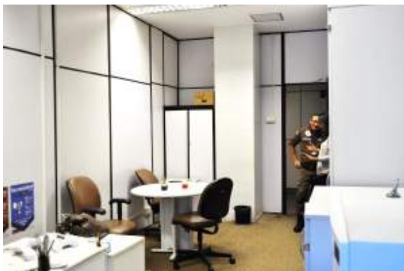
Figura 682. Detalhe do piso vinílico bege de uma das salas da ala sul, voltada para a fachada oeste (nº 33 do croqui).
