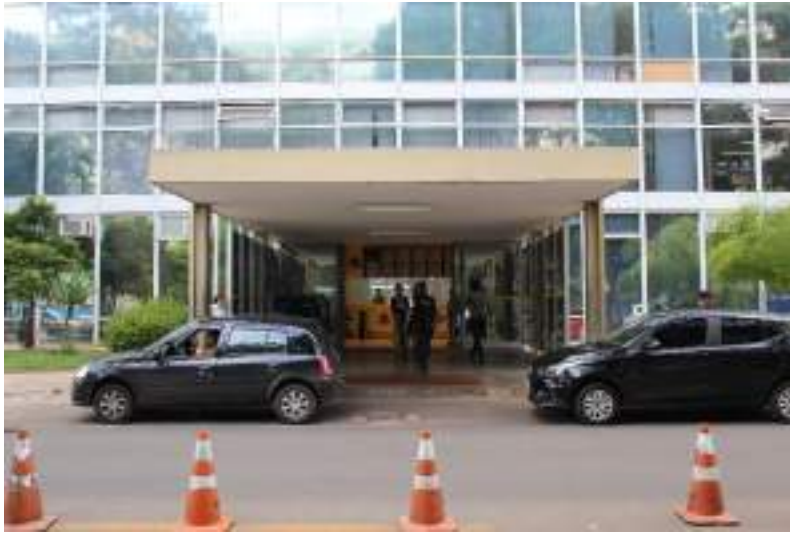
Figura 370. Vista geral da marquise sobre o acesso de visitantes e funcionários.
