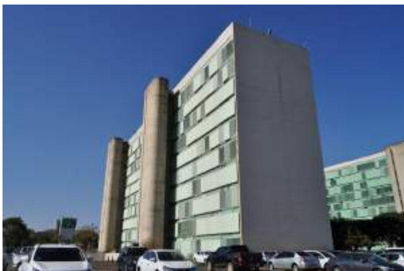
Figura 33. Vista da fachada oeste do bloco ministerial A, a partir do Itamaraty, na ala sul. Imagem: Camila Morais, set/2019.
