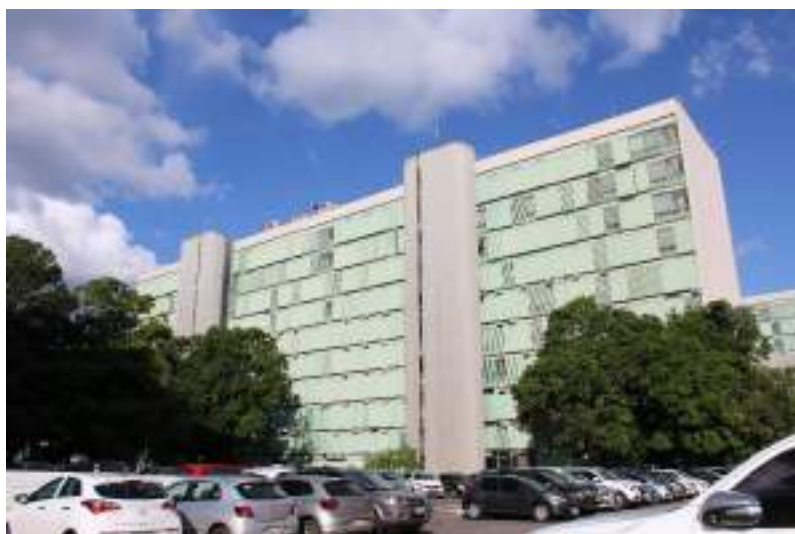
Figura 577. Fachada oeste do bloco F.
