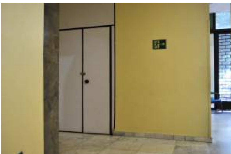
Figura 623. Vista externa do ambiente utilizado como área de descanso por funcionários (nº 06 no croqui).
