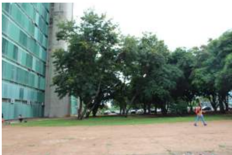
Figura 357. Vista da pequena praça junto à fachada oeste.
