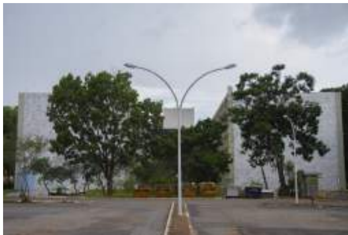
Vista da Fachada Sul dos Anexos do Bloco D, revestidas em mármore branco. Imagem: Alba Bispo, mar/2020. [Brasilia_AB_mar20_ESPM_BlocoD (39)]
