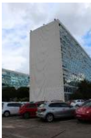
Figura 363. Fachada norte e fachada sul, respectivamente, do bloco B.
