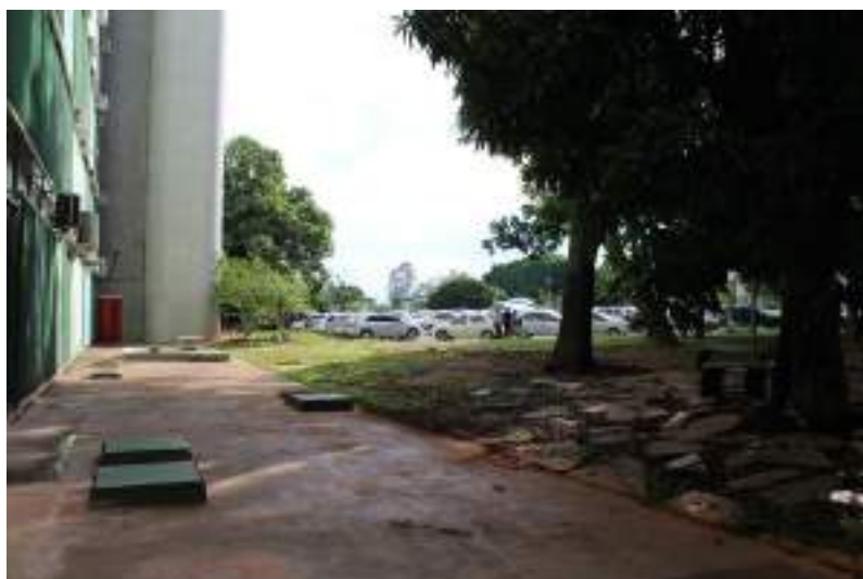
Figura 559. Detalhe do passeio junto à fachada oeste.
