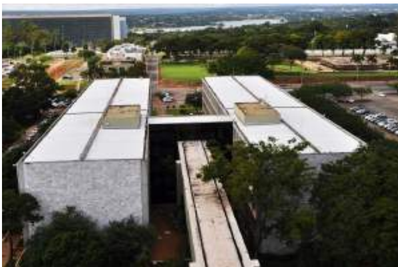
Figura 604. Vista geral da cobertura do prédio anexo do bloco F a partir do edifício sede.
