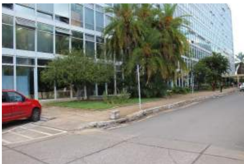
Figura 362. Detalhe do passeio e canteiro ajardinado junto à fachada leste, em sua porção próxima à fachada sul.
