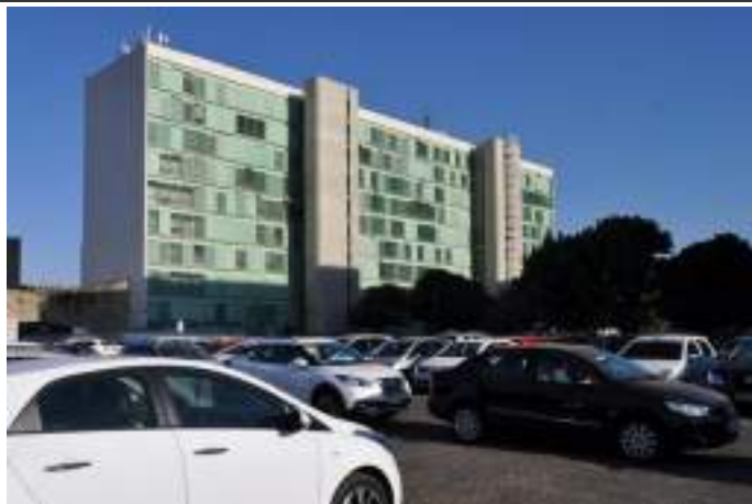
Vistas de fachada oeste de bloco ministerial, na ala norte. Prédio – Setor A e estacionamento – Setor B. Imagem: Camila Morais, set/2019.
