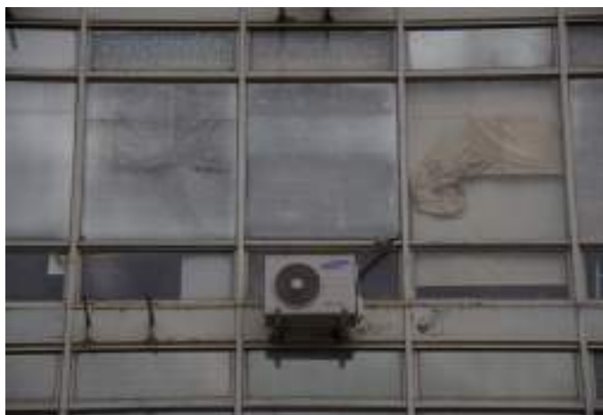
Figura 180. Adição de papelões, diversidade cromática e películas desgastadas na Fachada Leste do Edifício Sede. Imagem: Alba Bispo, mar/2020.
