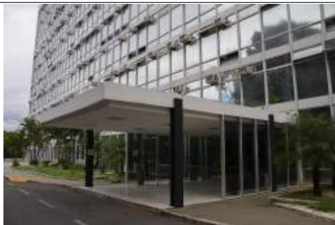
Marquise de entrada do Edifício Sede. Imagem: Alba Bispo, mar/2020. [Brasilia_AB_mar20_ESPM_BlocoD (38)]
