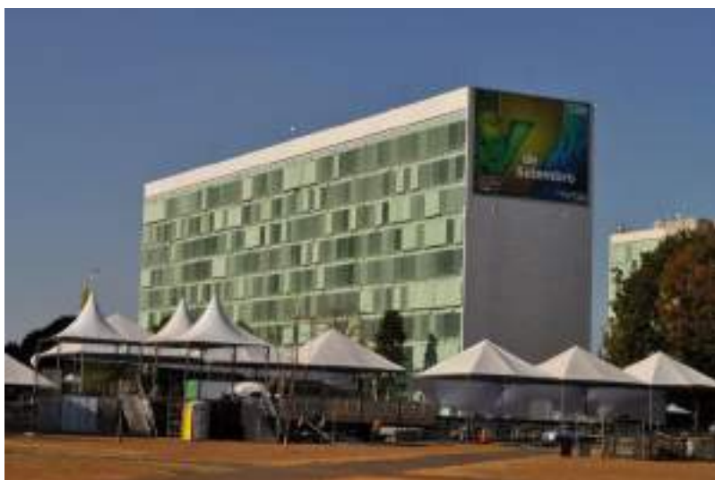
Figura 63. Vista da fachada oeste do bloco U sem volume externo de escada, na ala norte. Imagem: Camila Morais, set/2019.
