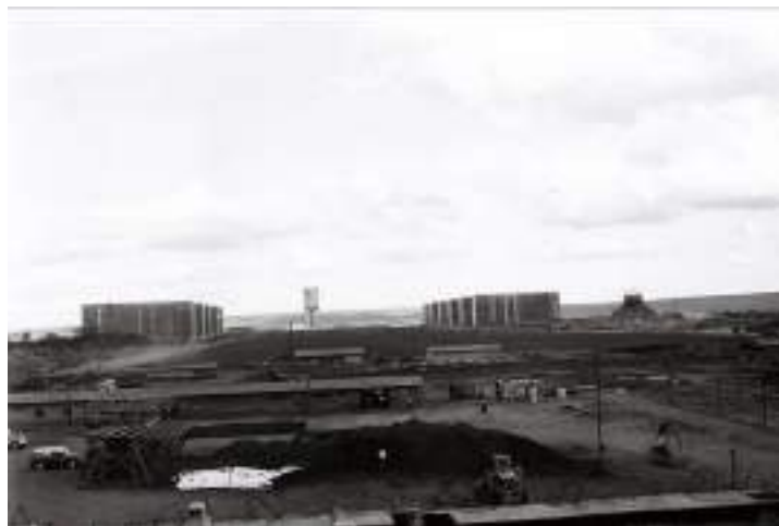
Figura 08: Fotografia produzida a partir do cruzamento dos Eixos Monumental e Rodoviário, no período de construção dos prédios dos Ministérios. Autoria: não identificada. Data: 1959. Fonte: Arquivo Público do Distrito Federal – ArPDF. NOV-D-4-4-B-2 (251)
