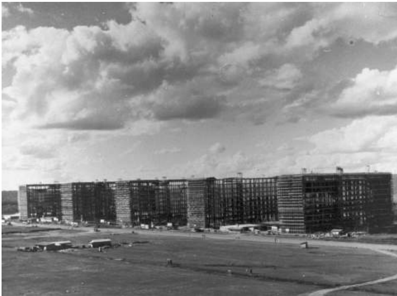
Figura 15. Estruturas de aço dos blocos ministeriais no lado norte. Autoria: s/a. Data: 1958. Fonte: Fundo Novacap ArPDF. (Brasília_SemAutoria_1958_BlocosMinisteriais.norte_.jpg)
