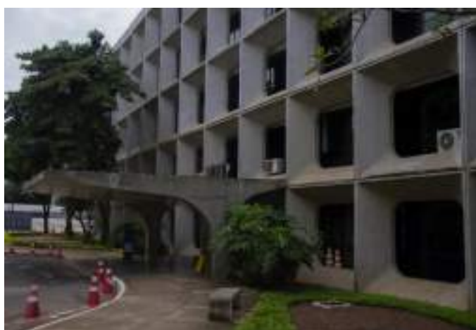
Figura 187. Adição de unidades aparentes de ar-condicionado na Fachada Oeste do Edifício Anexo o. Imagem: Alba Bispo, mar/2020.
