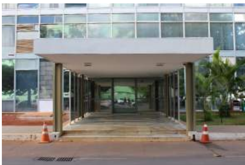
Figura 575. Vista geral da marquise sobre o acesso privativo.
