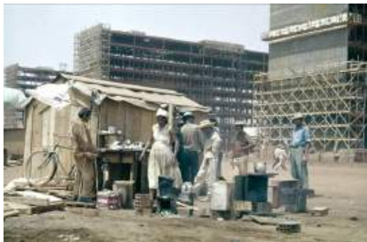
Figura 12: Base de apoio de trabalhadores, popularmente conhecidos como "candangos", durante a construção das edificações que abrigam os Ministérios. Ao fundo, três edifícios ministeriais em construção. Autoria: não identificada. Data: 1959. Fonte: Arquivo Público do Distrito 'Federal – ArPDF. NOV-D-4-4-B-5' (392)
