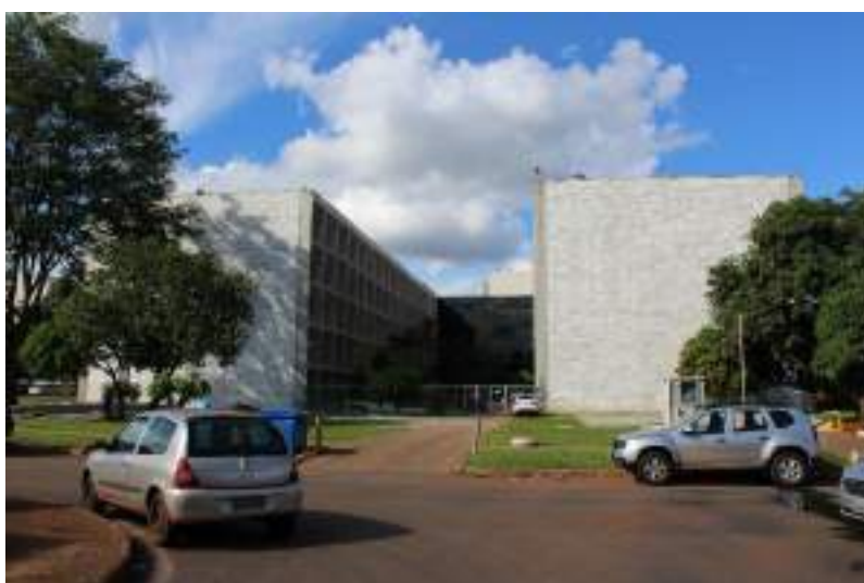
Figura 597. Fachadas sul dos anexos A (à direita) e B (à esquerda). Além da vista da fachada leste do anexo B e do volume em vidro, de conexão entre os anexos.
