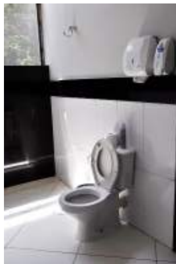
Figura 475. Detalhes de um banheiro privativo (nº 27 do croqui).
