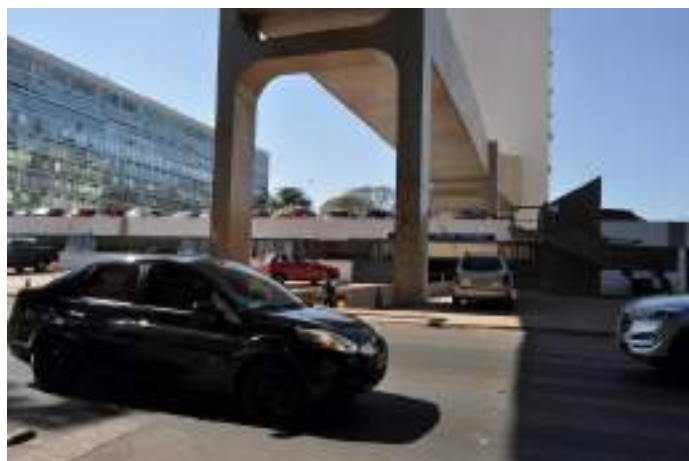
Figura 31: Passarela que realiza a ligação entre o Bloco G, que sedia o Ministério da Saúde e o Anexo Ministerial correspondente. Imagem: Camila Morais, set/2019
