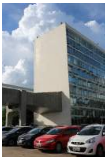
Figura 568. Fachada norte e fachada sul, respectivamente, do bloco F.
