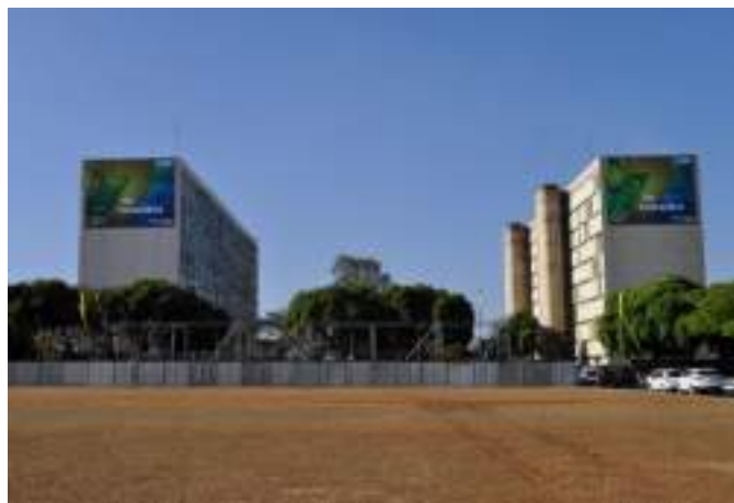
Blocos ministeriais P e Q (da esquerda para direita), na ala norte. Prédios – Setor A e área vegetada – Setor B. Imagem: Camila Morais, set/2019.
