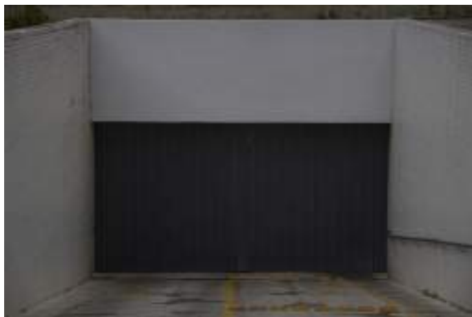
Figura 148. Demolição e construção de novo muro na entrada do estacionamento do Edifício Sede, sem o revestimento padrão em cerâmicas brancas. Imagem: Alba Bispo, mar/2020.
