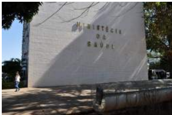
Figura 30: Fachada lateral do Ministério da Saúde, identificado originalmente como Bloco G. Imagem: Camila Morais, set/2019
