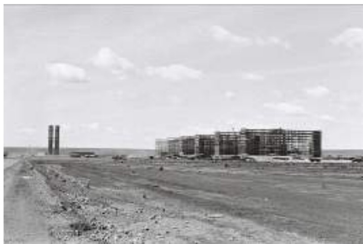
Figura 07: Visada geral da construção do lado Sul da Esplanada dos Ministérios, com as estruturas de aço dos prédios C, D, E, F, G. Autoria: não identificada. Data: 1959. Fonte: Arquivo Público do Distrito Federal – ArPDF. NOV-D-4-4-B-2 (254)
