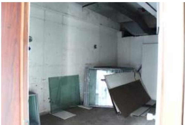
Figura 717. Vista geral do depósito próximo à copa.
