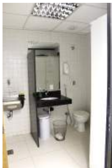
Figura 735. Banheiros do antigo Posto de Saúde na ala norte do anexo B.
