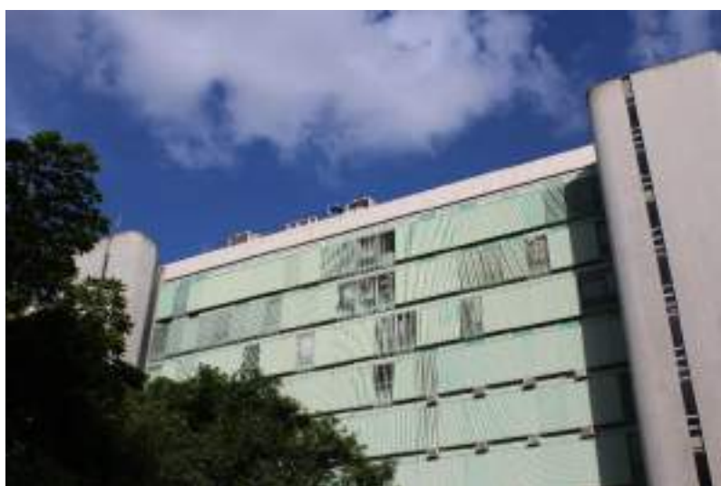
Figura 579. Detalhe dos brise-soleils na fachada externa do bloco F.
