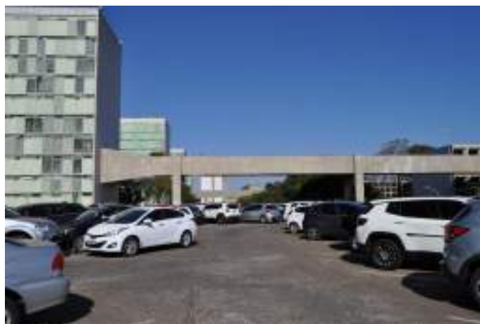
Figura 32: Passarela que realiza a ligação entre o Bloco G, que sedia o Ministério da Saúde e o Anexo Ministerial correspondente. Imagem: Camila Morais, set/2019
