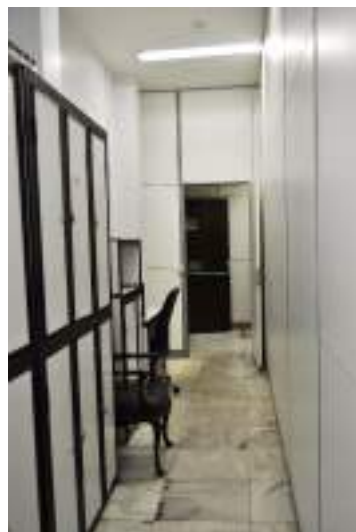
Figura 647. Vista geral da sala administrativa voltada para a fachada oeste (nº 26 no croqui).
