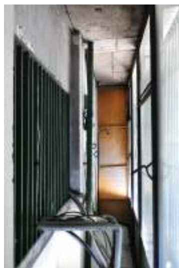
Figura 640. Vista geral de uma sala utilizada para depósito, voltada para a fachada oeste (nº 19 no croqui).
