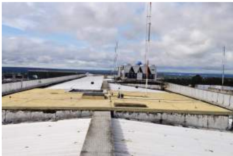
Figura 582. Vista geral da cobertura do edifício sede do bloco F.
