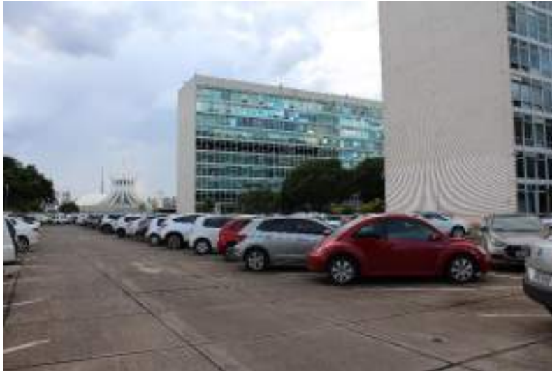
Figura 352. Área de estacionamento junto à fachada sul do bloco B.
