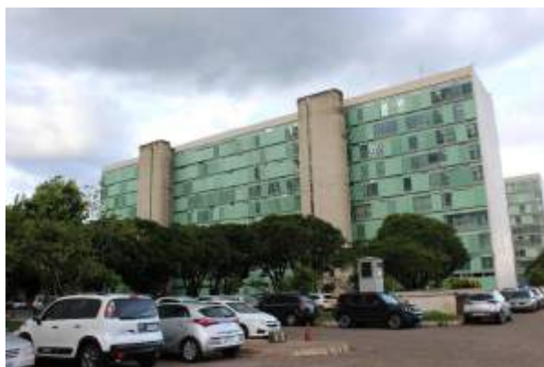
Figura 339. Vista da fachada oeste do Bloco B com presença de brises metálicos e volumes externos de escadas, inseridos posteriormente ao projeto original.
