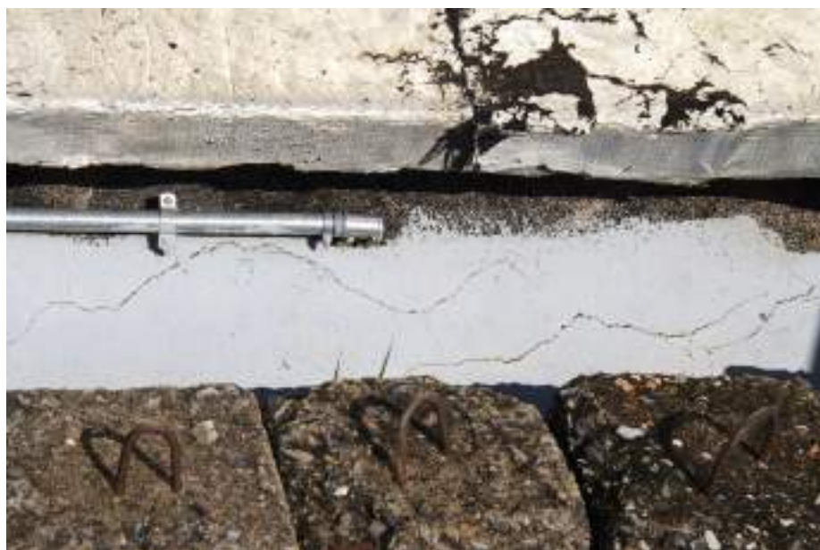
Figura 225. Reparos na área da extremidade da platibanda entre as Fachadas Norte e Oeste do Edifício Sede onde há incidências de fissuras e trincas. Imagem: Alba Bispo, mar/2020.
