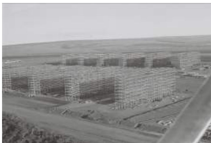
Figura 05: Vista aérea das estruturas de aço que estruturam os edifícios sede dos Ministérios, no período da construção das edificações. As estruturas foram construídas pela empresa norte-americana Raymond Concret Pile Company of the Americas. Autoria: não identificada. Data: 1959. Fonte: Arquivo Público do Distrito 'Federal – ArPDF. NOV-D-4-4-B-2 (257)
