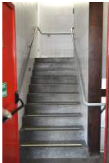
Figura 693. Escadaria de saída de incêndio.
