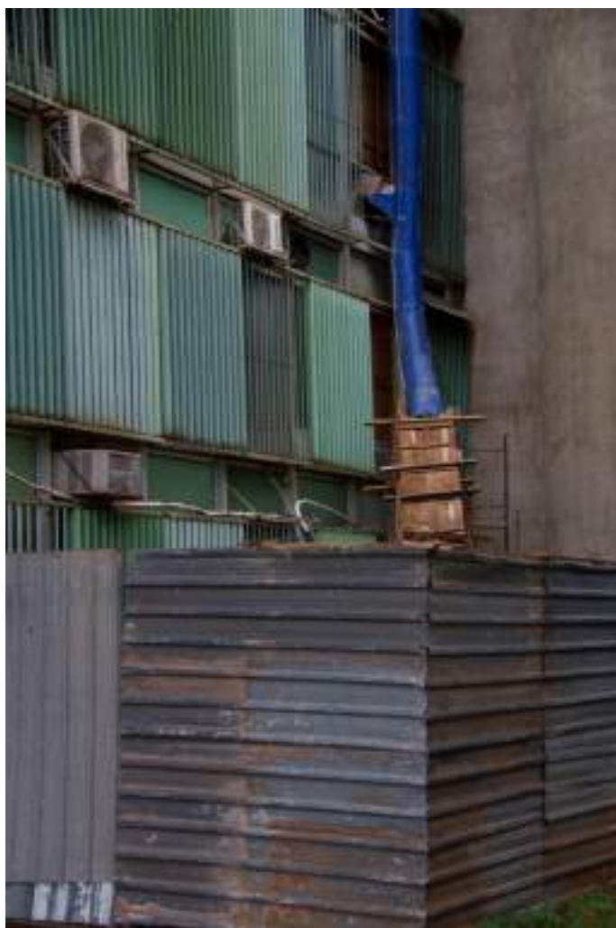
Figura 57. Tubo de descida de entulhos e barracão para execução de obra de demolição das lajes em estuque e reforma dos banheiros da ala norte e ala sul do Edifício Sede. Imagem: Alba Bispo, mar/2020.
