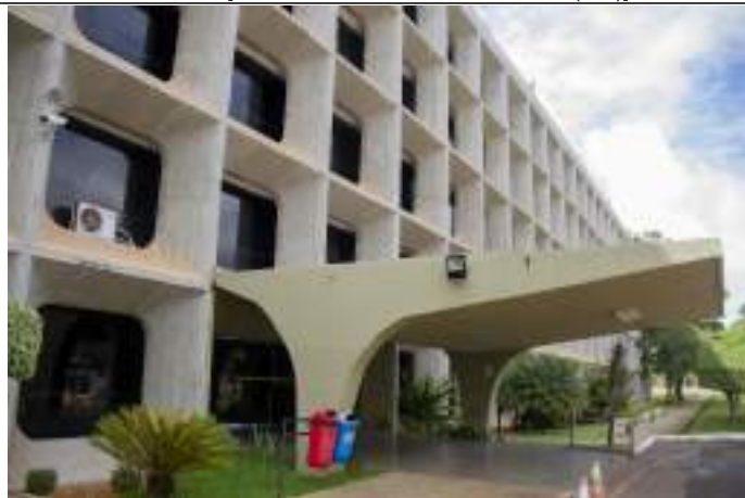
Marquise de entrada do Edifício Anexo. Imagem: Alba Bispo, mar/2020. [Brasilia_AB_mar20_ESPM_BlocoF (111)]
