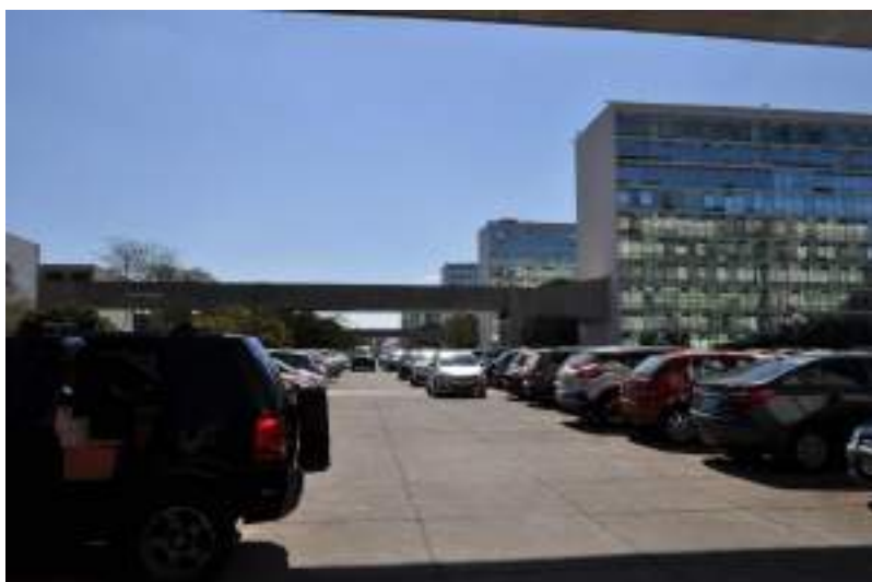
Figura 45. Vista da área de estacionamento na ala sul, na porção posterior dos blocos ministeriais. Imagem: Camila Morais, set/2019.
