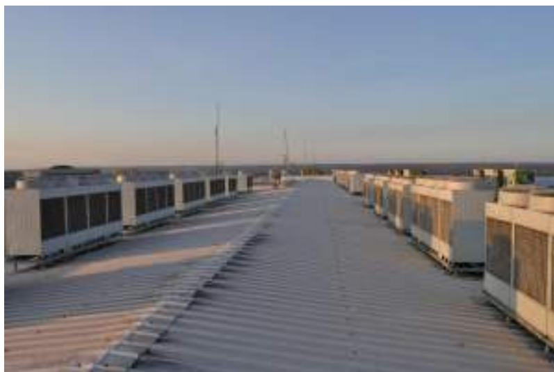
Figura 375. Vista geral da cobertura do bloco B.
