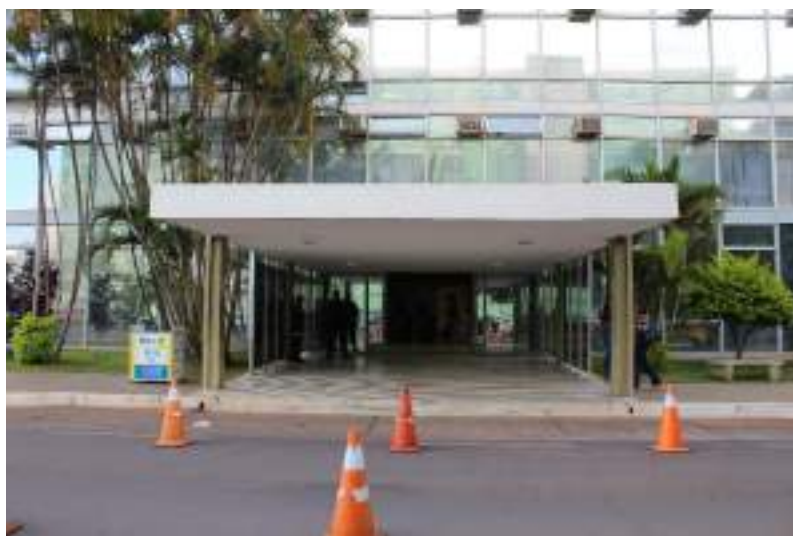
Figura 576. Vista geral da marquise sobre o acesso de visitantes e funcionários.
