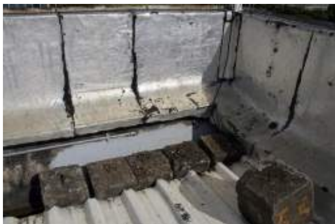
Figura 150. Reparos na área da extremidade da platibanda entre as Fachadas Norte e Oeste do Edifício Sede onde há incidências de fissuras e trincas. Imagem: Alba Bispo, mar/2020.
