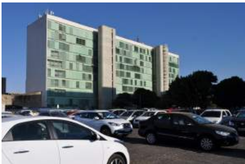
Figura 62. Vistas de fachada oeste de bloco ministerial, na ala norte. Imagem: Camila Morais, set/2019.
