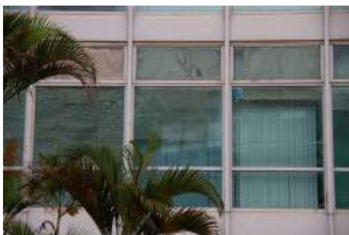
Figura 17. Adição de papelões e películas com diversidade cromática na Fachada Leste do Edifício Sede. Imagem: Alba Bispo, mar/2020.
