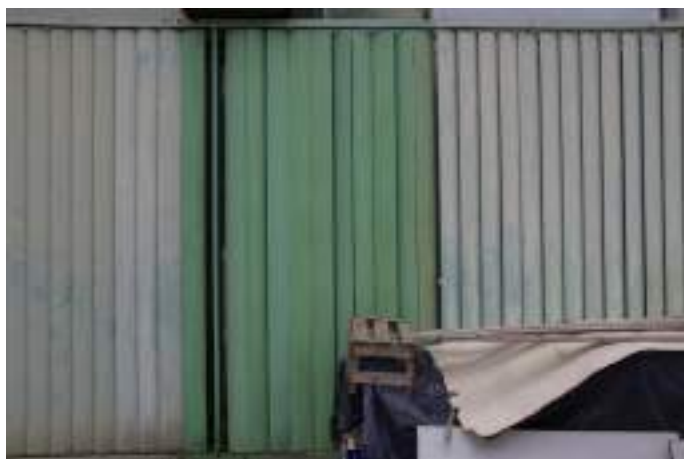
Figura 76. Substituição pontual de um trecho dos brises no térreo da Fachada Oeste do Edifício Sede. Imagem: Alba Bispo, mar/2020.
