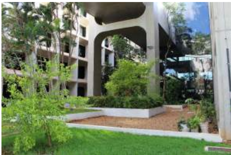
Figura 593. Canteiro ajardinado na porção frontal do prédio anexo.
