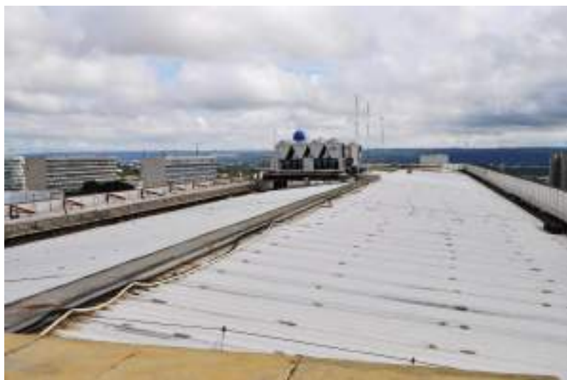
Figura 581. Vista geral da cobertura do edifício sede do bloco F.
