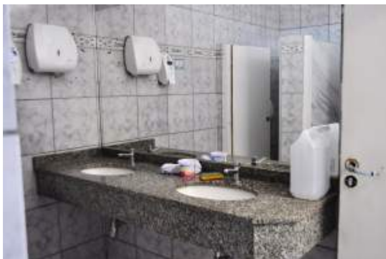
Figura 427. Banheiro masculino na ala sul do primeiro pavimento (nº 06 do croqui).
