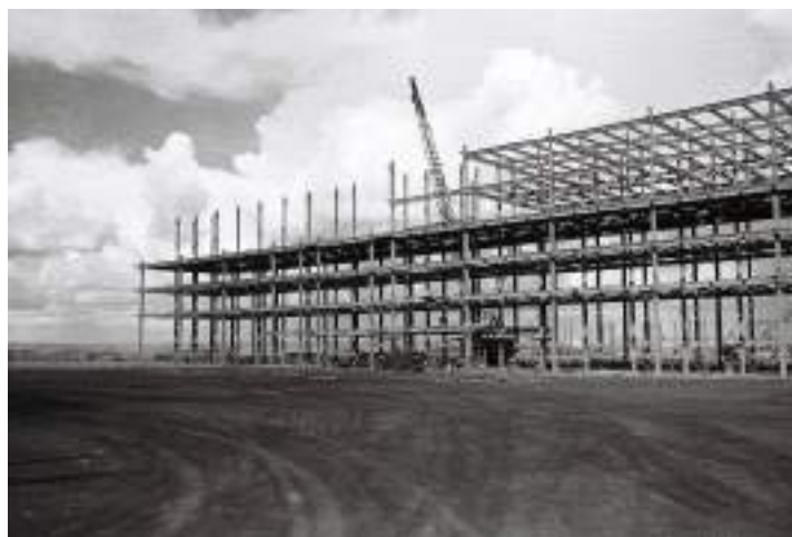
Figura 02: Montagem das estruturas de aço dos edifícios ministeriais, dirigido pela empresa norte-americana Raymond Concret Pile Company of the Americas. Autoria: não identificada. Data: 1959. Fonte: Arquivo Público do Distrito Federal – ArPDF. NOV-D-4-4-B-5 (727)
