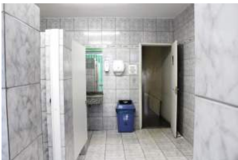
Figura 551. Banheiro social feminino na ala sul.
