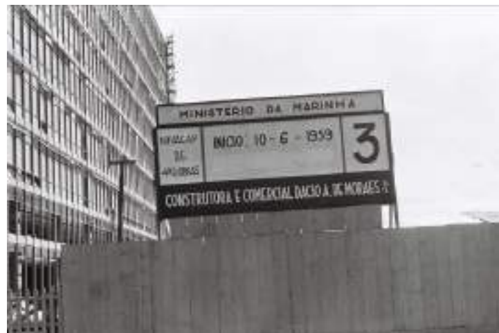
Figura 15: Edifício do Ministério da Marinha (Bloco N) em fase de acabamento, com placa indicativa de informações sobre a obra. Autoria: não identificada. Fonte: Arquivo Público do Distrito Federal – ArPDF. NOV-D-4-4-B-5 (748)
