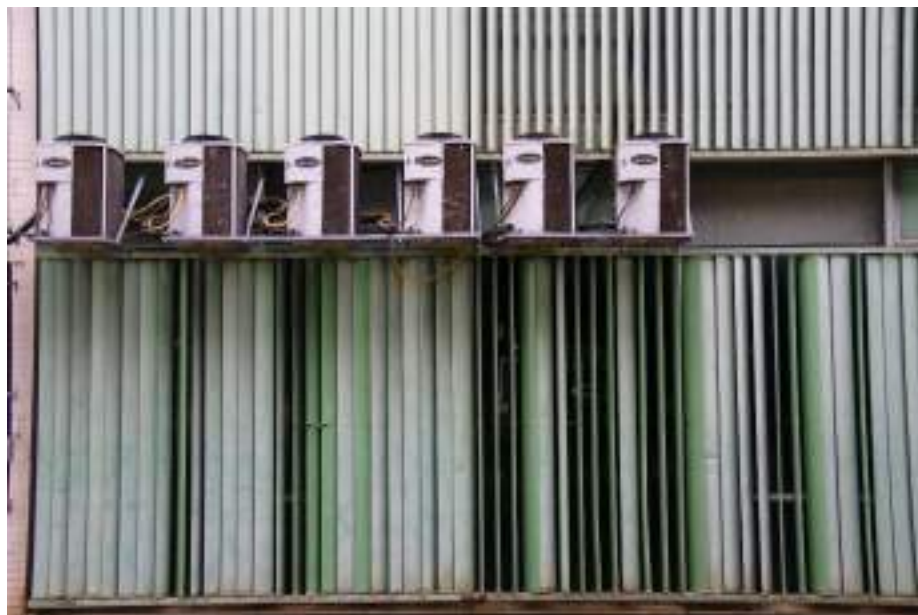
Figura 200. Concentração de unidades de ar-condicionado aparentes na Fachada Oeste, na área do Auditório, no térreo do Edifício Sede. Imagem: Alba Bispo, mar/2020.
