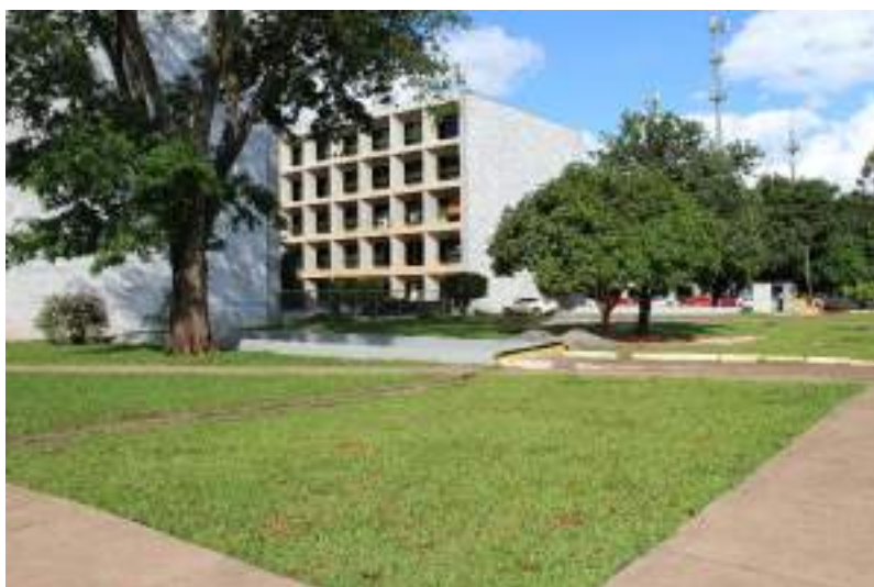
Figura 601. Vista parcial do anexo A: fachada oeste e sul.
