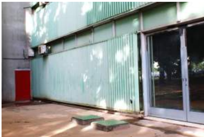
Figura 580. Detalhe dos brise-soleils na fachada oeste e o volume externos dos aparelhos de ar condicionado.
