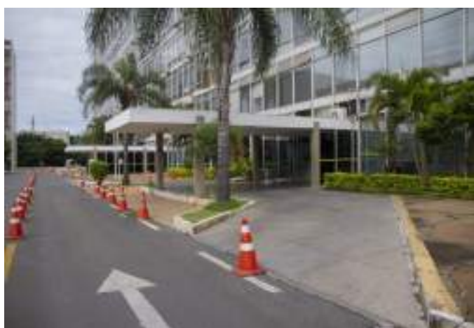
Figura 173. Ausência de esquadria de vidro na marquise da entrada privativa do Edifício Sede, com pavimentação da área ajardinada para acesso veicular, diferente dos demais blocos. Imagem: Alba Bispo, mar/2020.
