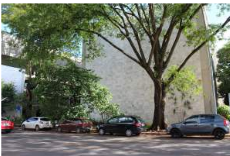
Figura 591. Fachada norte do anexo B.
