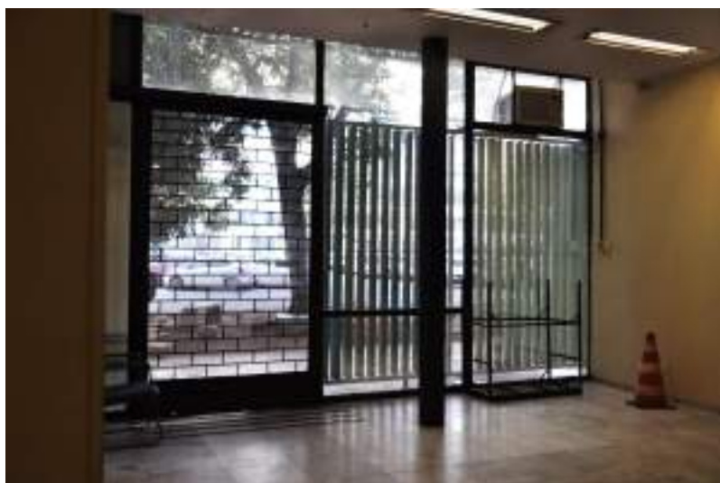
Figura 626. Vista do ambiente do hall de entrada e circulação (nº 07 no croqui), voltado para a fachada oeste.
