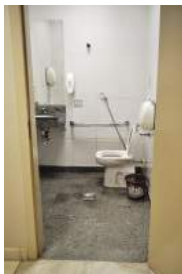
Figura 400. Banheiro feminino e banheiro PNE, respectivamente.
