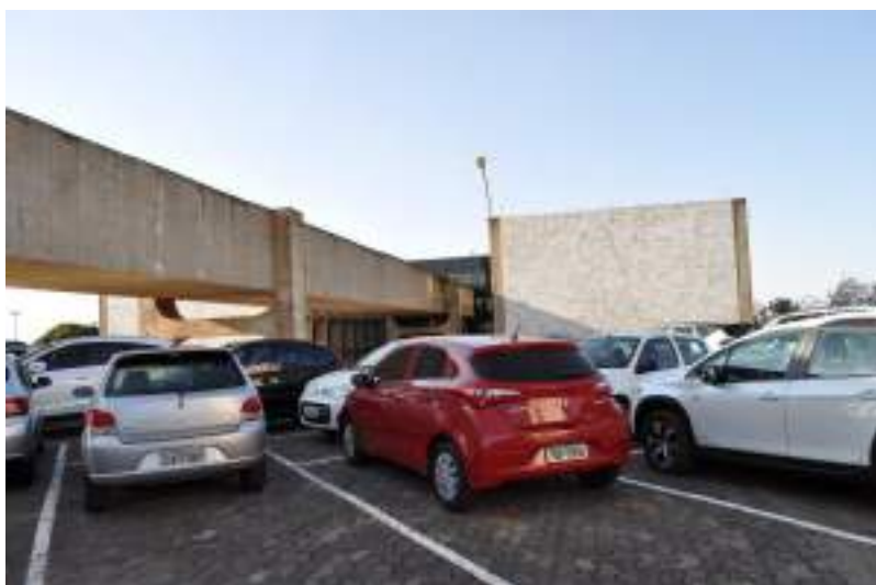
Figura 66. Passarela em concreto que interliga o bloco principal ao seu anexo, na ala norte. Imagem: Camila Morais, set/2019.
