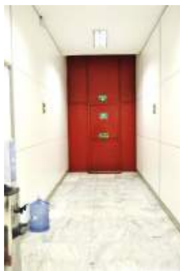
Figura 656. Circulação para saída de incêndio da ala sul e da ala norte, respectivamente.
