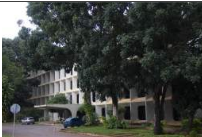
Marquise de entrada do Edifício Anexo. Imagem: Alba Bispo, mar/2020. [Brasilia_AB_mar20_ESPM_BlocoD (40)]
