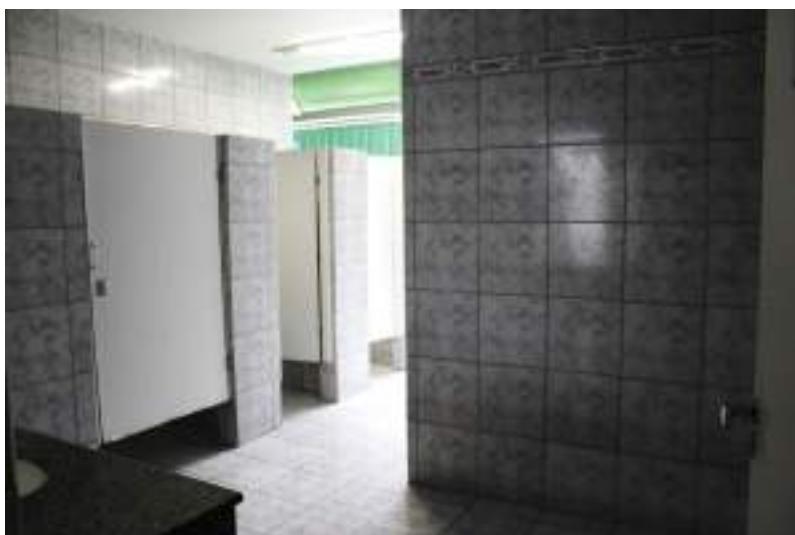
Figura 550. Banheiro social masculino na ala sul.
