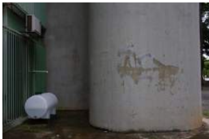
Figura 103. Depósito de coleta para reuso da água derivada das unidades de ar-condicionado aparentes na Fachada Oeste do Edifício Sede; unidade localizada no pavimento e alterações cromáticas no concreto aparente do volume das escadas de emergência. Imagem: Alba Bispo, mar/2020.
