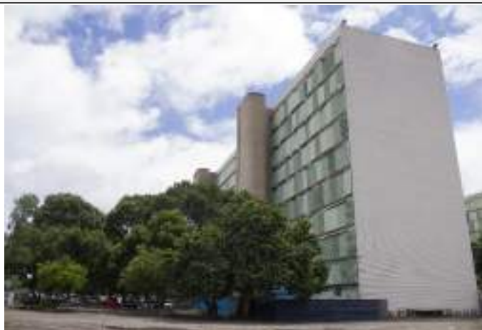
Tapumes da obra do Bloco C. Imagem: Alba Bispo, mar/2020. Brasilia_AB_mar20_ESPM_BlocoC (21)
