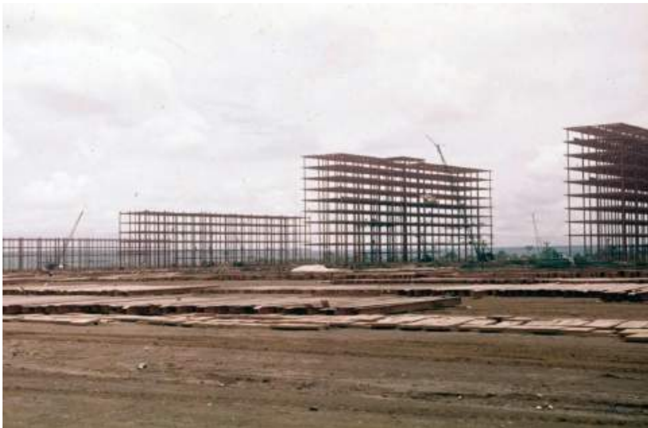
Figura 14. Estruturas de aço dos blocos ministeriais no lado sul. Autoria: s/a. Data: 1958. Fonte: Fundo Novacap ArPDF. (Brasília_SemAutoria_1958_BlocosMinisteriais.sul_.jpg)
