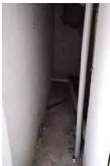
Figura 461. Banheiro privativo de sala administrativa (nº 21 do croqui) e área de shaft , respectivamente.
