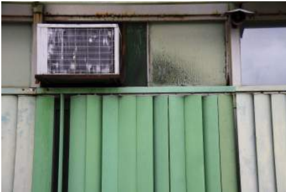
Figura 151. Substituição pontual de um trecho dos brises no térreo da Fachada Oeste do Edifício Sede; notar diversidade cromática de películas. Imagem: Alba Bispo, mar/2020.
