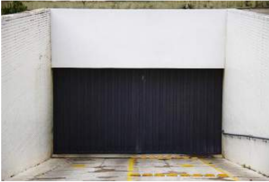
Figura 222. Demolição e construção de novo muro na entrada do estacionamento do Edifício Sede, sem o revestimento padrão em cerâmicas brancas. Imagem: Alba Bispo, mar/2020.
