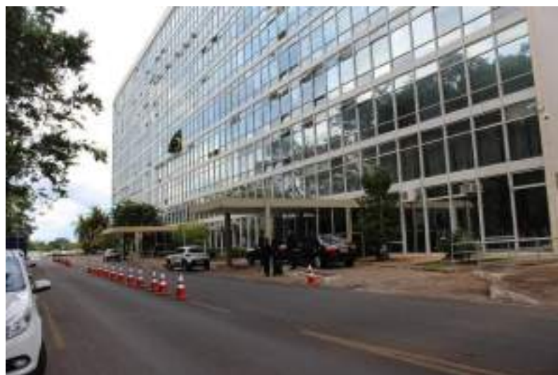
Figura 338. Detalhe da fachada leste do Bloco B, com presença de marquises e películas nos vidros, que foram inseridas posteriormente ao projeto original.
