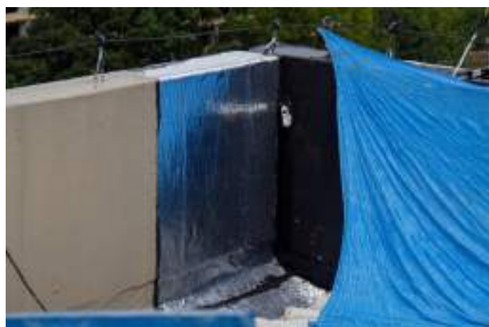
Figura 46. Adição de reboco e manta de impermeabilização na área da calha e platibanda, junto à extremidade da Fachada Sul do Edifício Sede. Imagem: Alba Bispo, mar/2020.
