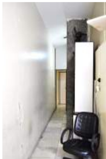
Figura 622. Vista geral da pequena sala de depósito (nº 05 no croqui).
