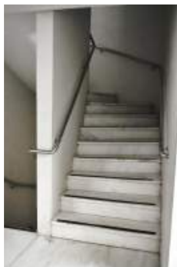
Figura 431. Área de circulação e escada de acesso ao segundo pavimento.
