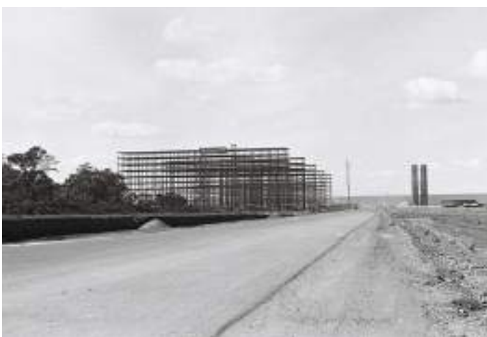
Figura 06: Visada geral da construção do lado Norte da Esplanada dos Ministérios. Autoria: não identificada. Data: 1959. Fonte: Arquivo Público do Distrito 'Federal – ArPDF. NOV-D-4-4-B-2 (255)
