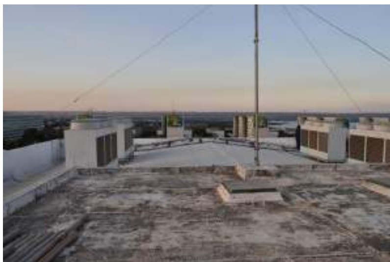
Figura 376. Vista geral da cobertura do bloco B.
