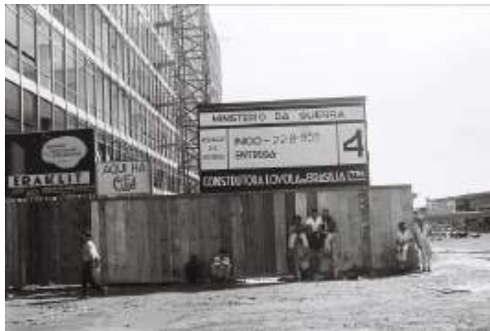
Figura 16: Edifício do antigo Ministério da Guerra, atual Ministério da Defesa (Bloco O) em fase de acabamento, com placa indicativa de informações sobre a obra. Autoria: não identificada. Fonte: Arquivo Público do Distrito Federal – ArPDF. NOV-D-4-4-B-5 (737)
