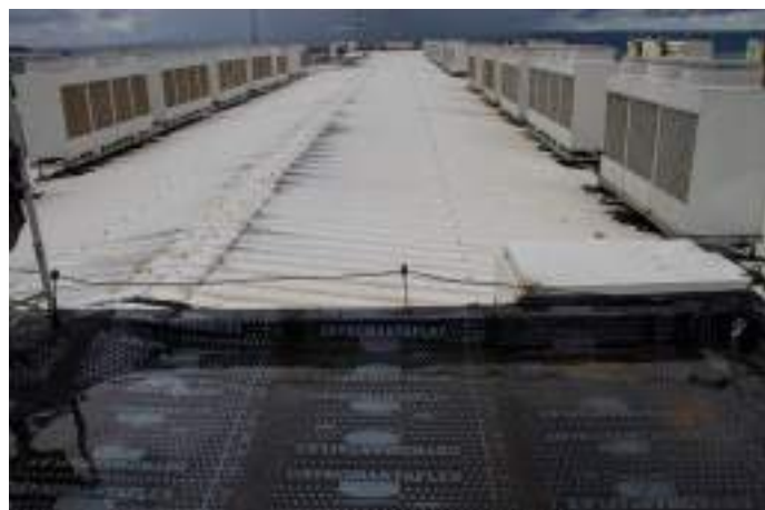
Figura 45. Visão geral da cobertura do Edifício Sede com obra de impermeabilização; notar locação das unidades condensadoras e passarelas metálicas para circulação na cobertura que apresenta bom estado de conservação. Imagem: Alba Bispo, mar/2020.
