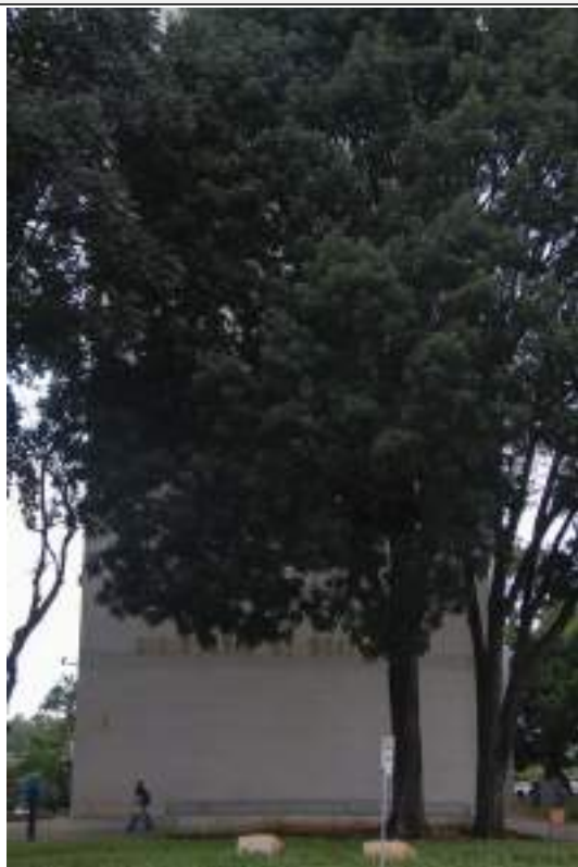
Fachada Norte do Bloco F. Alba Bispo, mar/2020. [Brasília_AB_mar20_ESPM_BlocoF (106)]
