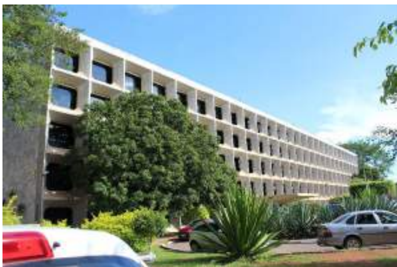
Figura 602. Fachada oeste do anexo B, do bloco F.
