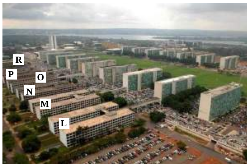
Figura 344. Vista aérea da Esplanada dos Ministérios, com os prédios anexos da ala norte em primeiro plano.
