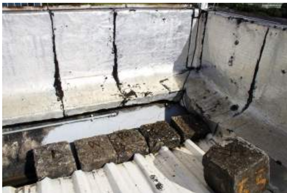
Figura 224. Reparos na área da extremidade da platibanda entre as Fachadas Norte e Oeste do Edifício Sede onde há incidências de fissuras e trincas. Imagem: Alba Bispo, mar/2020.
