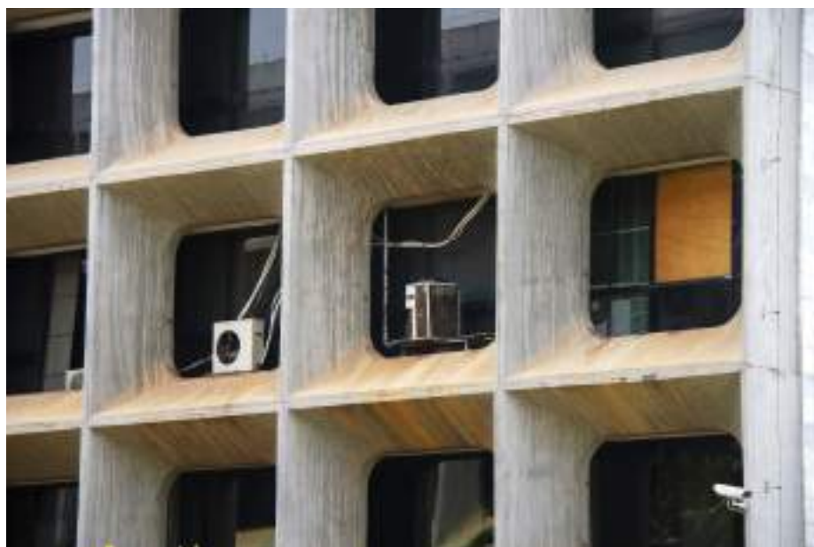
Figura 230. Sujidades no concreto aparente, sobretudo nos andares inferiores do Edifício Anexo; dano estético provocado por instalação de unidades aparentes de ar-condicionado e película de tonalidade distinta no 3º pavimento. Imagem: Alba Bispo, mar/2020.
