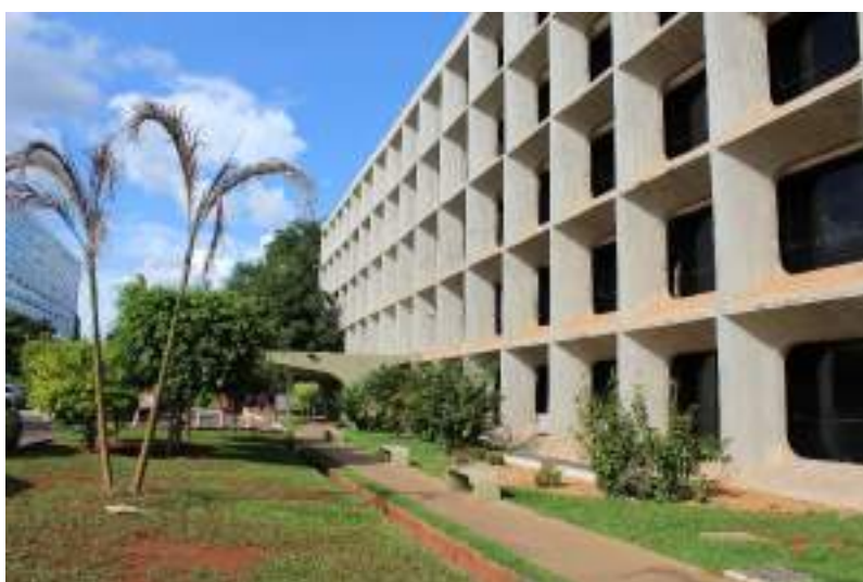
Figura 611. Vista do passeio e canteiros ajardinados próximo à fachada oeste do prédio anexo.
