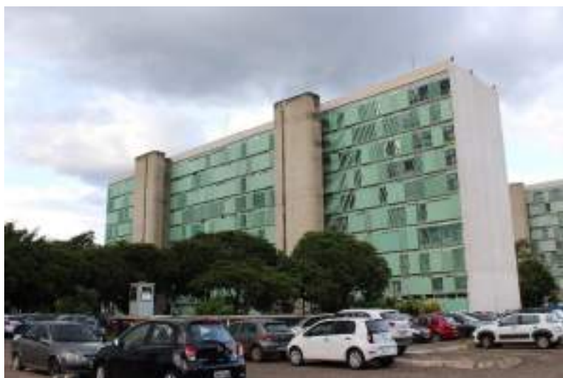
Figura 371. Fachada oeste do bloco B.
