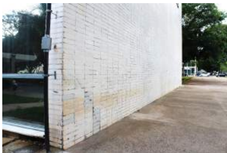
Figura 570. Detalhe do revestimento cerâmico da fachada norte do bloco F.
