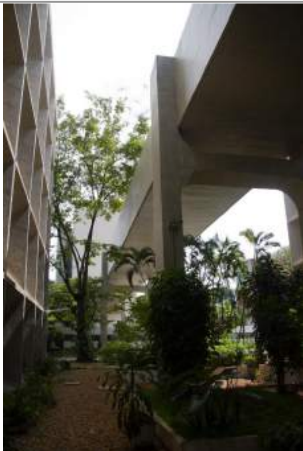
Estrutura da passarela de ligação em concreto aparente e jardins do Edifício Anexo. Imagem: Alba Bispo, mar/2020. [Brasilia_AB_mar20_ESPM_BlocoF (112)]
