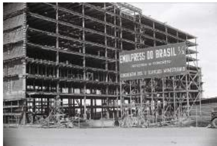
Figura 17: Edifício ministerial em fase de concretagem das estruturas de aço, realizada pela empresa Emulpress do Brasil S/A, com placa indicativa da empresa responsável. Autoria: não identificada. Fonte: Arquivo Público do Distrito Federal – ArPDF. NOV-D-4-4-B-5 (756)
