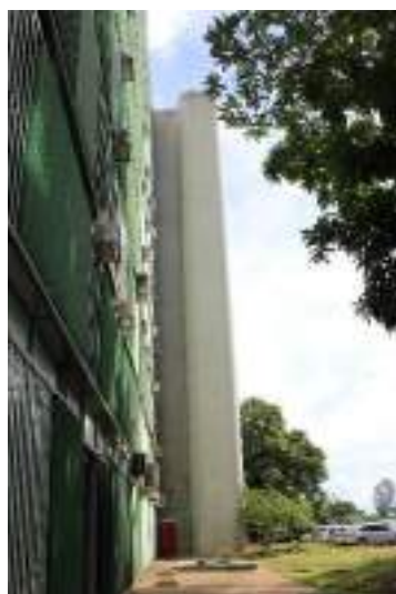
Figura 578. Detalhe do volume da escadaria externa na fachada oeste do bloco F.
