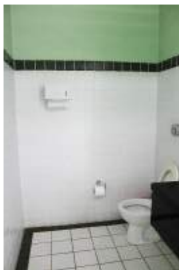
Figura 549. Banheiro privativo na ala sul (n° 08 do croqui).
