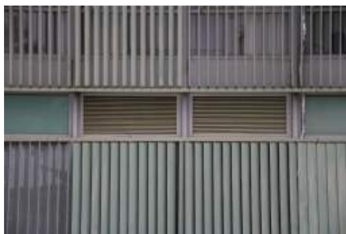
Figura 10. Inserção pontual de venezianas em substituição ao vidro na Fachada Oeste do Edifício Sede; notar também tubulação aparente. Imagem: Alba Bispo, mar/2020.
