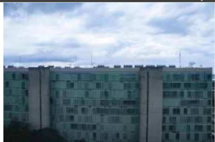
A maioria das unidades condensadoras do Bloco B são lotadas na cobertura. Imagem: Alba Bispo, mar/2020. [Brasilia_AB_mar20_ESPM_BlocoB (34)]
