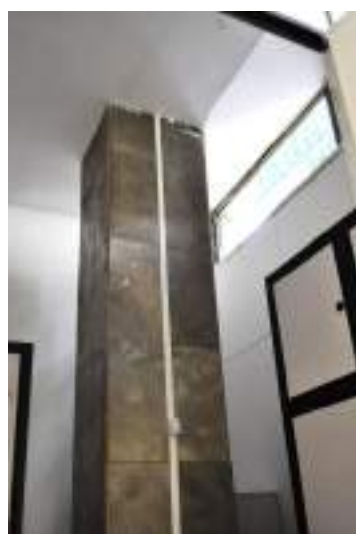
Figura 624. Vista interna do ambiente utilizado como área de descanso por funcionários (nº 06 no croqui).
