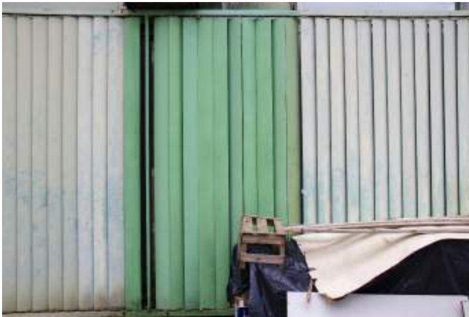
Figura 150. Substituição pontual de um trecho dos brises no térreo da Fachada Oeste do Edifício Sede. Imagem: Alba Bispo, mar/2020.
