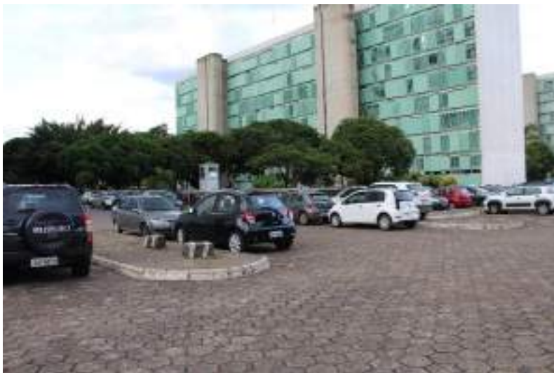
Figura 353. Área de estacionamento junto à fachada oeste do bloco B.
