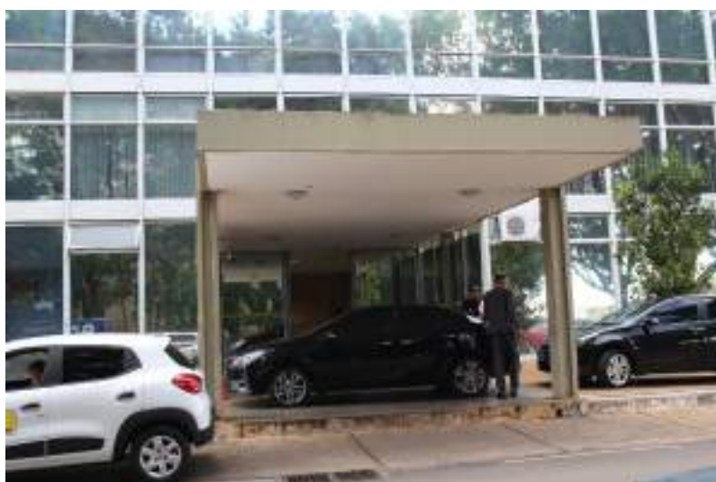
Figura 369. Vista geral da marquise sobre o acesso privativo.
