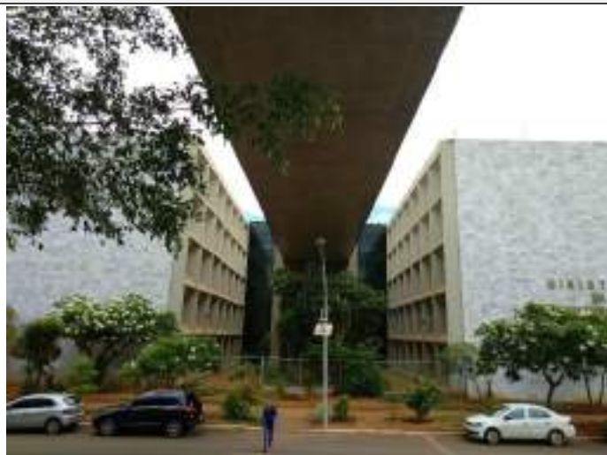
Vista da Fachada Norte dos Anexos do Bloco D e passarela de ligação em concreto aparente. Imagem: Alba Bispo, mar/2020. [Brasilia_AB_mar20_ESPM_BlocoD (41)]
