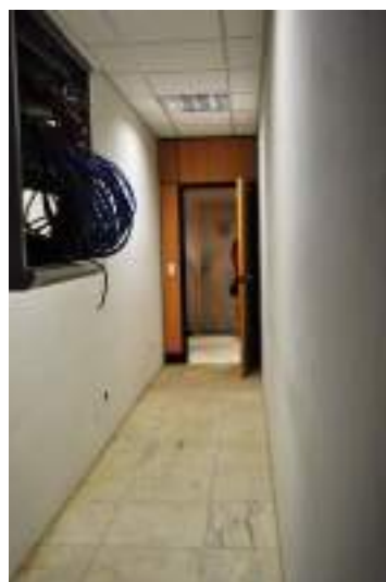
Figura 406. Sala técnica ao lado da sala de espera do auditório.
