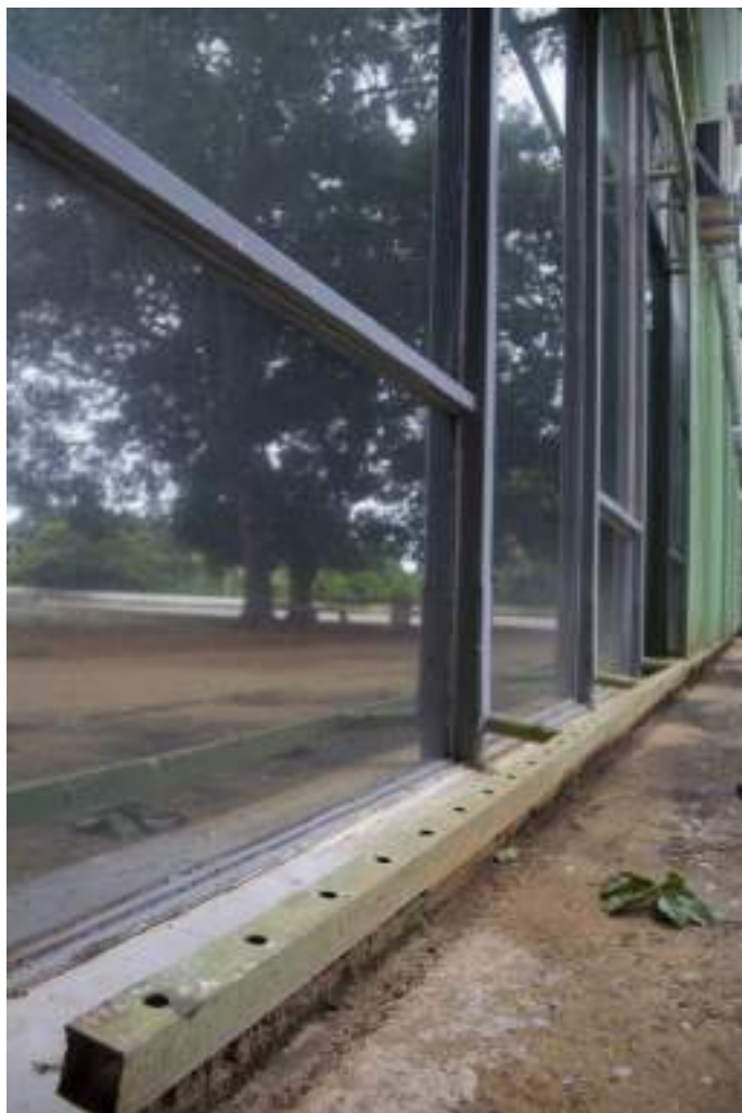
Figura 130. Supressão parcial de brises no térreo do Edifício Sede. Imagem: Alba Bispo, mar/2020.
