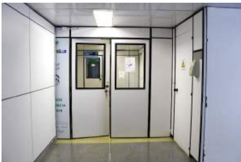
Figura 730. Acesso ao Posto de Saúde desativado, na ala norte do anexo B.
