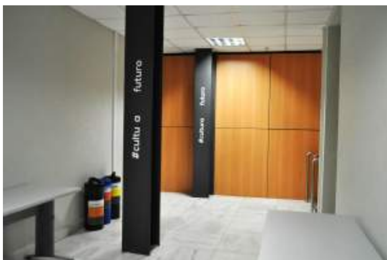
Figura 393. Detalhe dos perfis “I” estruturais, presentes no corredor de acesso à sala técnica do auditório.
