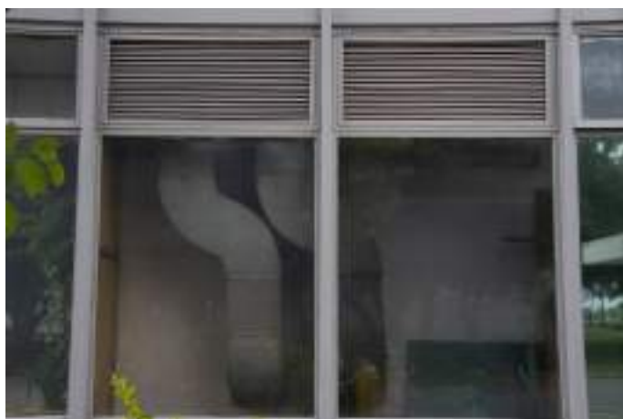
Figura 7. Inserção pontual de venezianas em substituição ao vidro na Fachada Leste do Edifício Sede; notar diversidade de películas. Imagem: Alba Bispo, mar/2020.
