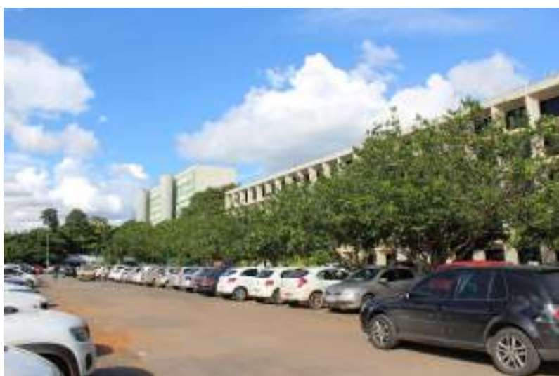
Figura 608. Áreas de estacionamento próximas à fachada oeste do prédio anexo.
