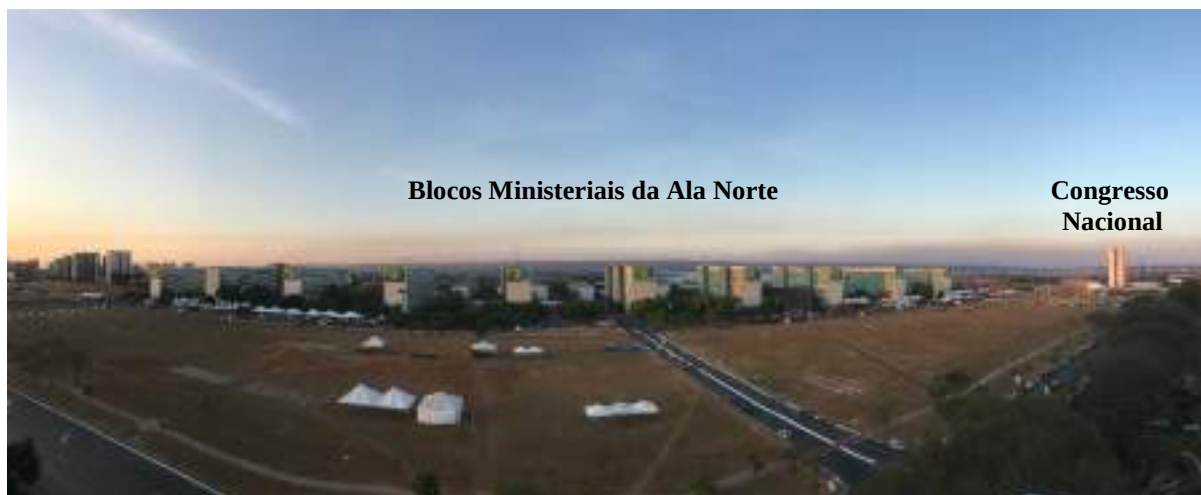
Figura 50. Vista panorâmica, a partir da cobertura do bloco ministerial B, da área gramada central e dos blocos ministeriais da ala norte. A partir da esquerda para direita, os blocos são: J, K, L, M, N, O, P, Q, U e R. Imagem: Camila Morais, set/2019.
