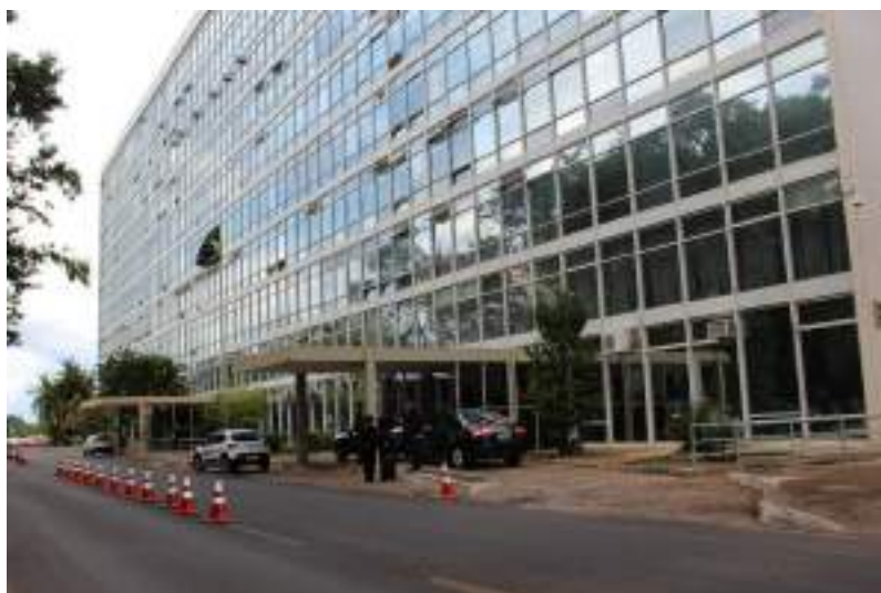
Figura 368. Acesso ao prédio demarcado pelas marquises. A que está em primeiro plano corresponde ao cesso privativo.
