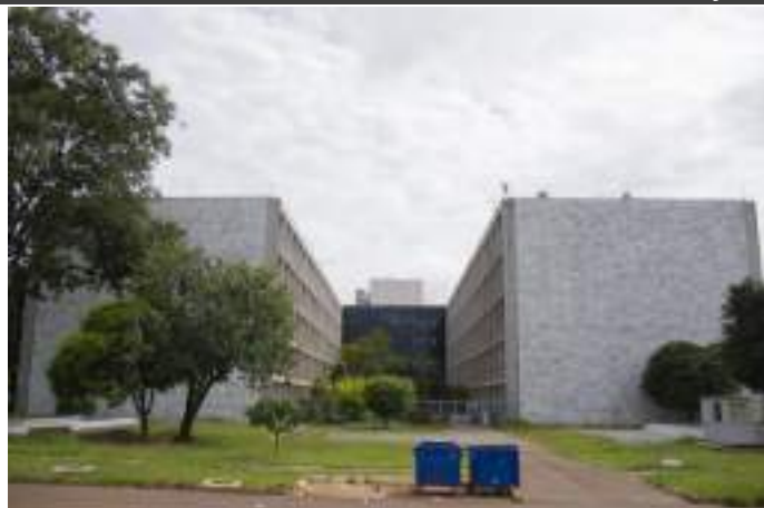
Fachada Sul do Edifício Anexo em mármore branco. Imagem: Alba Bispo, mar/2020. [Brasilia_AB_mar20_ESPM_BlocoF (110)]
