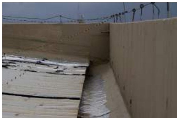
Figura 47. Obra de impermeabilização na área da calha e platibanda do Edifício Sede. Imagem: Alba Bispo, mar/2020.
