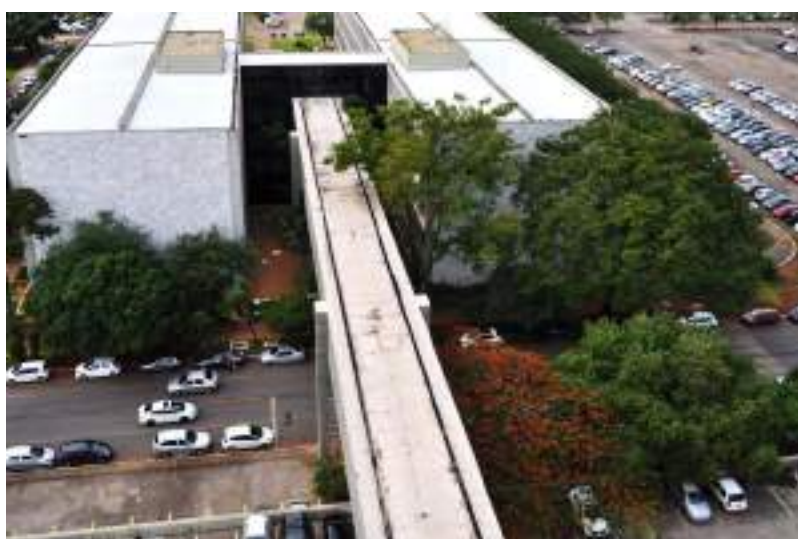
Figura 589. Vista da cobertura da passarela do bloco F, a partir do edifício sede.
