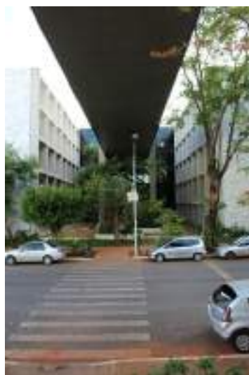
Figura 586. Vista da passarela sobre a via S2 e vista da passarela chegando ao prédio anexo, respectivamente.
