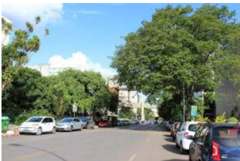
Figura 605. Vista geral da via S2, de acesso veicular ao prédio anexo.
