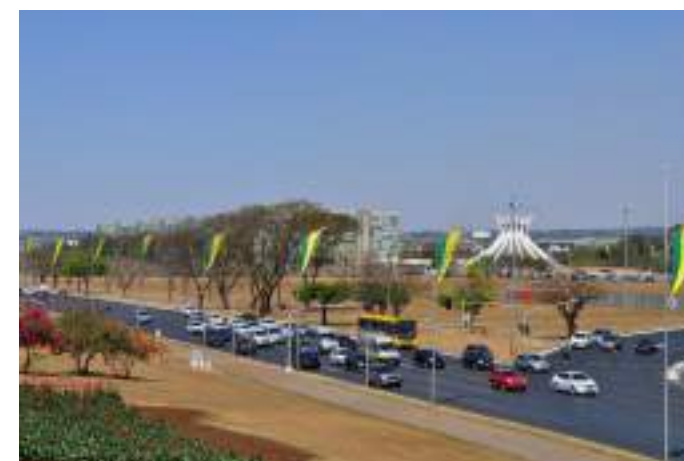
Figura 22: Visada de parte da porção sul da Esplanada dos Ministérios a partir do viaduto do Eixo Rodoviário que cruza o Eixo Monumental. À direita da imagem, a Catedral de Brasília, planejada por Oscar Niemeyer. Imagem: Camila Moraes, set/2019
