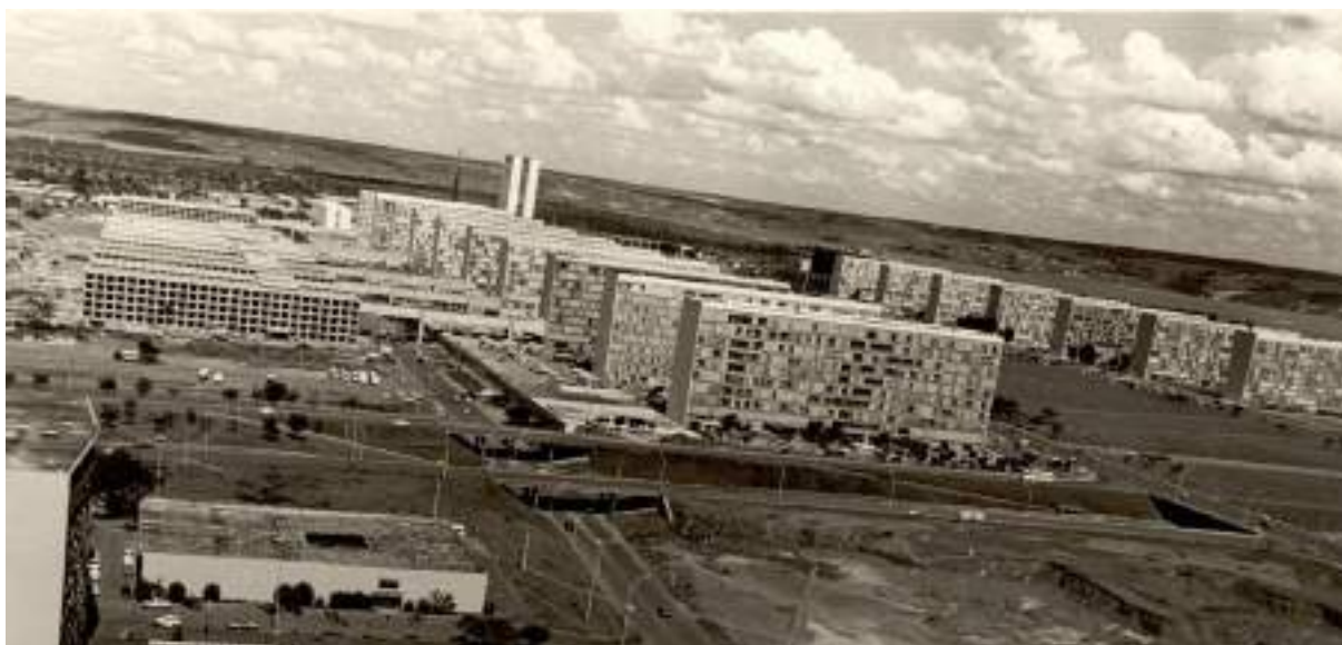
Figura 69. Inserção discreta dos Anexos junto aos edifícios-sede na Esplanada dos Ministérios.
