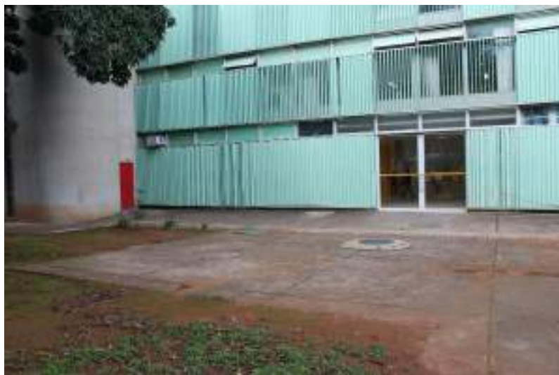
Figura 374. Detalhe dos brise-soleils na fachada oeste, o volume externo do aparelho de ar condicionado, a porta de saída de incêndio e a porta de acesso da fachada oeste.
