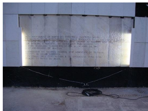
Figura 80 - Prova do sistema de iluminação da inscrição no revestimento de mármore da Pira (IPHAN-DF)
