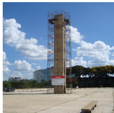
Figura 85 - Recuperação estrutural do Pombal (IPHAN-DF)
