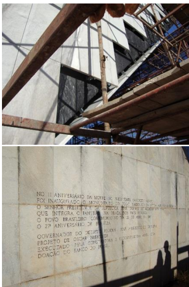
Figura 76 - Recuperação do revestimento em mármore do Panteão e da Pira (IPHAN-DF)
