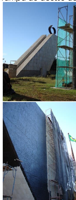
Figura 77 - Recuperação do Revestimento em mármore do Panteão e da Pira (IPHAN-DF)
