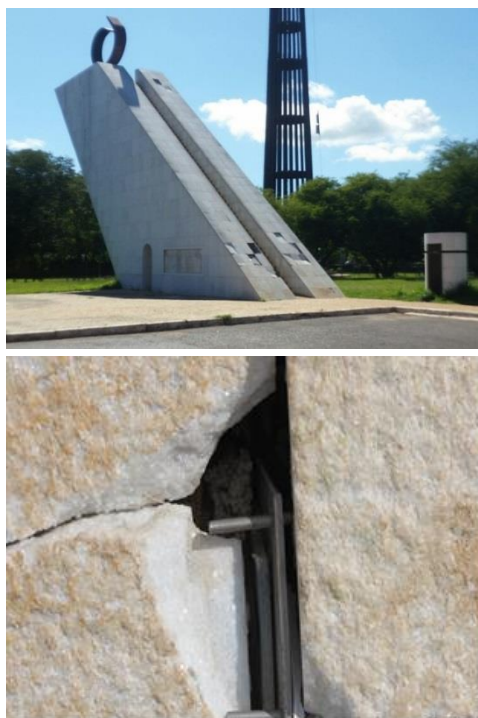
Figura 91 - Recuperação do mármore das fachadas da Pira e do Panteão (Iphan-DF)
