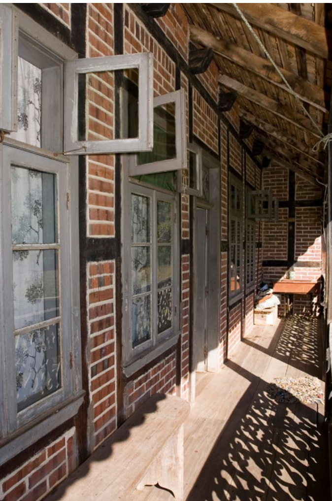
Detalhe de varanda da Casa Ristow, em Indaial.
