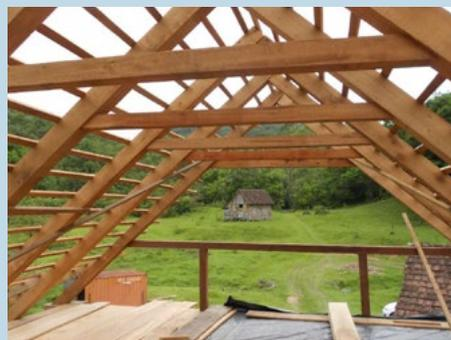
Estruturas de madeira deterioradas devem, na medida do possível, ser substituídas por madeira de propriedades similares e não por materiais como concreto e aço. Peças antigas de madeira podem apresentar sinais de deformação ou mesmo ataque de cupins, mas nem sempre estão totalmente comprometidas.
