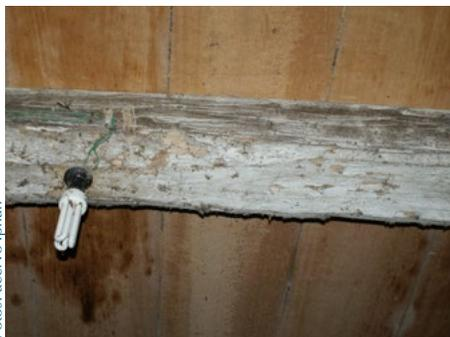
*Acima, detalhe de varanda, com sequencia das pontas aparentes dos barrotes que formam o sistema de caibros armados da estrutura do telhado. Abaixo, manchas de umidade causadas por infiltração de telhado em tábuas do piso do sótão.*
