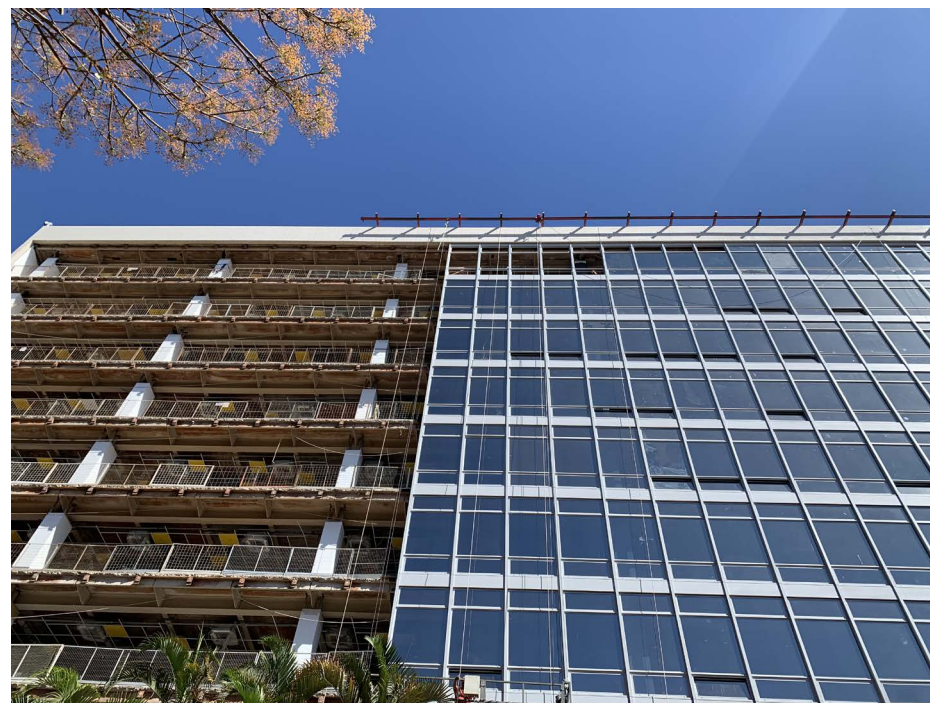
Instalação esquadrias Bloco O. Iphan, 2023.
