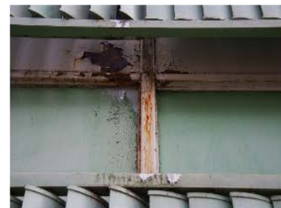
S. Oxidação e corrosão de esquadrias
