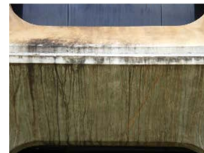
A. Sujidades e manchas de infiltração
