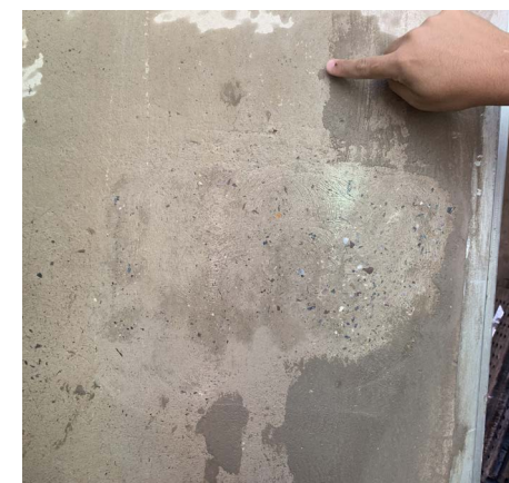
Execução de testes para avaliação e definição do tratamento do concreto aparente no Bloco O. Iphan, 2023.
