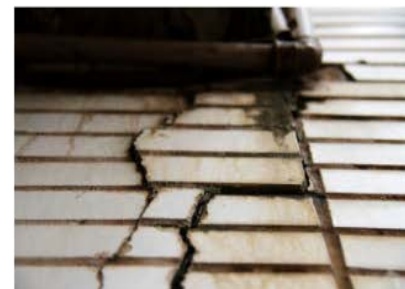
S. Det. Destacamento peças cerâmicas.
