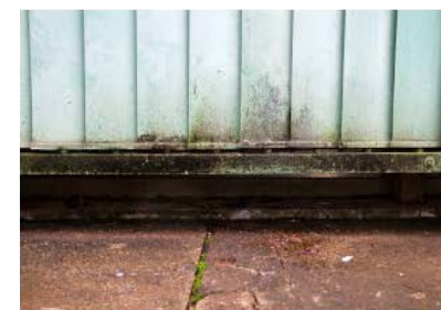
S. Umidade e corrosão dos brises
