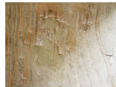
A. sujidades e descascamento do concreto
