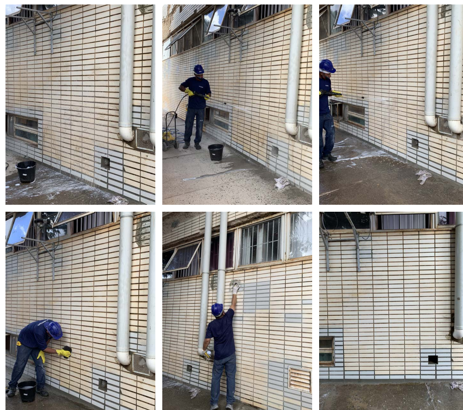
Acompanhamento de processo de limpeza das cerâmicas do embasamento e avaliação dos resultados. Iphan, 2020.
