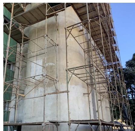
Execução de testes para avaliação e definição do tratamento do concreto aparente no Bloco O. Iphan, 2023.
