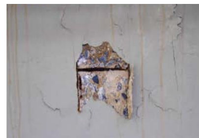
A. Lacuna no concreto com exposição de ferragens no teto da marquise
