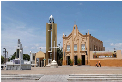
Capela de Nossa Senhora do Perpétuo Socorro - 2020
