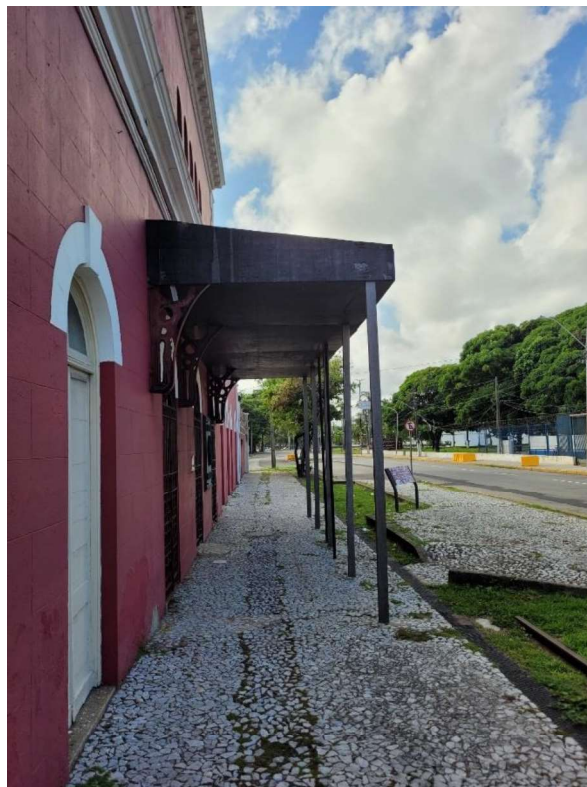
Figura 04 –Toldo com mãos-francesas de ferro na fachada posterior da Estação do Brum protegido para ser restaurado
