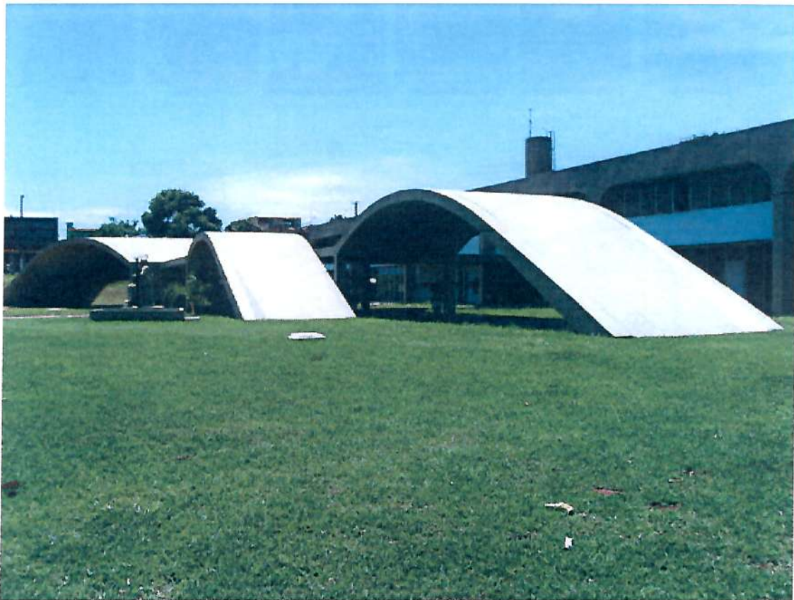
Figura 16. Casa do Teatro Amador, Ceilândia, Distrito Federal. Fonte: imagens https://www.google.com.br
