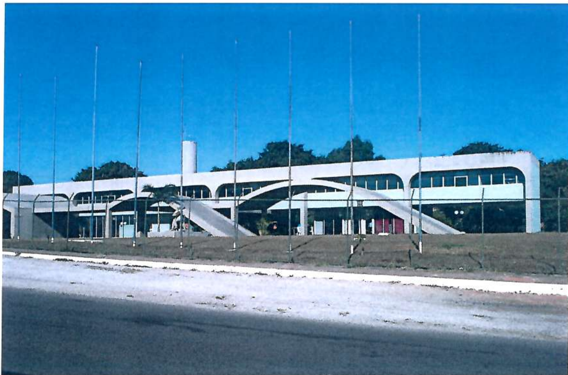
Figura 17. Casa do Teatro Amador, Ceilândia, Distrito Federal. Fonte: imagens https://www.google.com.br
