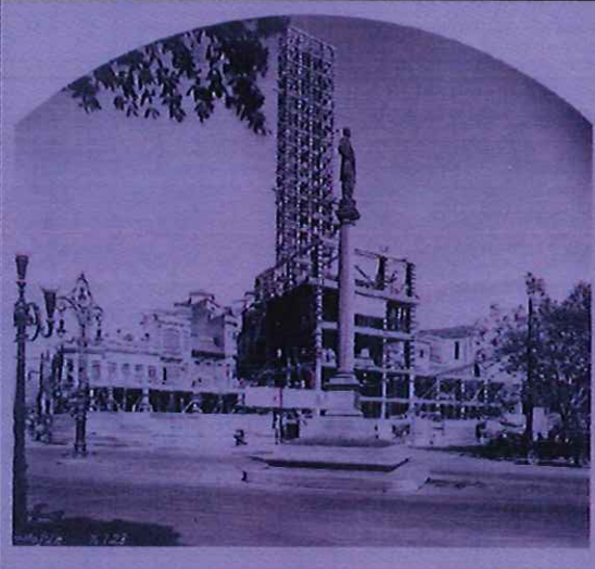
Edifício "A Noite" em construção, Joseph Gire e Elisiário da Cunha Bahiana (1928)
