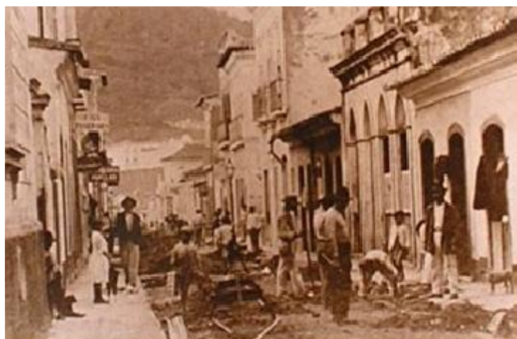
Imagem 11: Detalhe das obras na Rua João Pinto.
