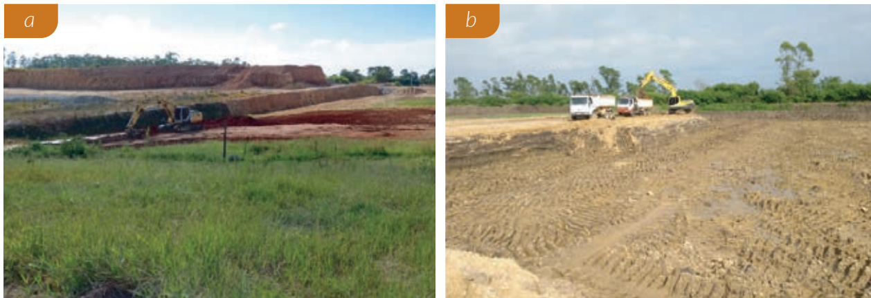
Figura 10. (a) Frente de lavra em ambiente de morro, e (b) em ambiente de várzea, ambas executadas com escavadeiras hidráulicas e caminhões basculantes.
