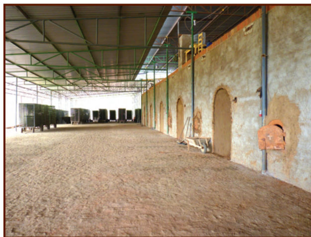
Figura 4: Cerâmica São Francisco - forno cedan em construção e forno cedan ativo.
