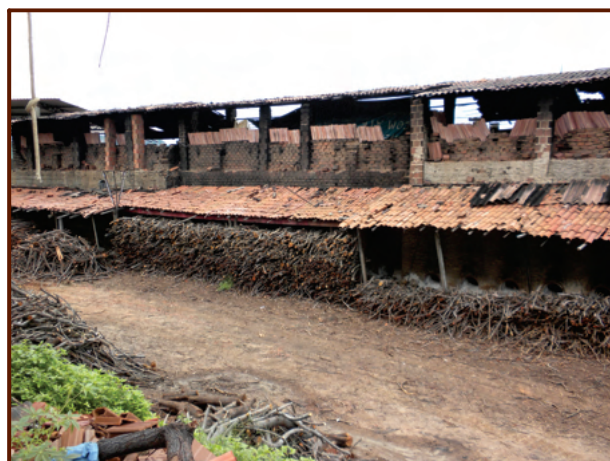
Figura 2: Conjunto de fornos caipira construídos lado a lado aproveitando paredes laterais.
