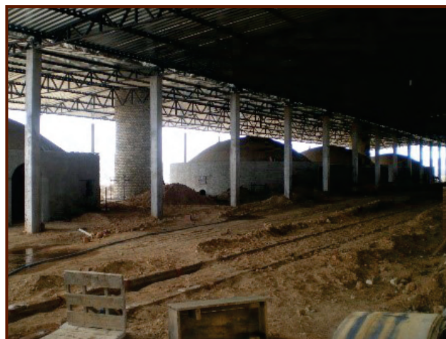
Figura 2: Cerâmica Bela Vista - evolução da construção dos fornos abóbada (fornos e pavimentação).
