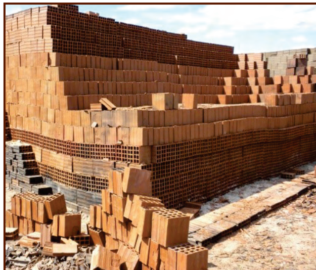
Figura 5: Cerâmica Nossa Senhora dos Impossíveis - tijolos montando os fornos caieira.
