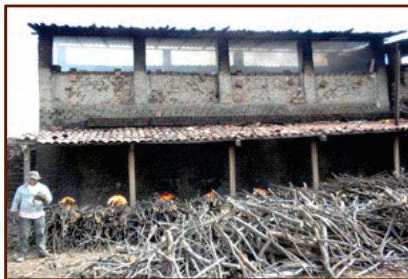
Figura 1: Vista frontal de forno caipira por onde se dá a alimentação de lenha.
