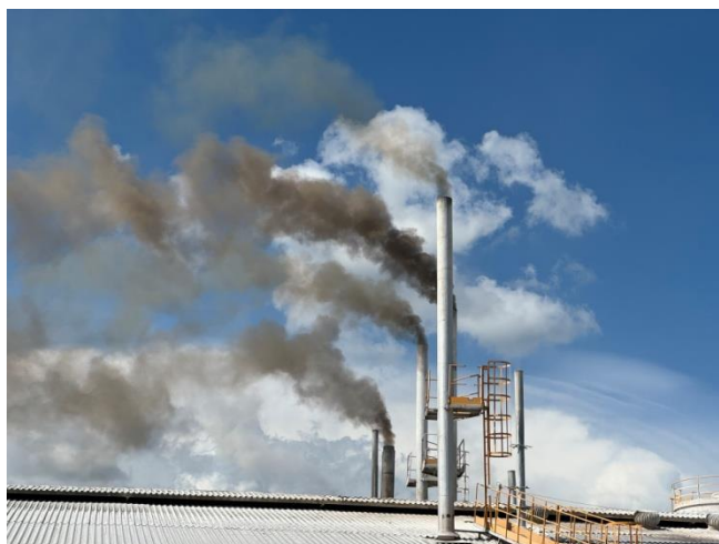
Figura 12. Queima deficiente de lenha em toras com alimentação manual.
