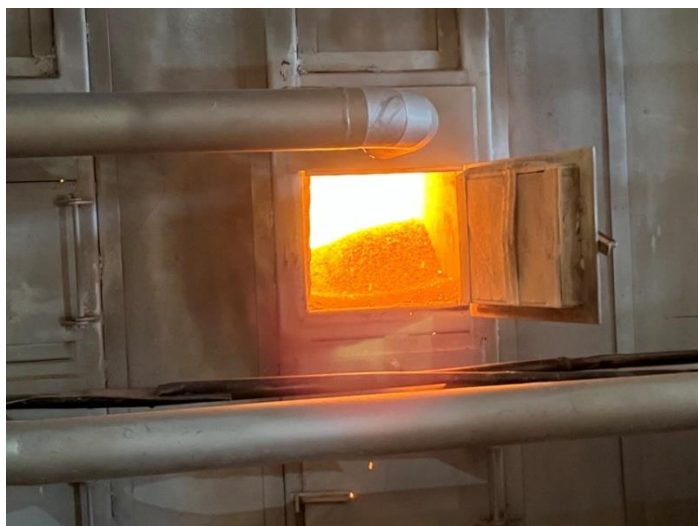
Figura 14. Vista de fornalha com queima de lenha picada.
