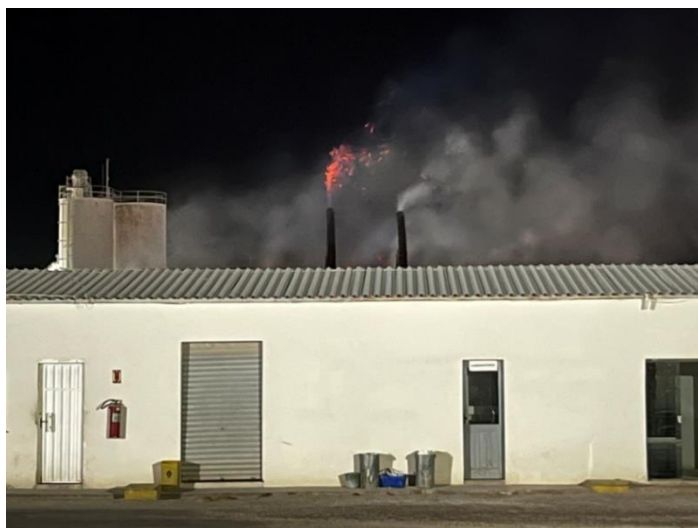
Figura 13. Chaminé de calcinador indicando temperatura acima de 500°C e emissão de fuligem.
