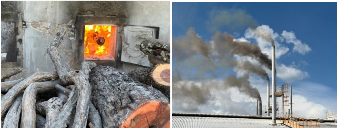
Figura 6. À esquerda - queima de lenha em toras sem controle de alimentação e da combustão; à direita emissões de fuligem por má combustão.
