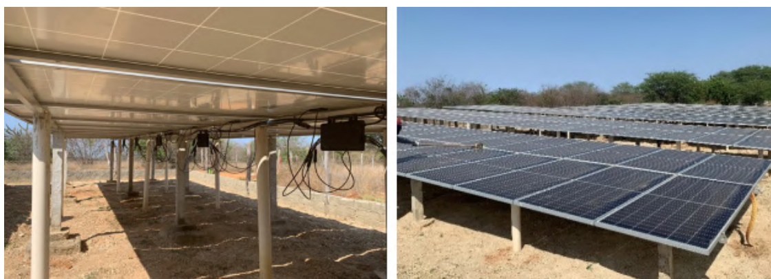
Figura 1. Instalação de painéis solares.
