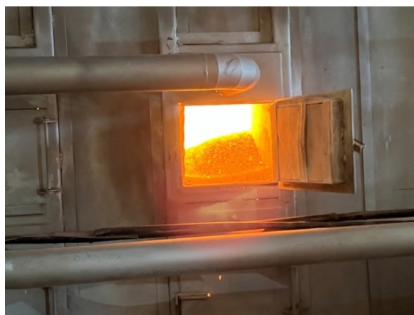
Figura 5. Vista da fornalha com queima de lenha picada.
