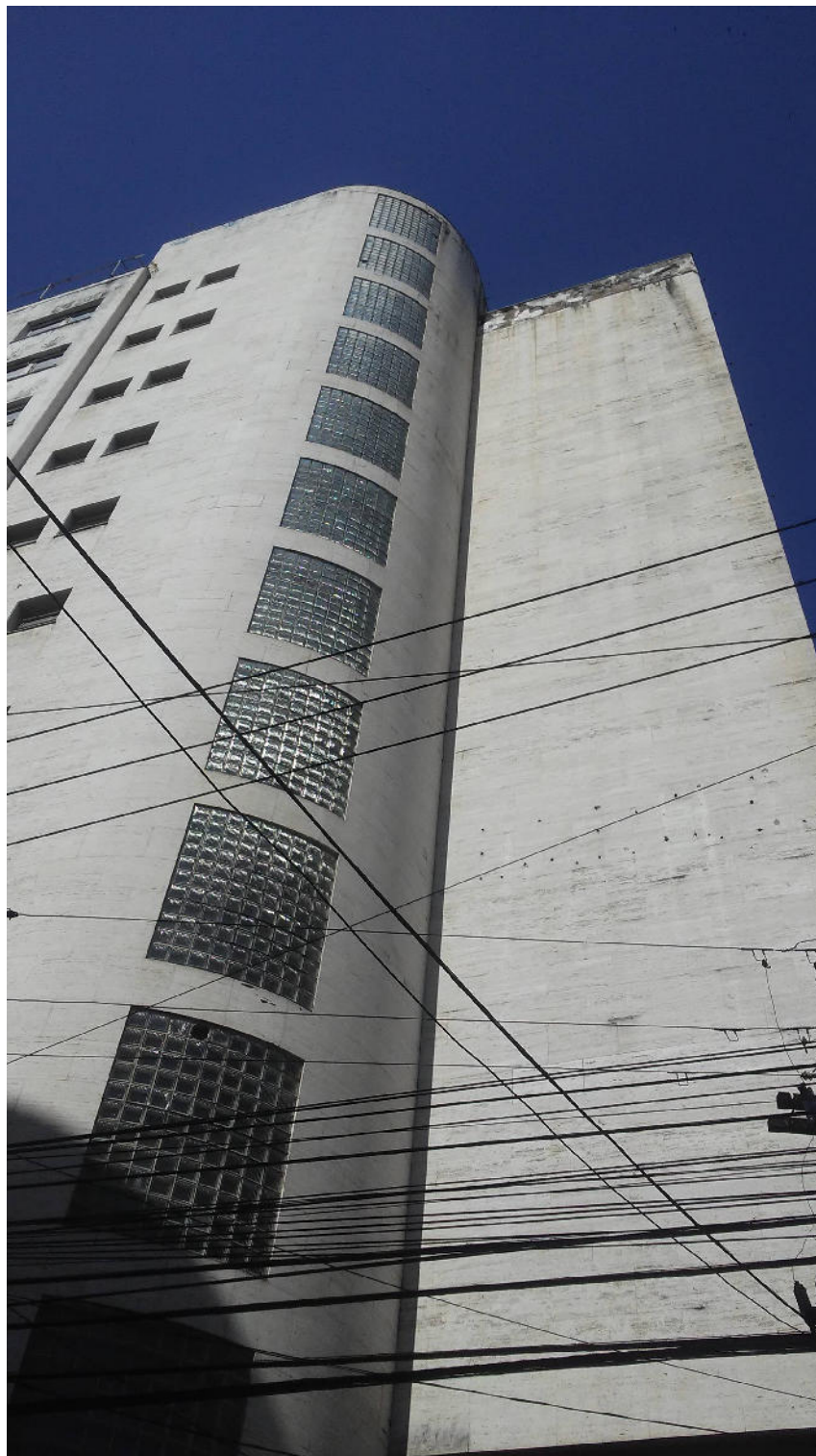
Foto 03 – Fachada voltada para a esquina das ruas
