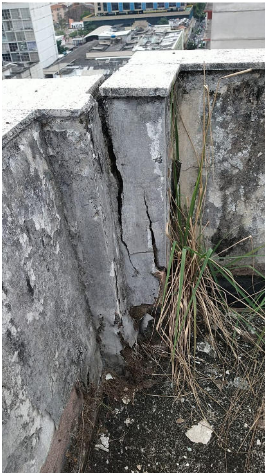
fotos 25 e 26 - inspeção da abertura na mureta de vedação e proteção na cobertura
