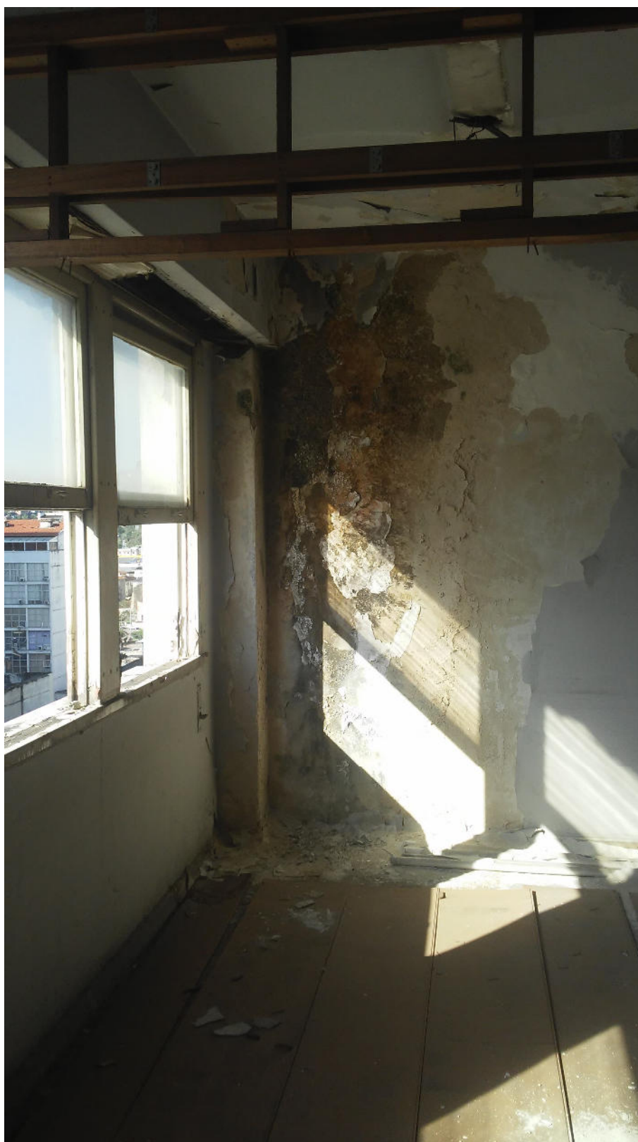
foto 14 - trecho abaixo da abertura na mureta da cobertura, sem sinal de trincas ou fissuras nas estruturas, as manchas mostram que a água escorre por fora e acompanhando o tubo de queda
