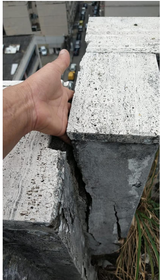
fotos 25 e 26 - inspeção da abertura na mureta de vedação e proteção na cobertura
