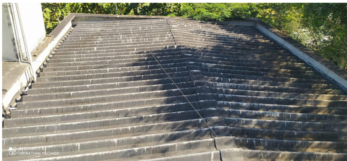
foto 32 - telhado na cobertura do prédio do arquivo.
