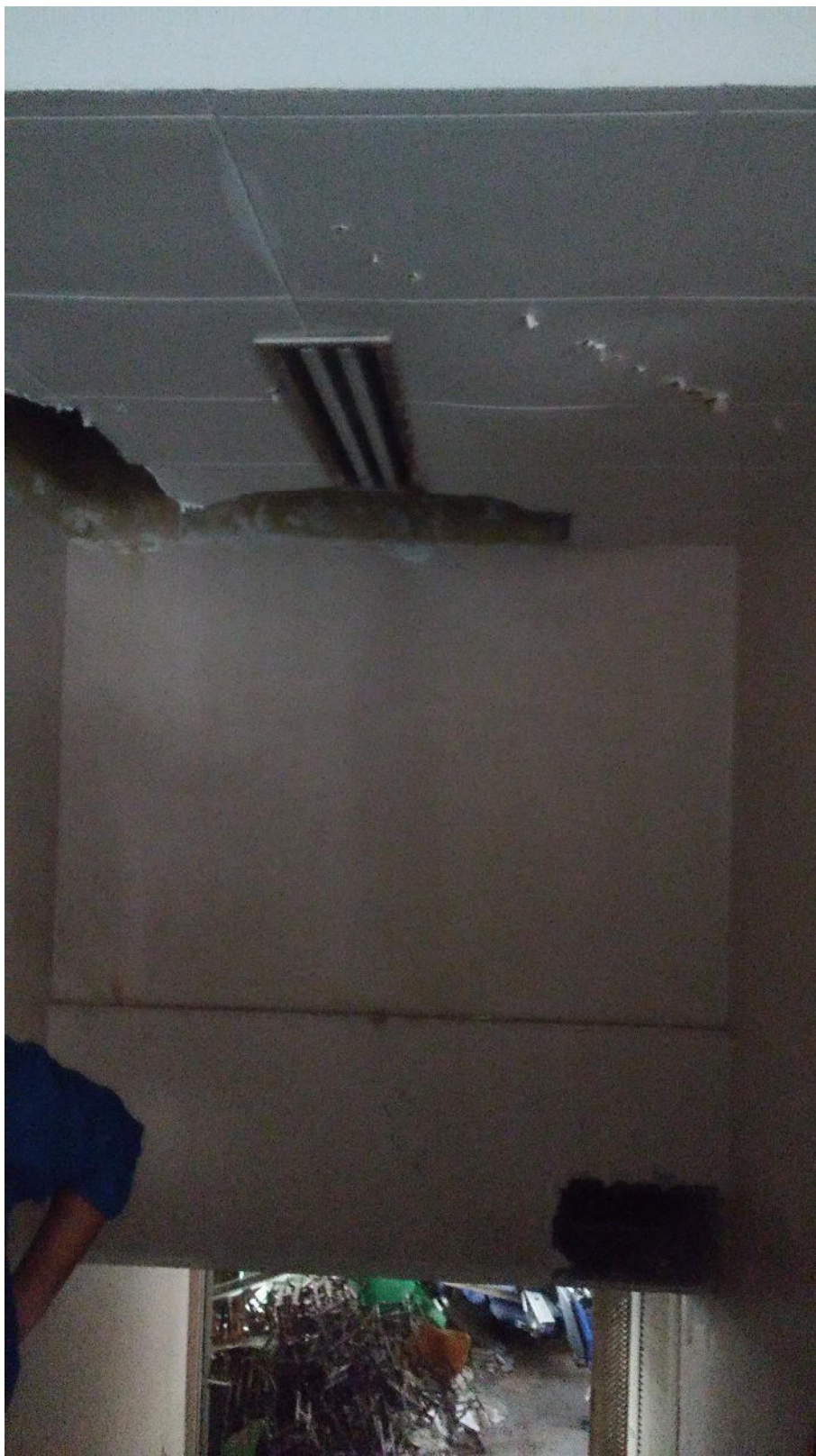
foto 20 - forro da escadaria de acesso ao anfiteatro
