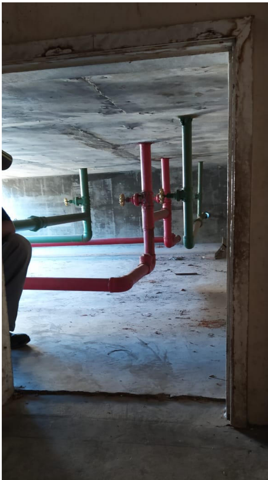
foto 26 - acesso ao telhado sob o reservatório
