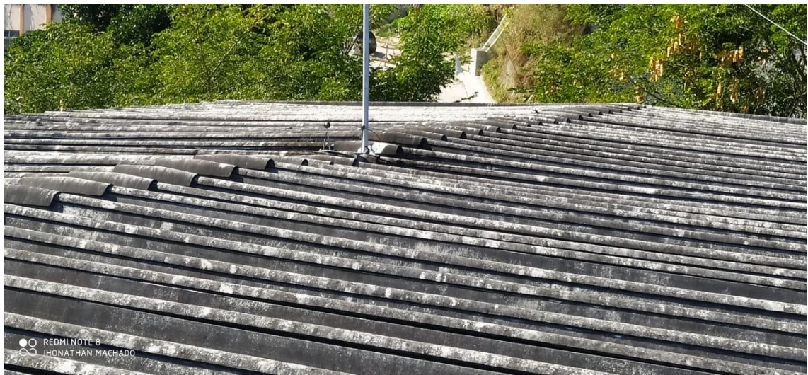
foto 33 - telhado sobre o anfiteatro da APS
