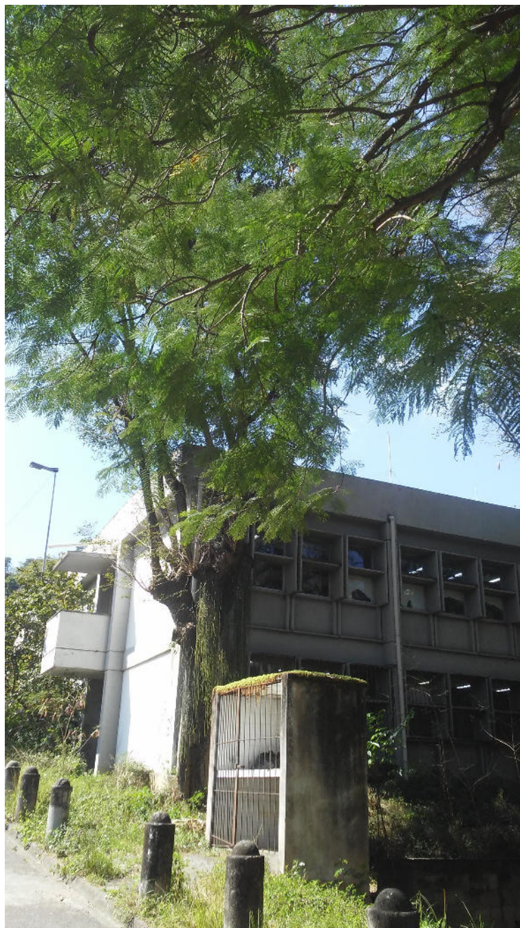
foto 14 - vista lateral do prédio do arquivo
