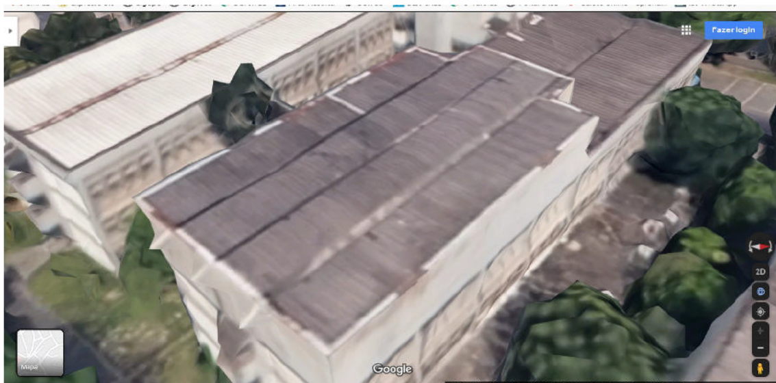
foto 29 - telhado dos dois blocos do prédio da APS
