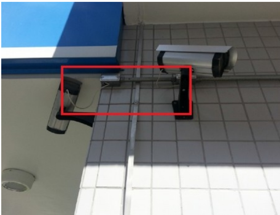
Figura 18 - Cabeamento exposto da câmera externa e eletroduto em contato com a descida do pára-raio. (INCORRETO)
