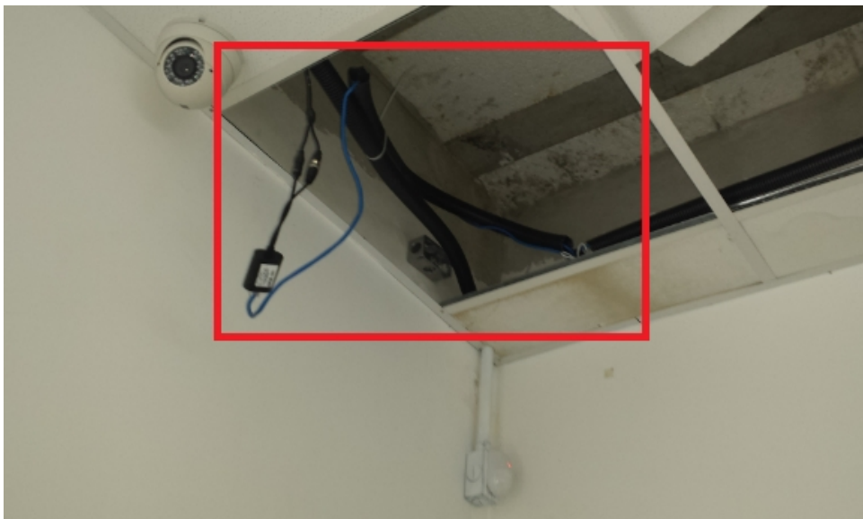
Figura 5 - Utilização de corrugado, fiação exposta e balun solto sobre o forro (INCORRETO)
