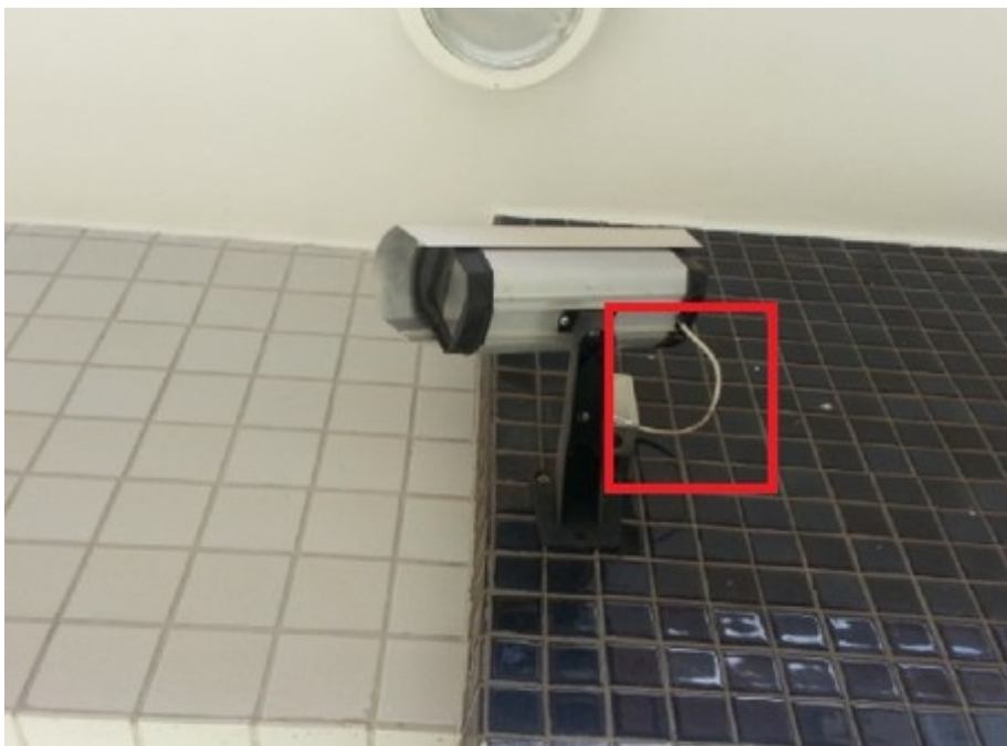
Figura 17 - Cabeamento exposto da câmera externa (INCORRETO)
