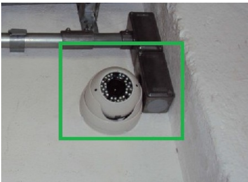
Figura 21 - Não há cabos expostos (CORRETO)
