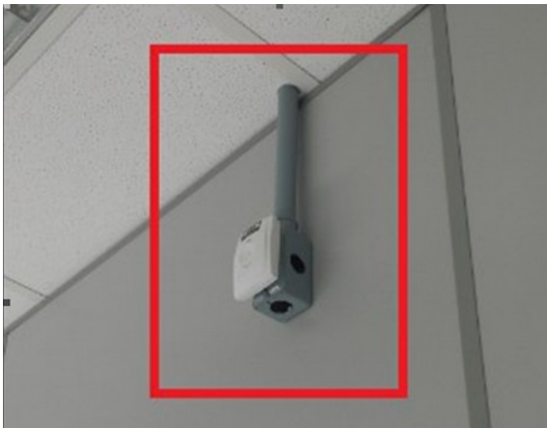
Figura 22 - Condulete do sensor quebra de vidro sem as tampas (INCORRETO)
