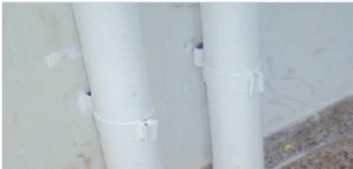
Figura 10 - infraestrutura aparente com péssimo acabamento ( INCORRETO )
