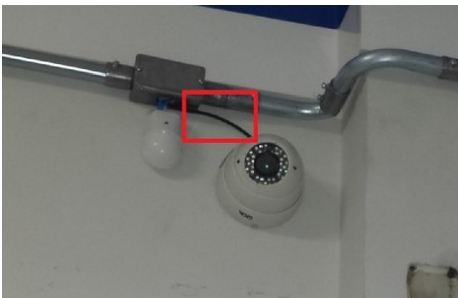
Figura 19 - Cabeamento exposto da câmera interna (INCORRETO)
