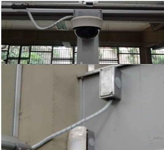
Figura 16 – Não é permitida prolongamentos extensos com espirais/espaguete (INCORRETO)
