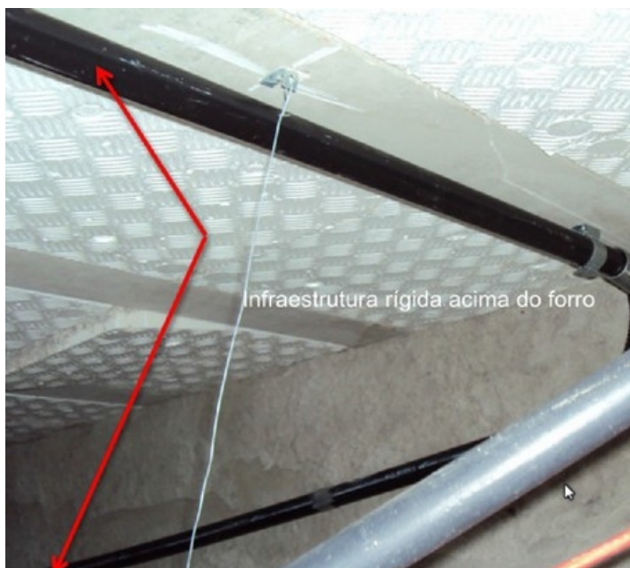
Figura 15 - Eletrodutos rígidos de PVC, exclusivos para o sistema de vigilância, sobre o forro (CORRETO)
