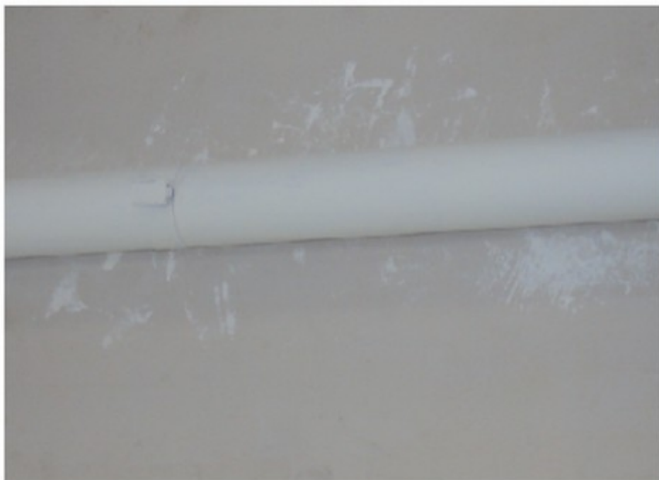
Figura 8 - infraestrutura aparente mal pintada
