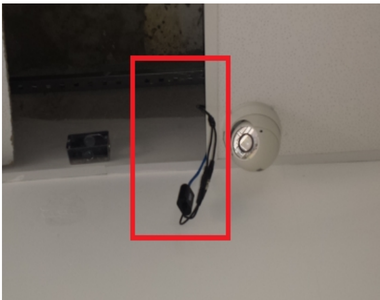
Figura 6 - Balun da câmera solto sobre o forro (INCORRETO)
