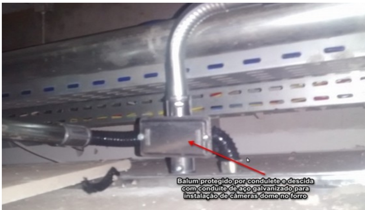
Figura 7 - Conectores sobre o forro devem estar protegidos dentro do condute (CORRETO)
