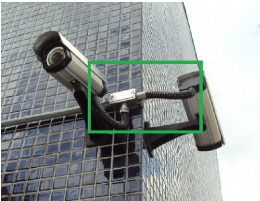
Figura 20 - Cabeamento protegido com Sealtube (CORRETO)
