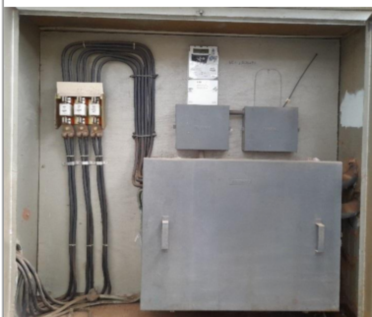
Fig. 3 - Caixa de medição (QM1)
