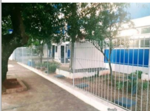
Fig. 5 - Entrada de energia - fundos do abrigo em alvenaria.
