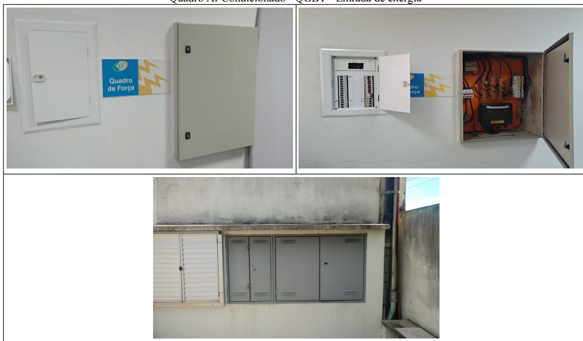
Quadro Ar Condicionado - QGBT - Entrada de energia
