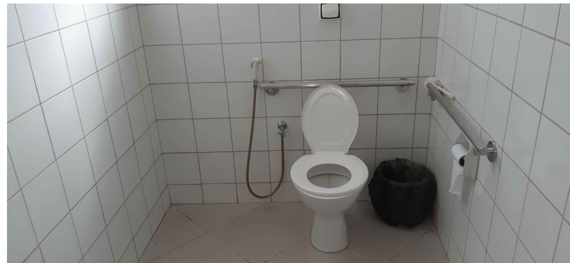
FOTO 15 - BARRAS DE APOIO RETIRAR - (BH. ACESSÍVEL)
