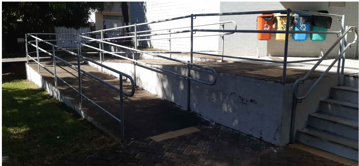
FOTO 10 - GUARDA CORPO / CORRIMÃO EXISTENTE RETIRAR - (RAMPA)
