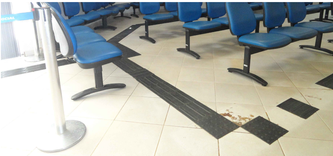
FOTO 13 - SINALIZAÇÃO - PISO TÁTIL EXISTENTE RETIRAR E RECOMPOR - (VER PROJETO)
