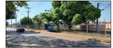
FOTO 7 - Retirar o piso intertravado (paver), meio-fio e sarjeta em toda extensão do passeio público existente. (Avenida Imigrantes).
