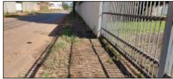
FOTO 5 - Retirar o piso existente (paver), o meio-fio e a sarjeta. (Travessa Ismael Nery).
