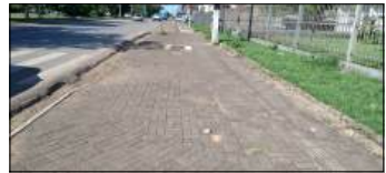
FOTO 3 - Retirar o rebaixamento do meio-fio (rampa), guia e sarjeta existentes e equalizar os níveis entre o leito carroçável (asfalto) e o passeio público.
