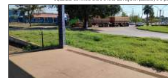
FOTO 1 - Retirar piso tátil existente (concreto) e recompor com nova paginação conforme projeto.
