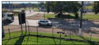
FOTO 2 - Retirar o piso intertravado (paver), meio-fio e sarjeta em toda extensão do passeio público existente.
