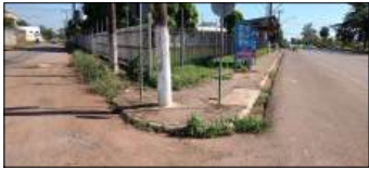
FOTO 4 - Retirar o rebaixamento do meio-fio (rampa), guia e sarjeta existentes e equalizar os níveis entre o leito carroçável (asfalto) e o passeio público.
