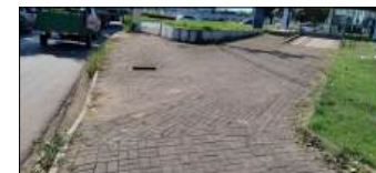
FOTO 6 - Retirar o rebaixamento do meio-fio (rampa), guia e sarjeta existentes e equalizar os níveis entre o leito carroçável (asfalto) e o passeio público.
