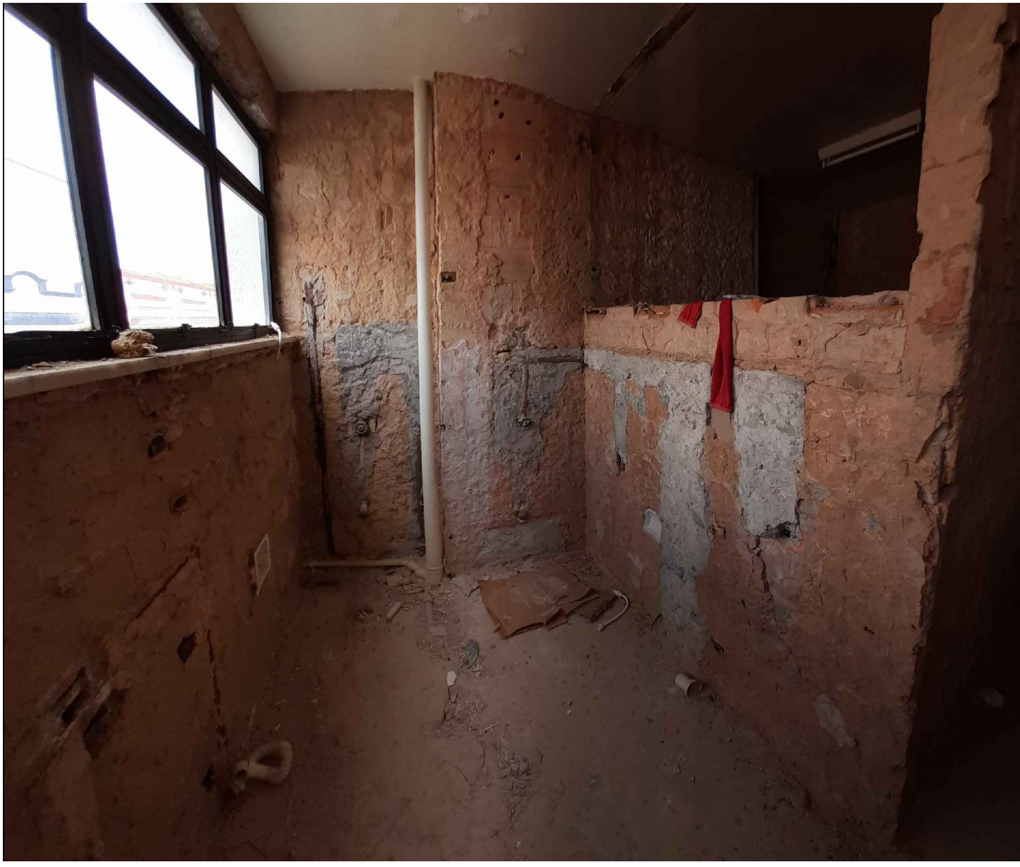
DETALHE - FOTO 2 VISTA ATUAL SANITÁRIO FEMININO - 1º PAVTº
