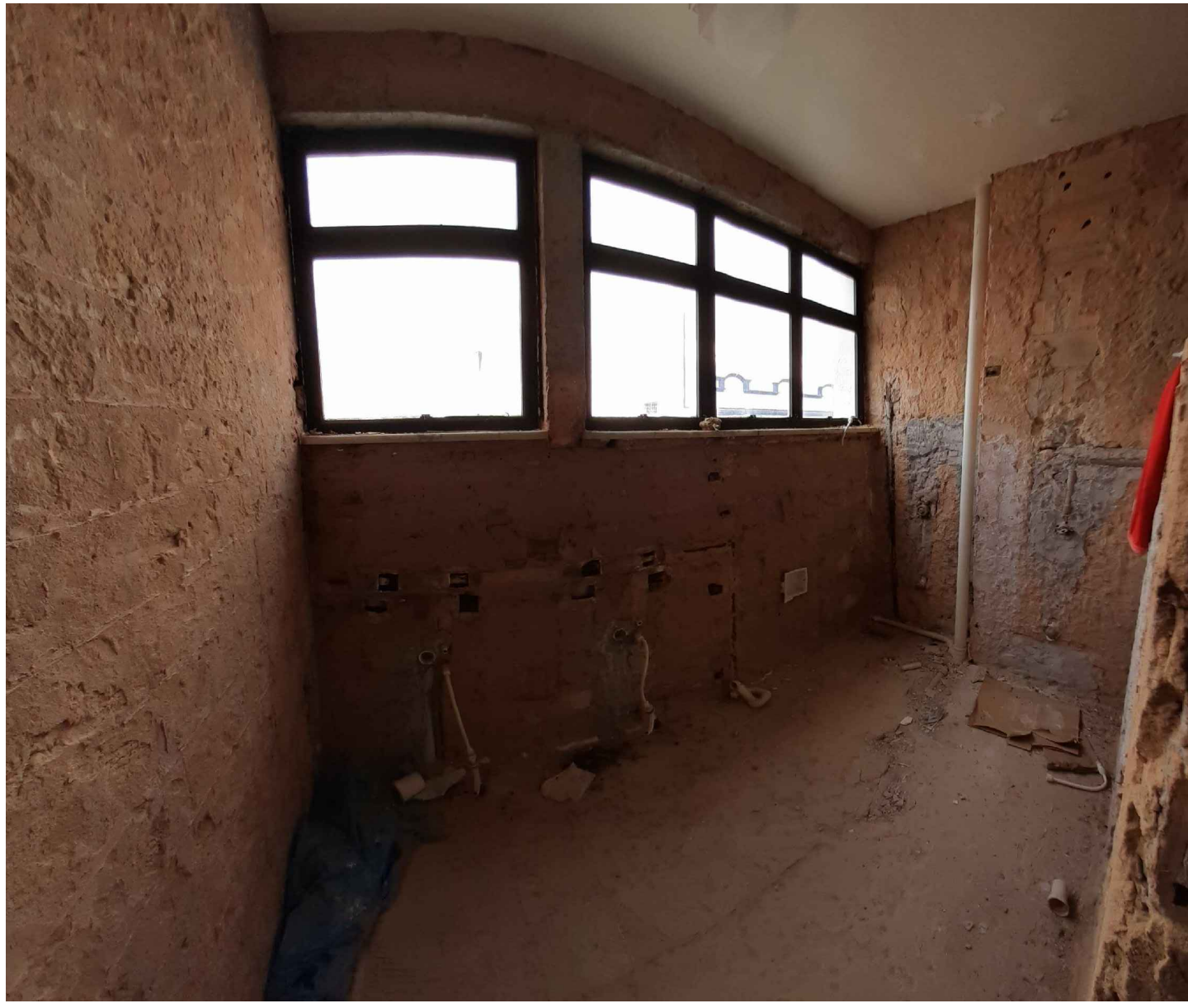
DETALHE - FOTO 1 VISTA ATUAL SANITÁRIO FEMININO - 1º PAVTº
