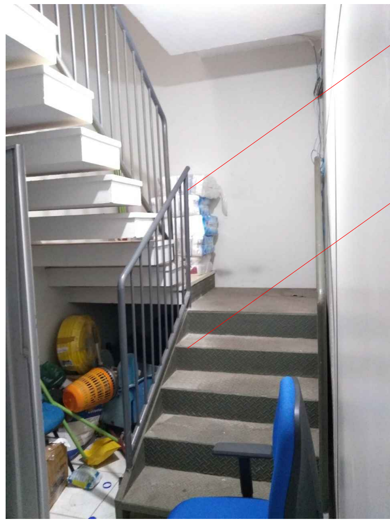
FOTO - Detalhe Escada Anexo
