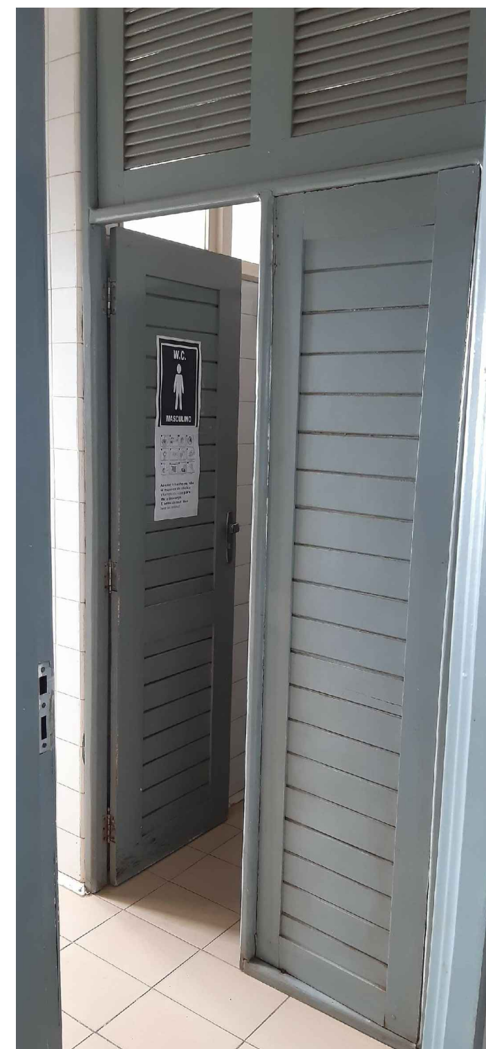
DETALHE - FOTO 4 Bh. Masculino - 3º Pavimento
