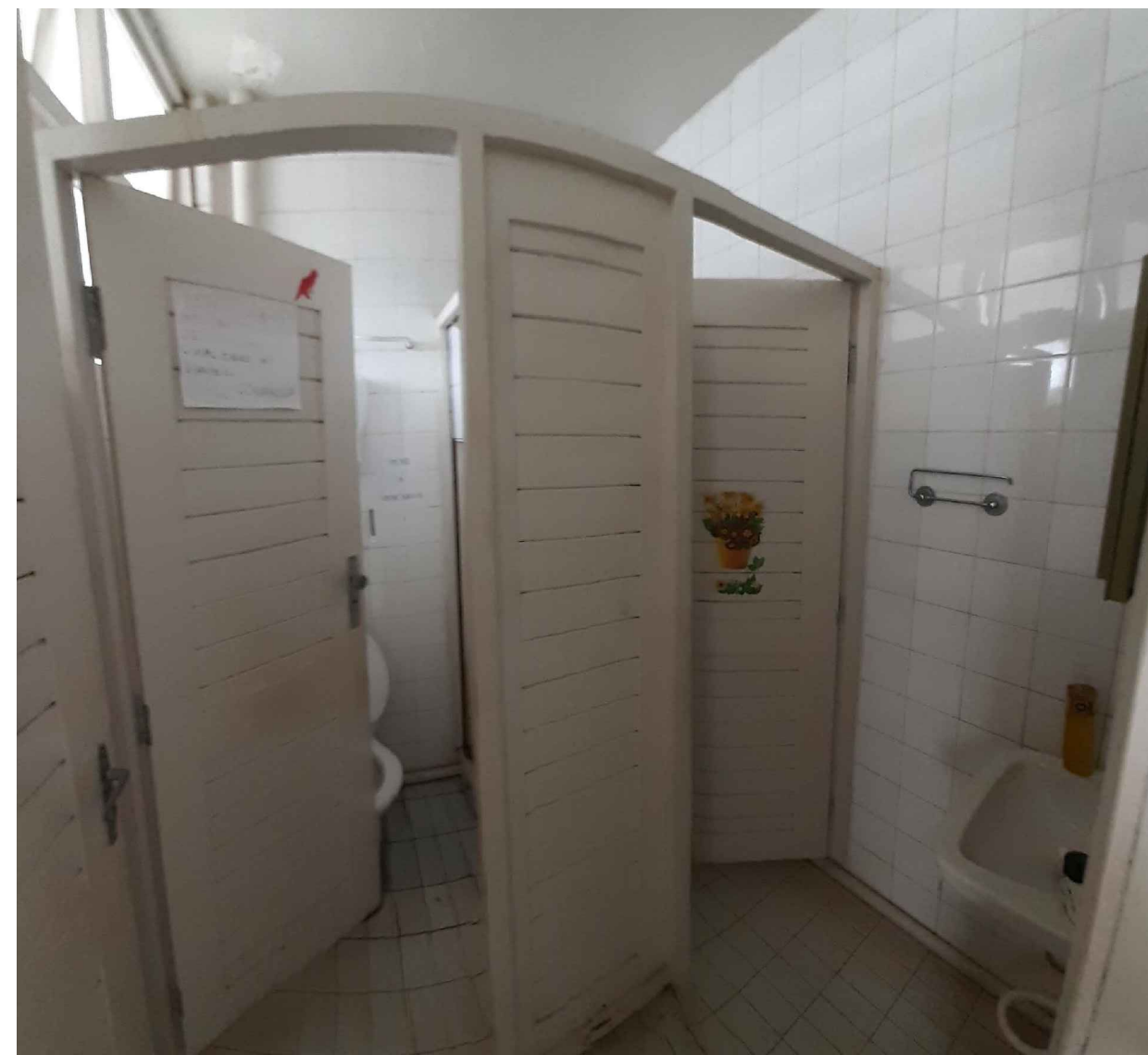
DETALHE - FOTO 1 Bh. Masculino - 2º Pavimento
