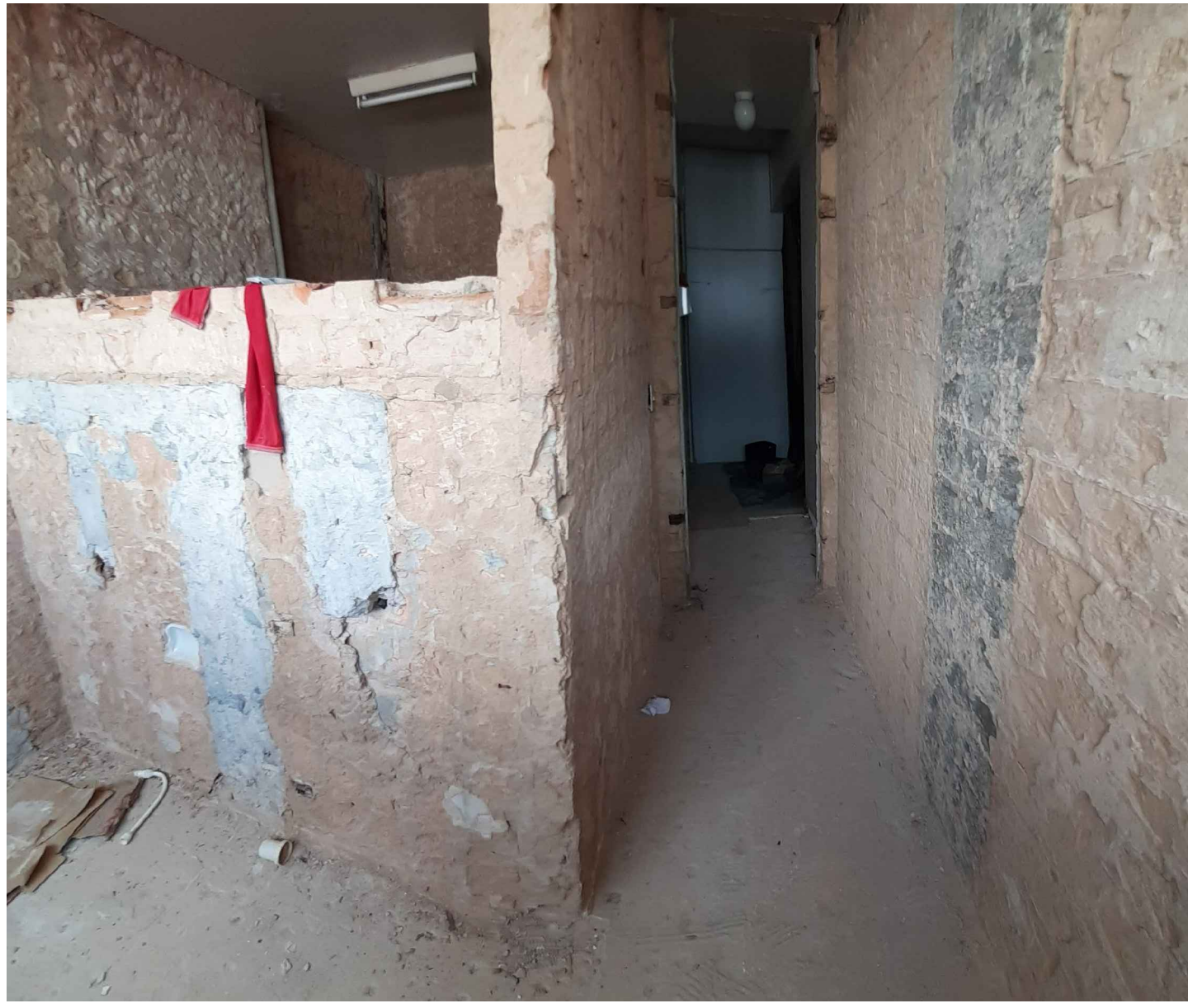
DETALHE - FOTO 3 VISTA ATUAL SANITÁRIO FEMININO - 1º PAVTº
