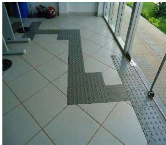
Detalhes dos pisos táteis externo e interno
