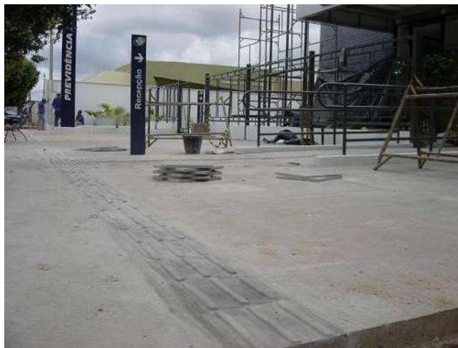
Detalhes dos pisos táteis externo e interno
